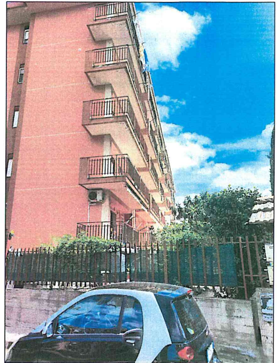
Foto 4-5 - Vista dei prospetti con affacci su via Falcone e su area privata a verde. Le facciate si trovano in buono stato conservativo, ad eccezione dei balconi e del cornicione (con lieve degrado) che necessitano di manutenzione.
