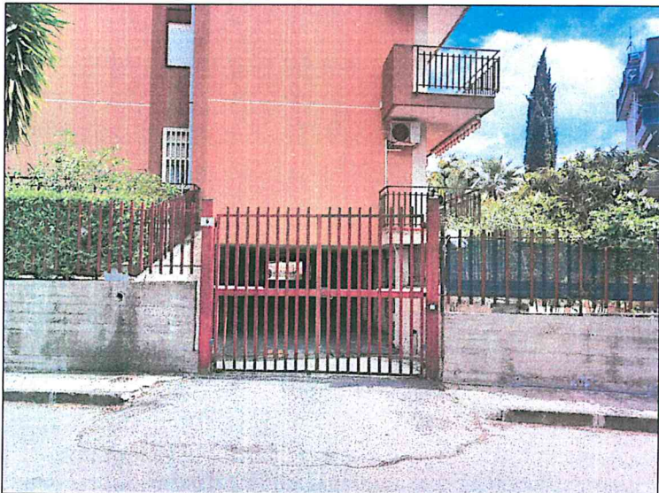
Foto 16 - Foto dell'ingresso carrabile da via Falcone n. 6 (con cancello automatico), ai garage siti a piano seminterrato.
