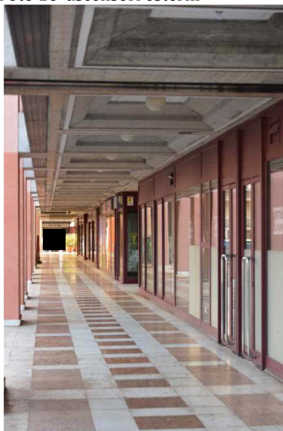
Foto 18 Galleria livello Via Colombo
