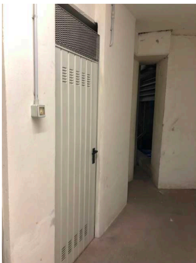
Foto n. 42 corridoio e ingr.cantina sub 403
