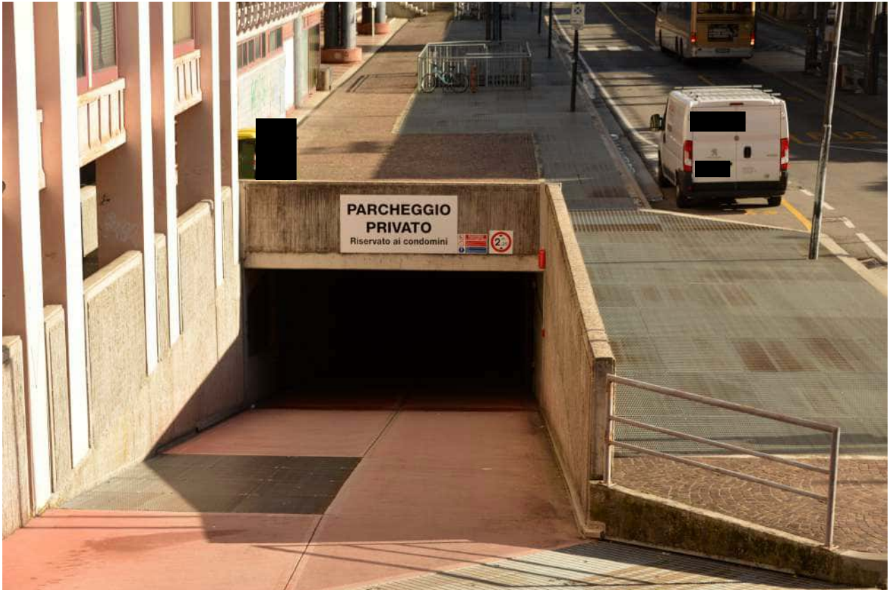
Foto n. 35 rampa di accesso piani sottostrada e garage
