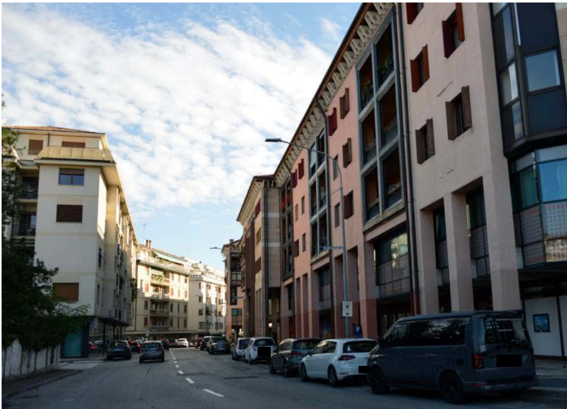
Foto n. 2 Via Cristoforo Colombo
