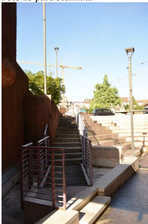
Foto n. 17 Part. arena e scale lato
