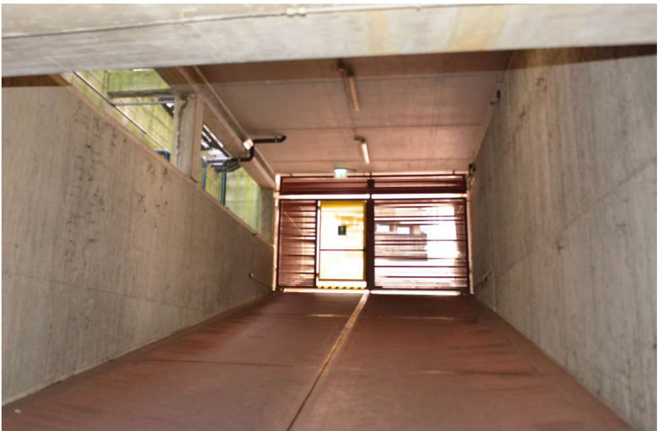
Foto n. 36 rampa di accesso piani sottostrada e garage
