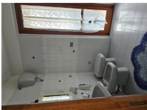
Uno dei bagni appartamento al piano primo
