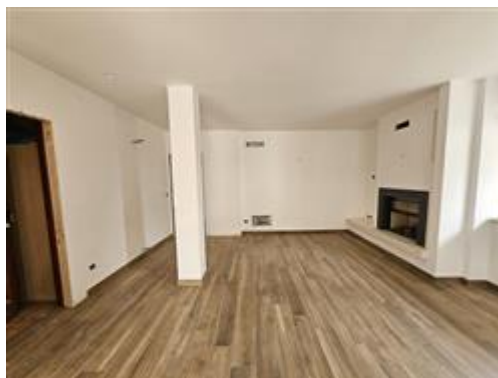
Appartamento in corso di realizzazione al piano terra
