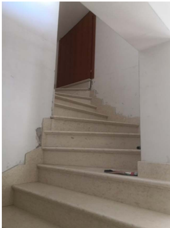
Vista ingresso sottotetto
