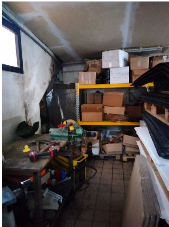
Foto n. 10 – vista magazzino foglio 9 p.la 51 sub 11– LOTTO 1
