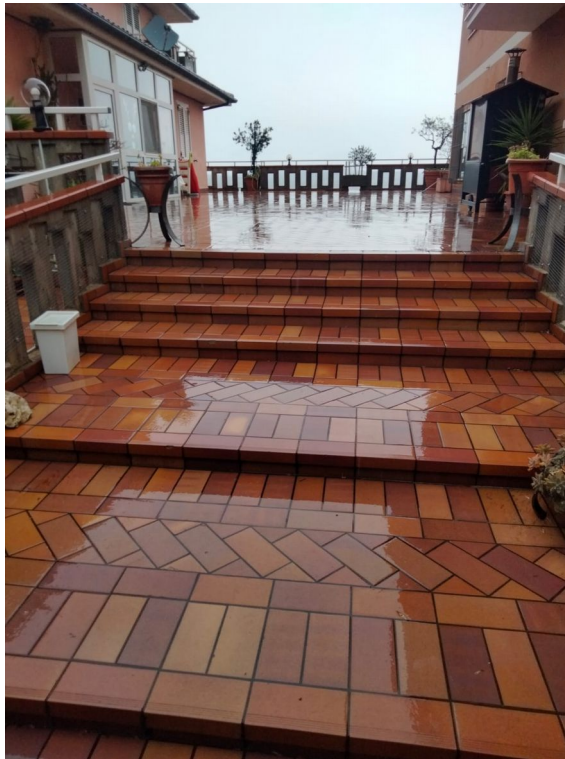
Foto n. 1 – vista lastrico foglio 9 p.lla 51 sub 6 – LOTTO 2
