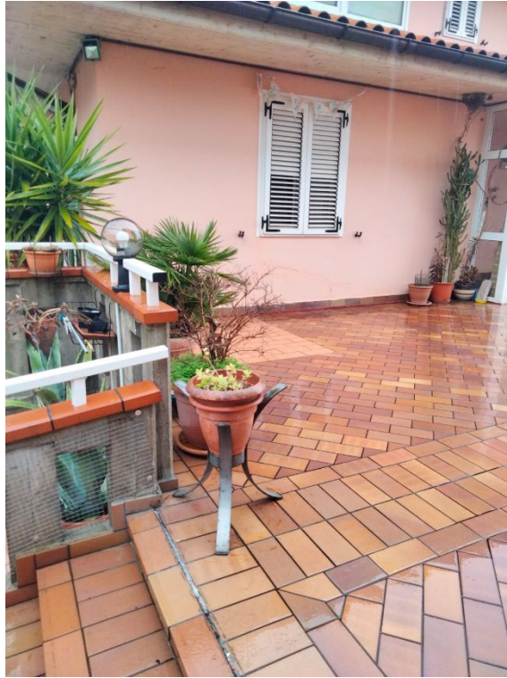
Foto n.15 – vista esterno fabbricato e parte di lastrico
