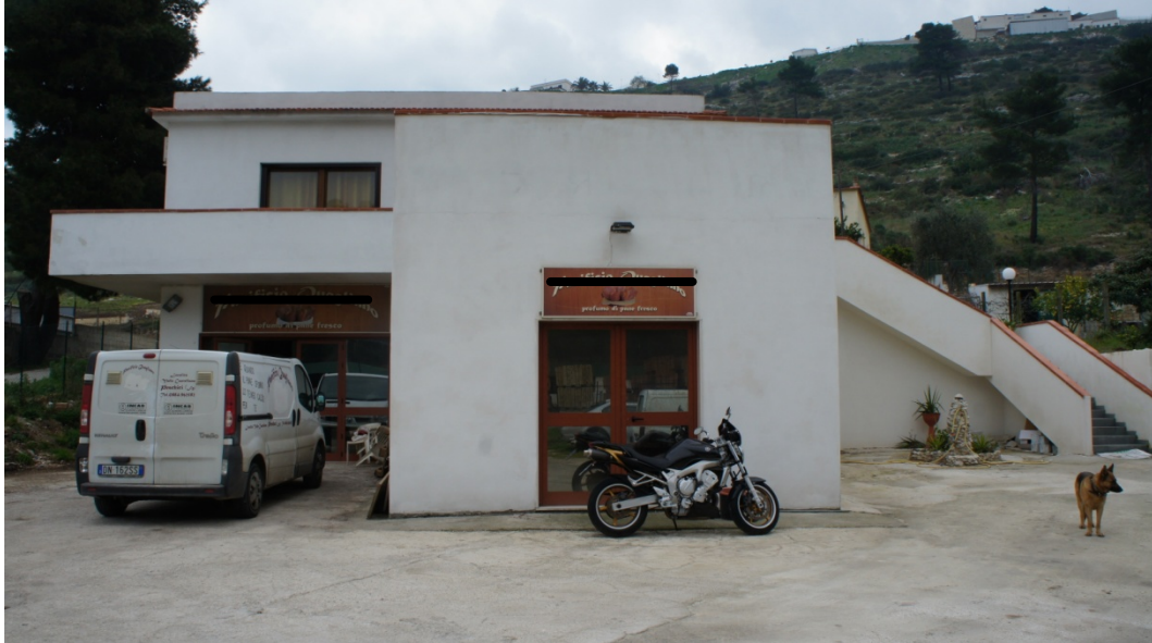
Figura 1: Vista esterna -prospetto sud
