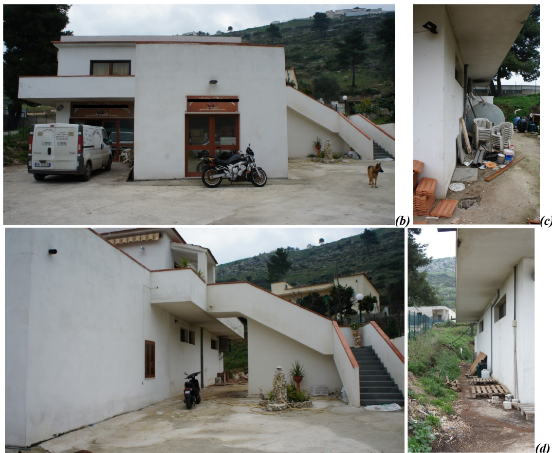
Figura n° 3. Fotografie del complesso edilizio sito in agro del Comune di Peschici alla contrada Valle Castellana estratte dai rilievi fotografici dell'arch. De Luca e scattate dal sottoscritto il 14 novembre 2023: area esterna di pertinenza (a) facciata principale con accessi al pianterreno (b); prospetto posteriore (c); prospetti laterali e scalinata di accesso al primo piano (d).
