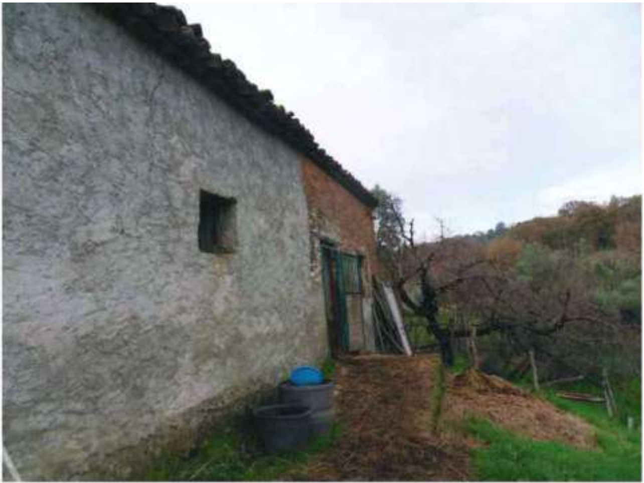
FOTO N. 139: Prospetto NORD – EST Bene N. 3
