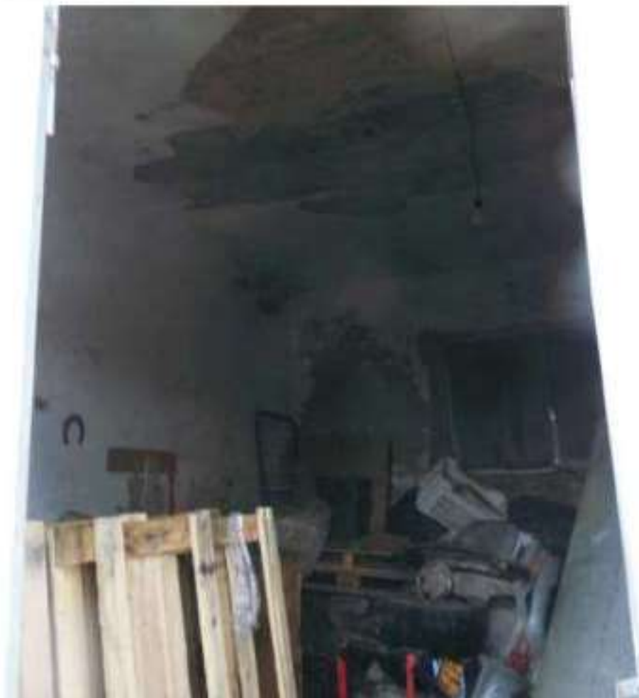
FOTO N. 124: Esterni Bene N. 2
