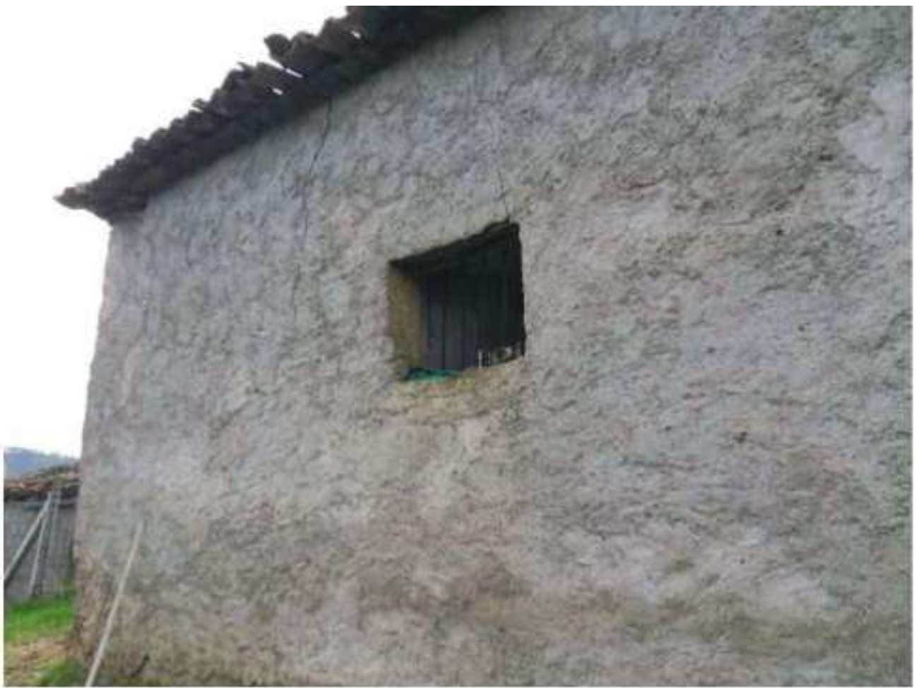
FOTO N. 147: Esterni Bene N. 3
