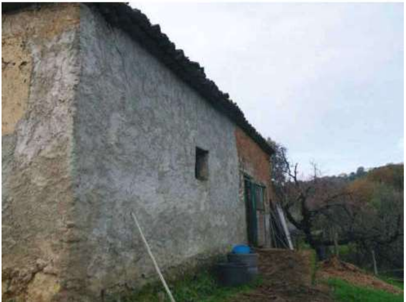
FOTO N. 148: Esterni Bene N. 3
