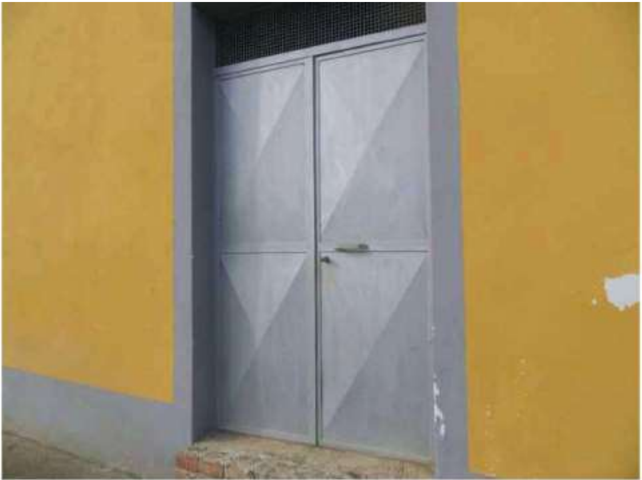
FOTO N. 123: Esterni Bene N. 2
