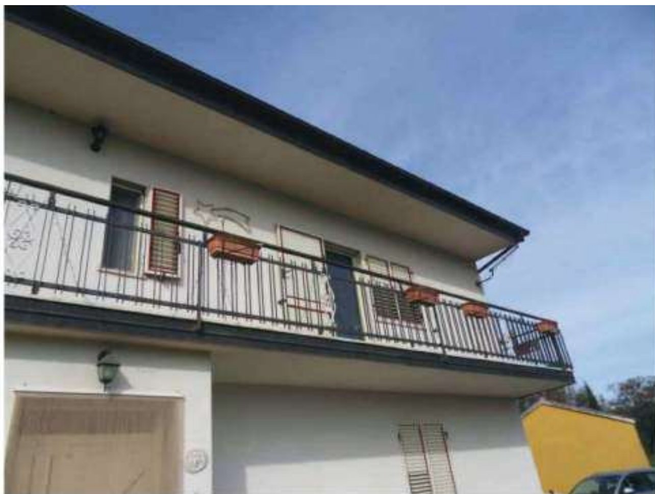
FOTO N. 7: Prospetto SUD - EST Bene N. 1
