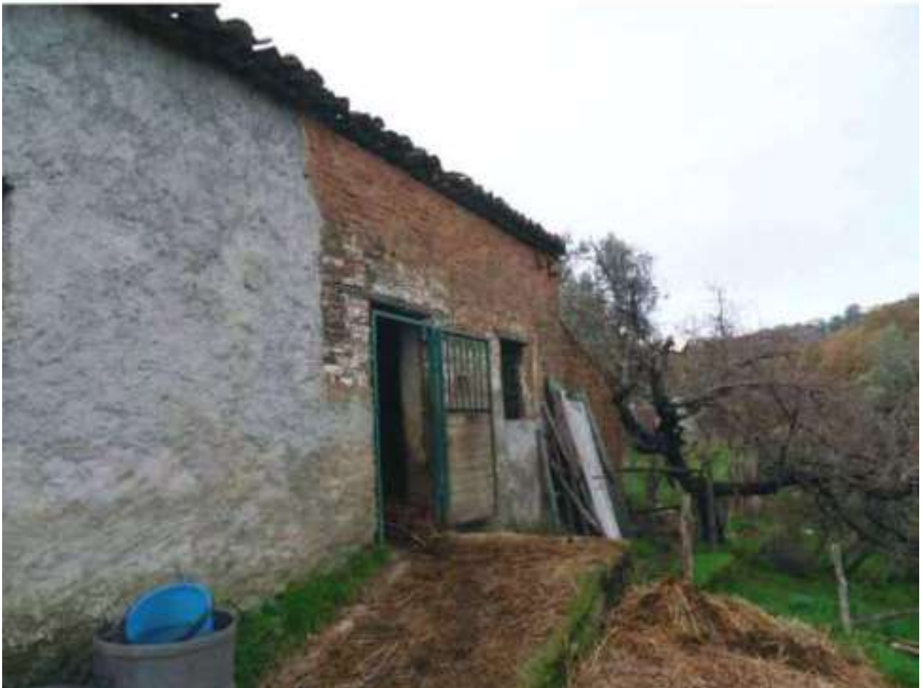
FOTO N. 140: Prospetto NORD – EST Bene N. 3
