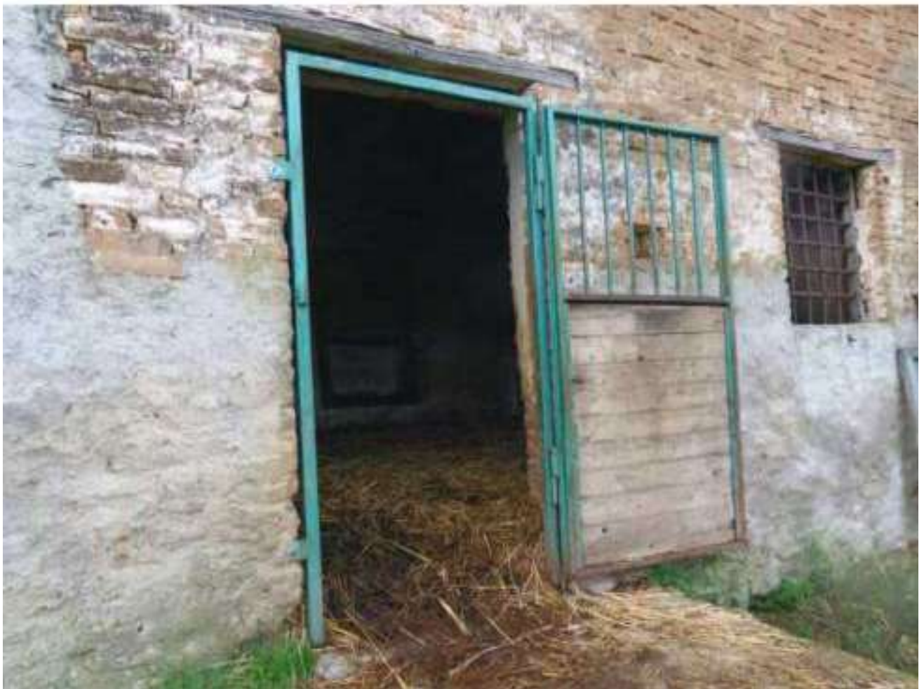
FOTO N. 144: Esterni Bene N. 3
