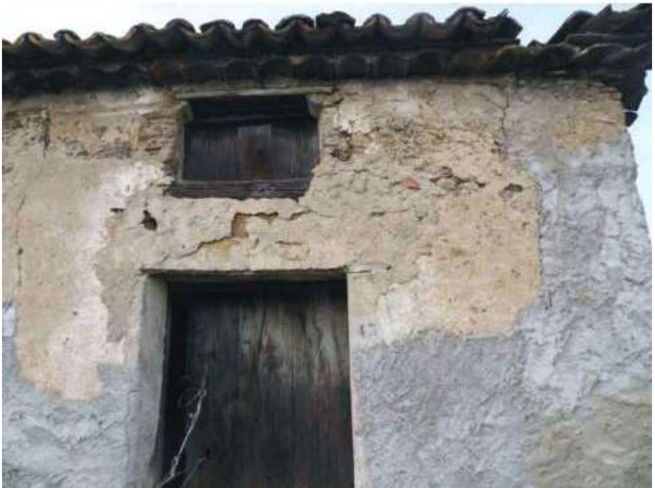
FOTO N. 150: Esterni Bene N. 3
