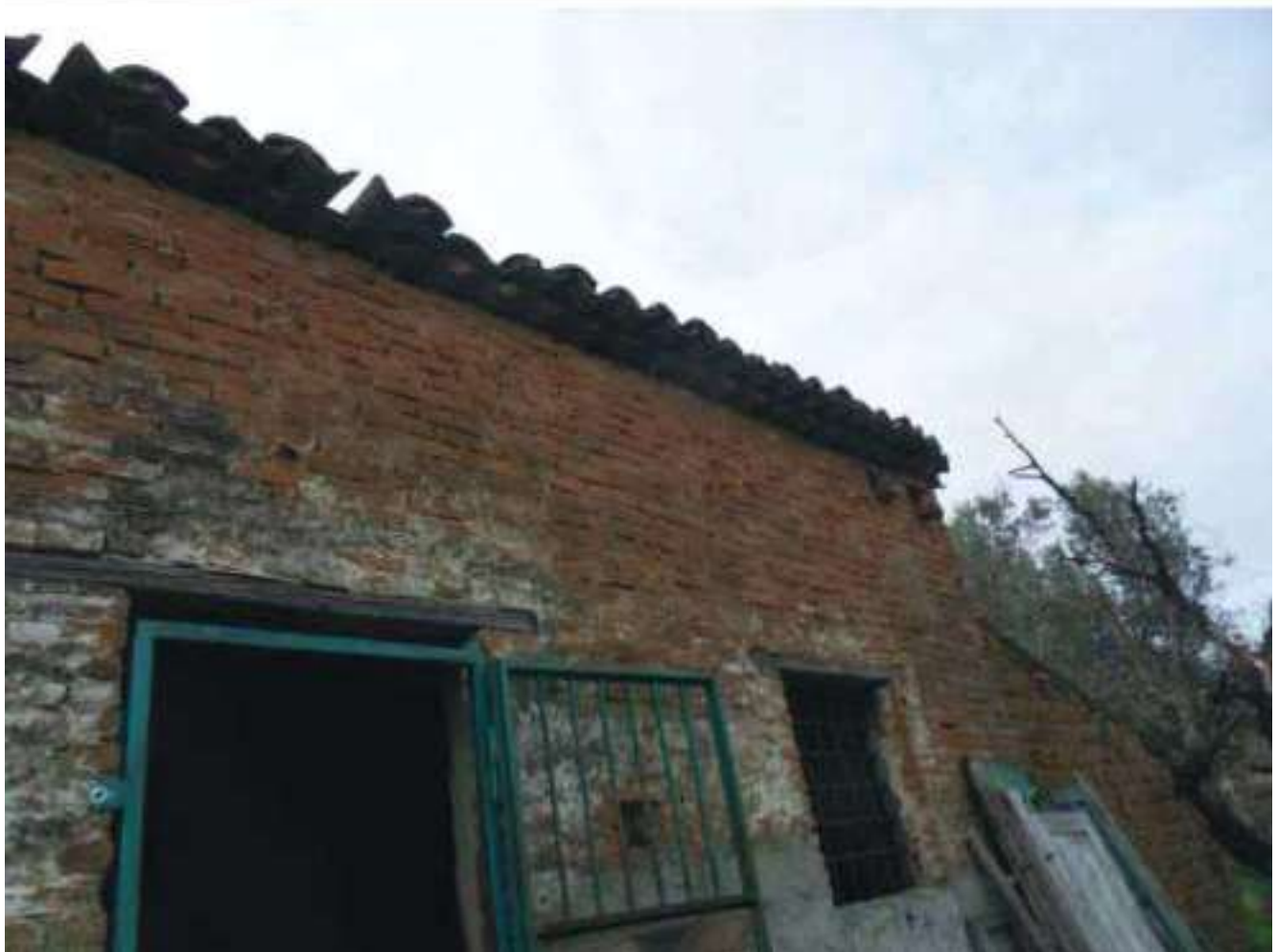
FOTO N. 146: Esterni Bene N. 3
