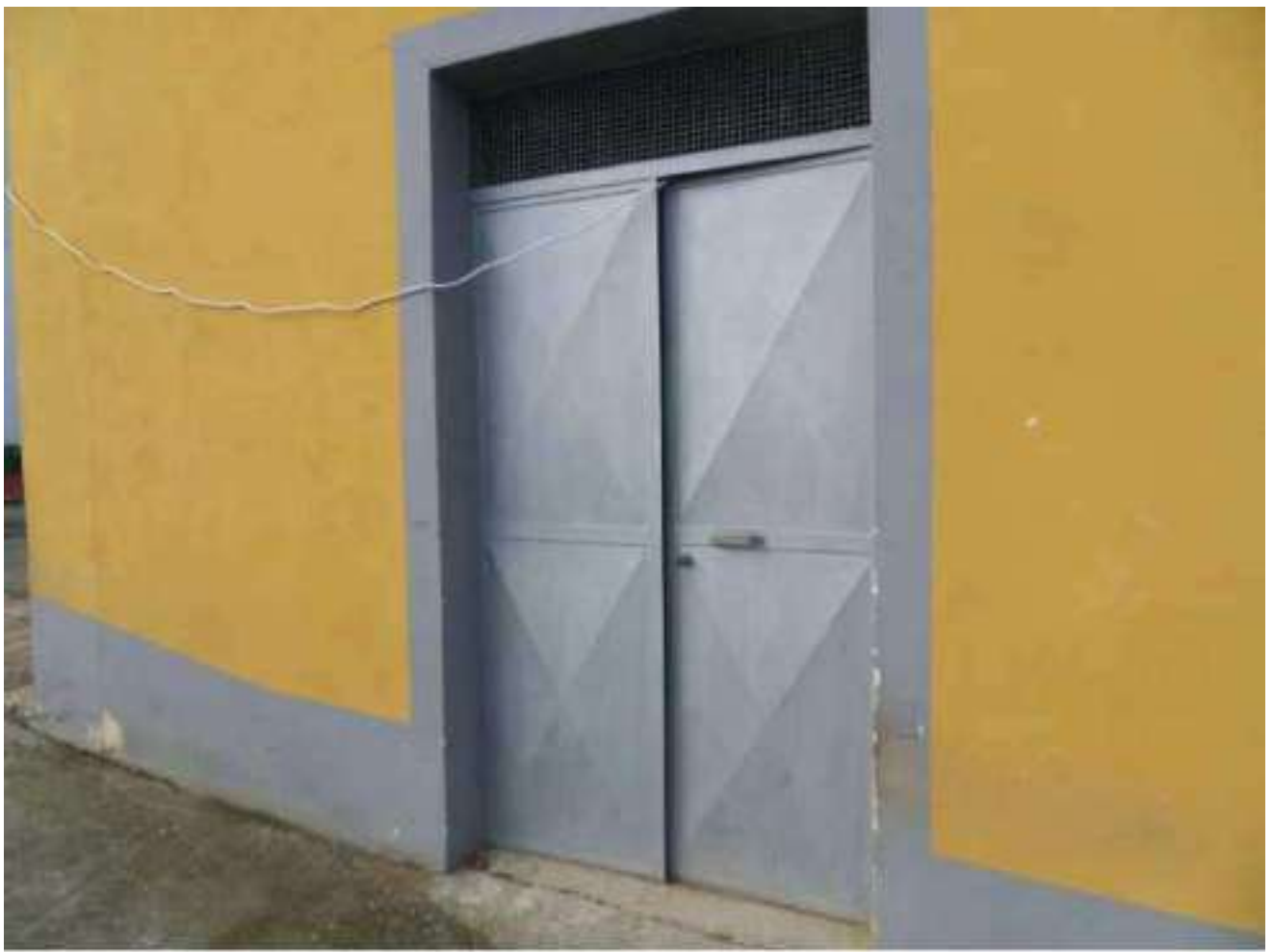
FOTO N. 129: Esterni Bene N. 2
