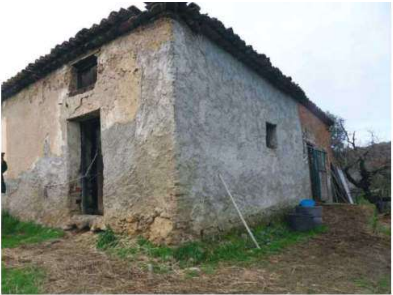
FOTO N. 149: Prospetto SUD – EST Bene N. 3
