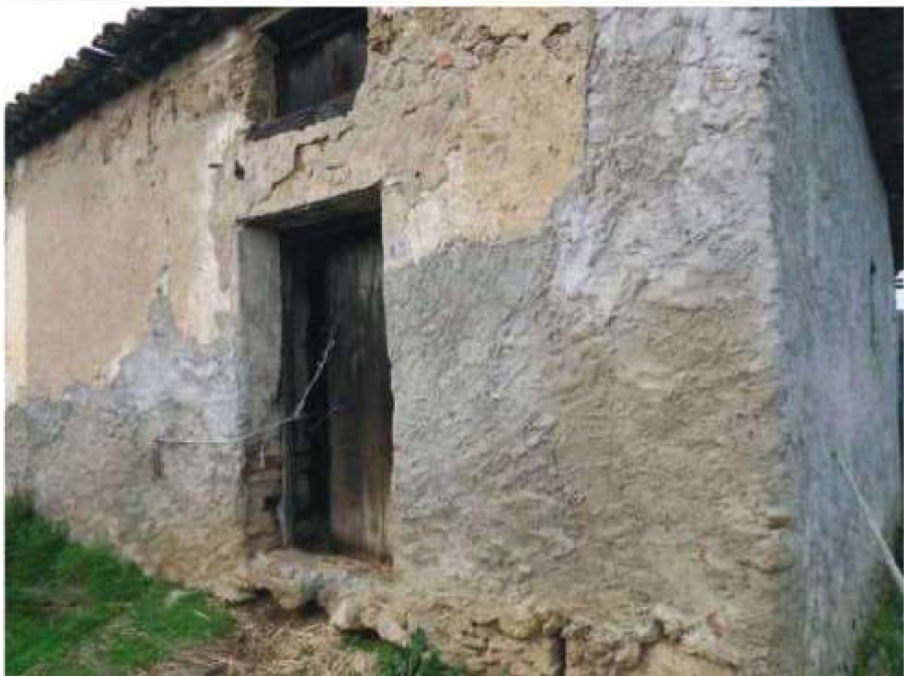
FOTO N. 138: Prospetto SUD – EST Bene N. 3
