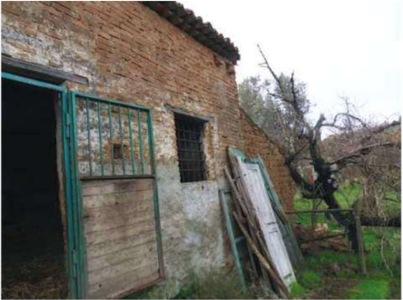
FOTO N. 145: Esterni Bene N. 3
