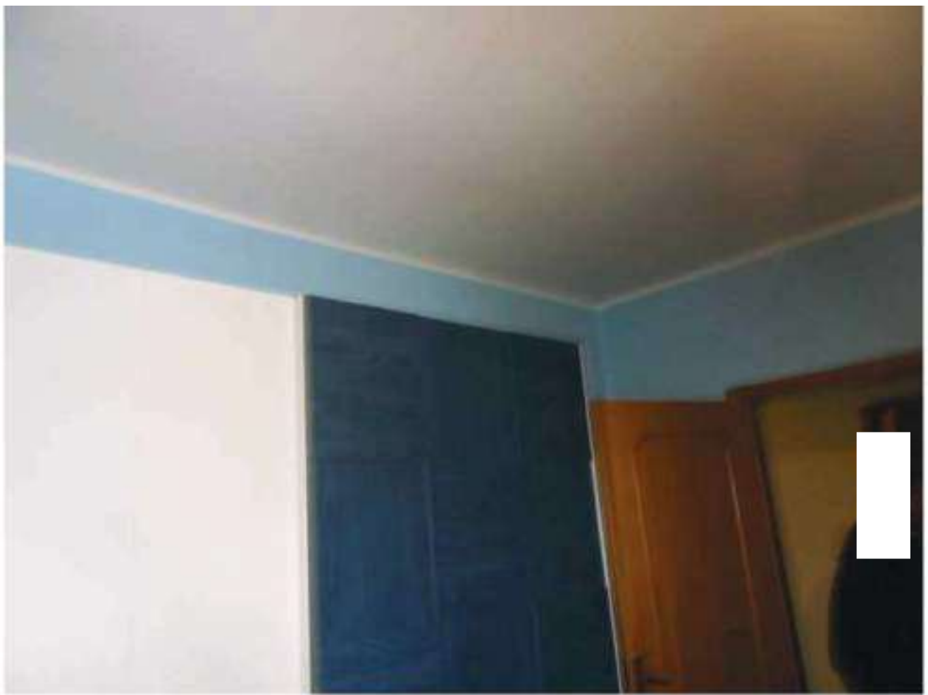
FOTO N. 109: Interni Bene N. 1 (PIANO PRIMO)
