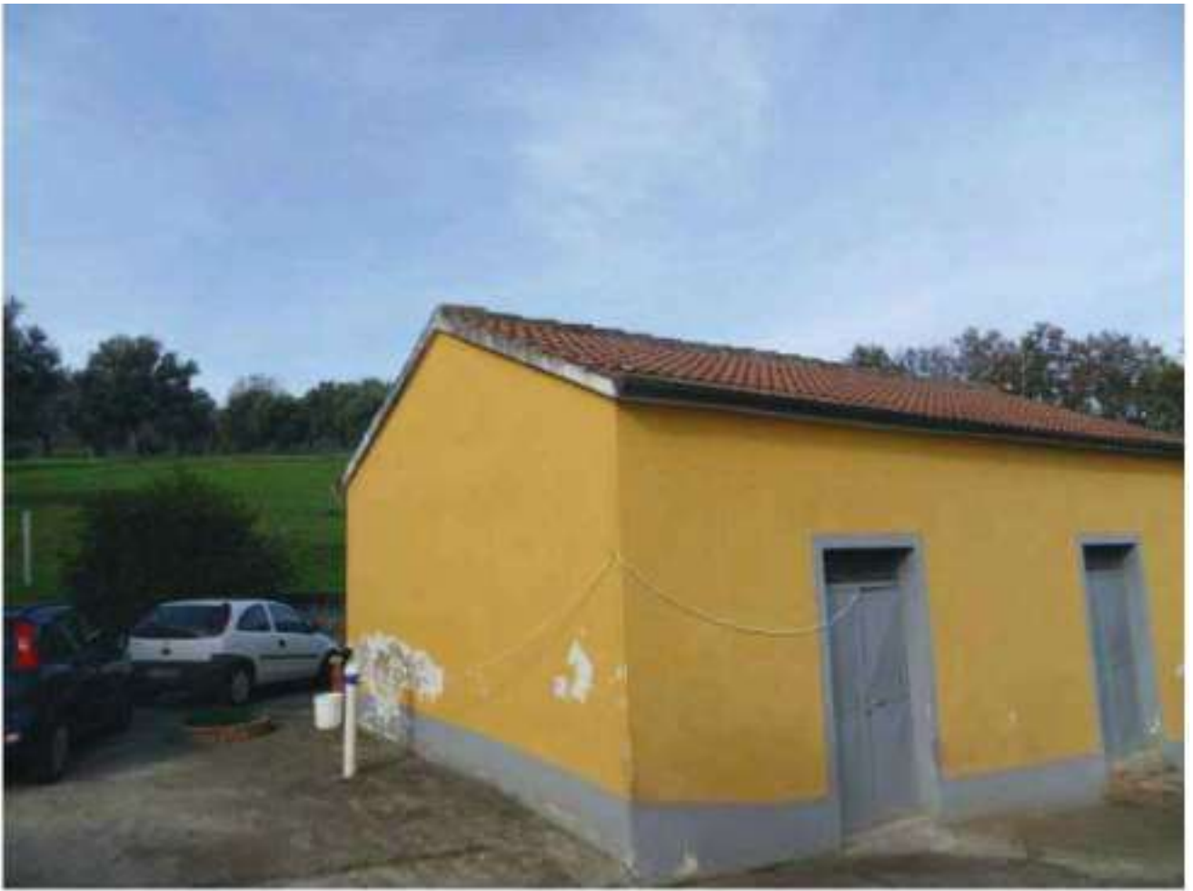
FOTO N. 119: Prospetto SUD - EST Bene N. 2
