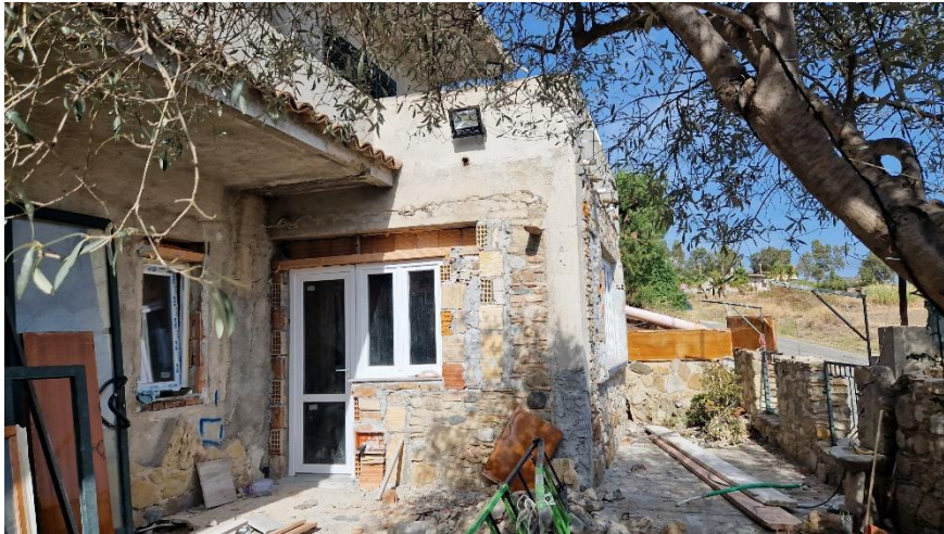
Foto n. 3 –prospetto lato est fabbricato sede delle unità pignorate –
