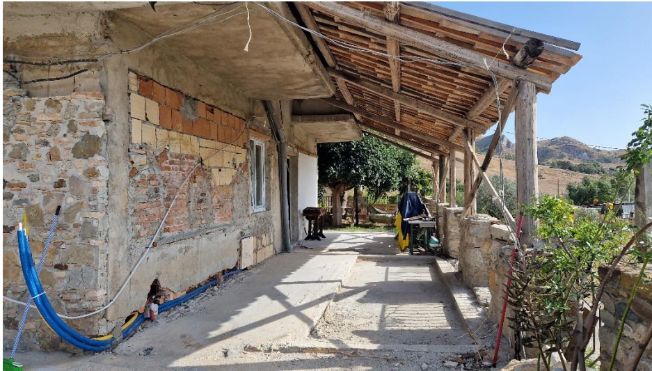
Foto n. 2 –prospetto lato sud fabbricato sede delle unità pignorate -
