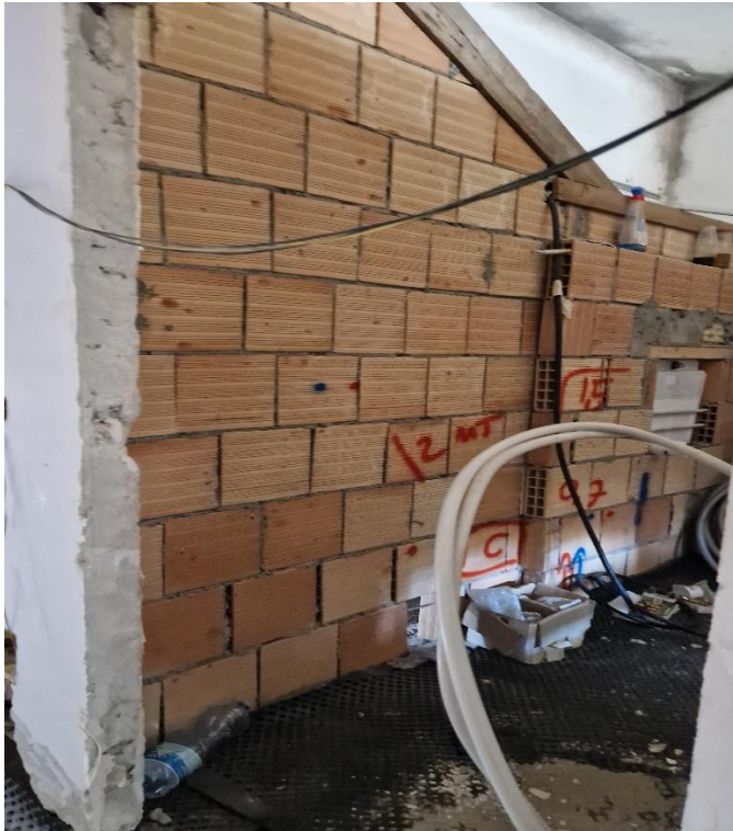
Foto n. 11 –interni unità sub 9-
