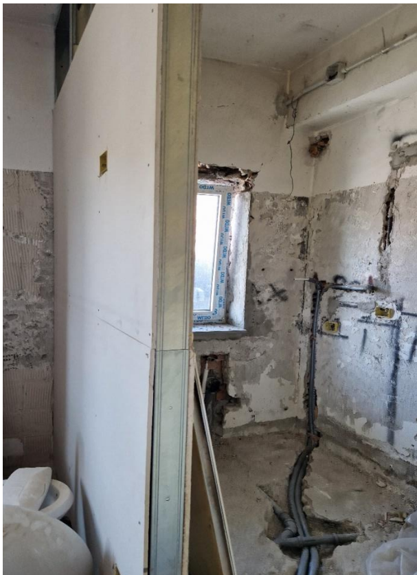
Foto n. 12 –interni porzione unità sub 10-
