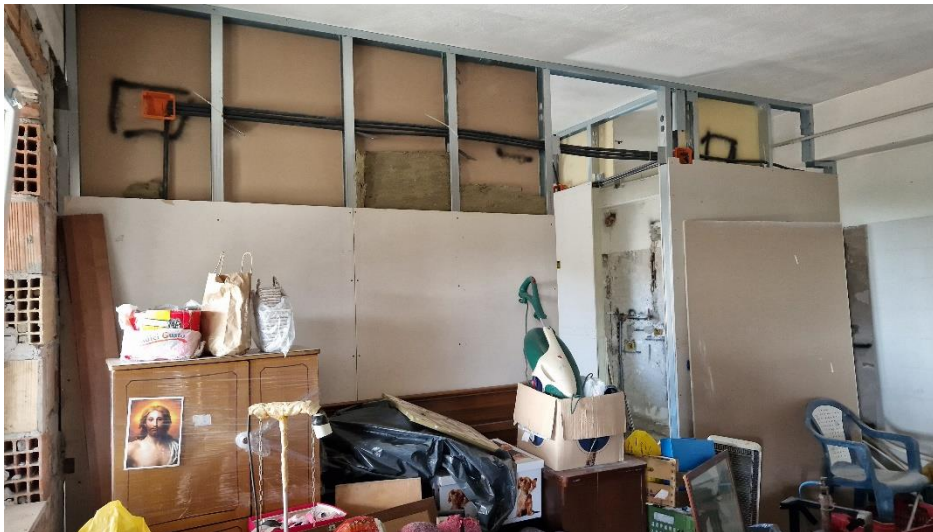
Foto n. 14 –interni porzione unità sub 10- tipologia pareti divisorie -
