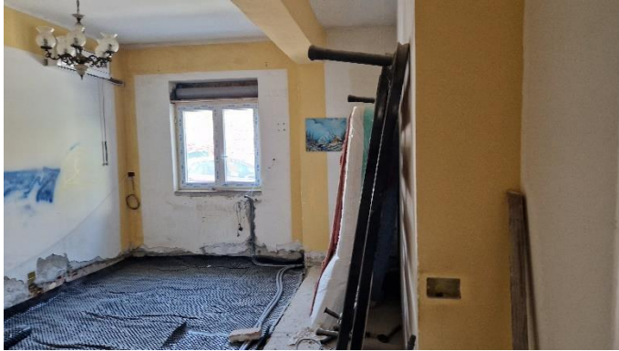
Foto n. 8 –interni unità sub 9-
