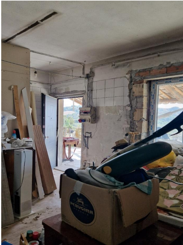
Foto n. 13 –interni porzione unità sub 10-
