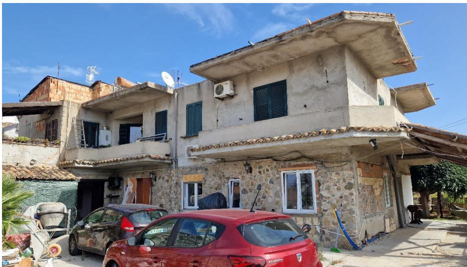
Foto n. 1 –prospetto lato sud fabbricato sede delle unità pignorate –
