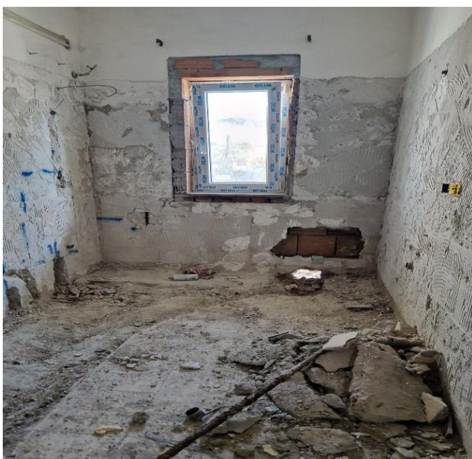
Foto n. 7 –interni unità sub 9-
