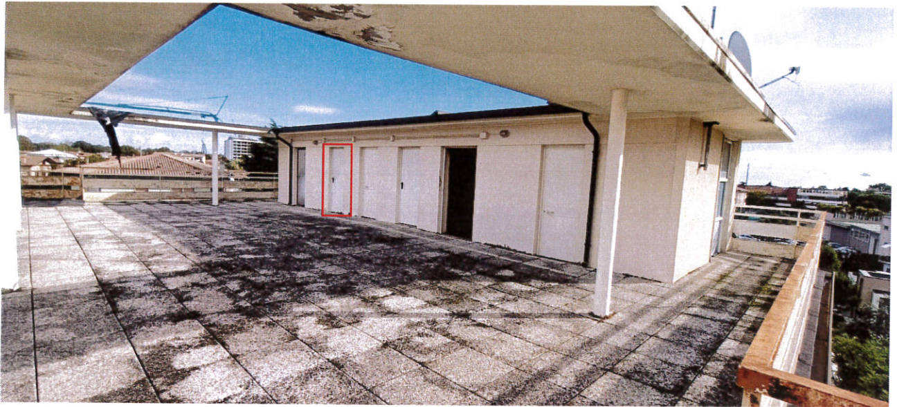
Foto n. 12 terrazza comune piano terzo
