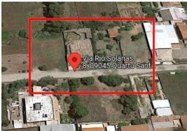
Foto 1 – Casa indipendente via Rio Solanas n. 08
