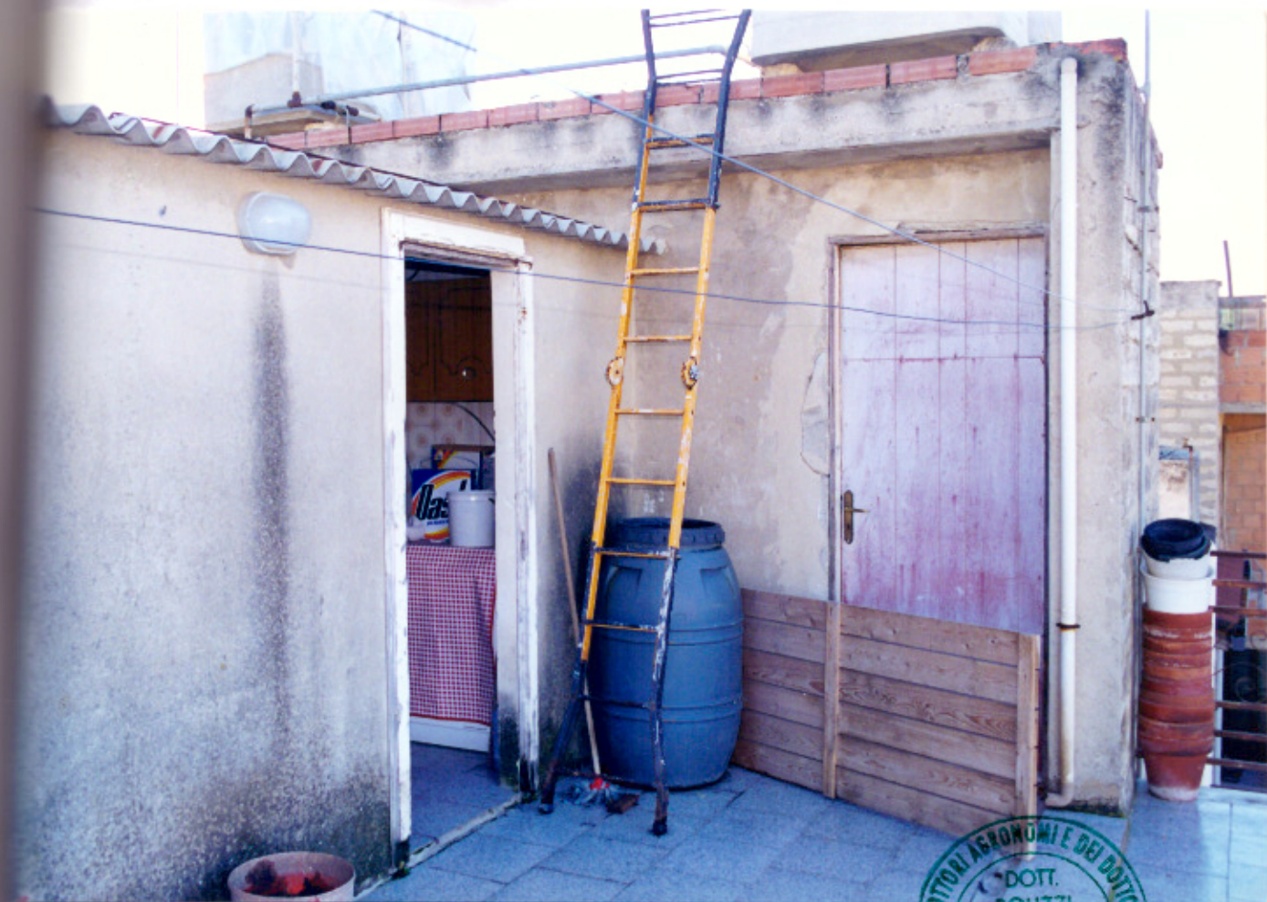
Foto N°11 – 3° piano – lastrico solare e vano ripostiglio
