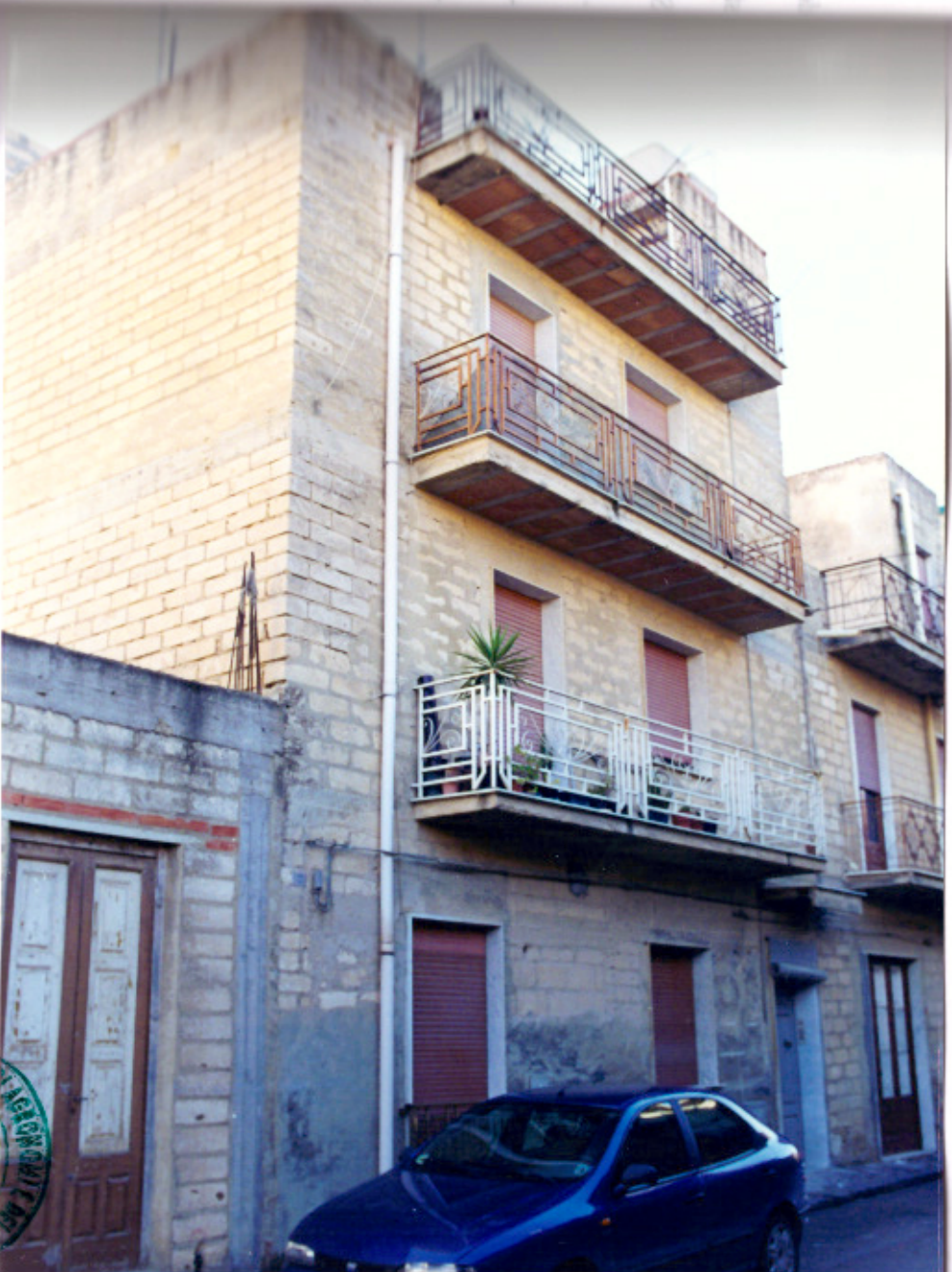
Foto N°1 – Prospetto immobile Via Alcide De Gasperi n.22-24
