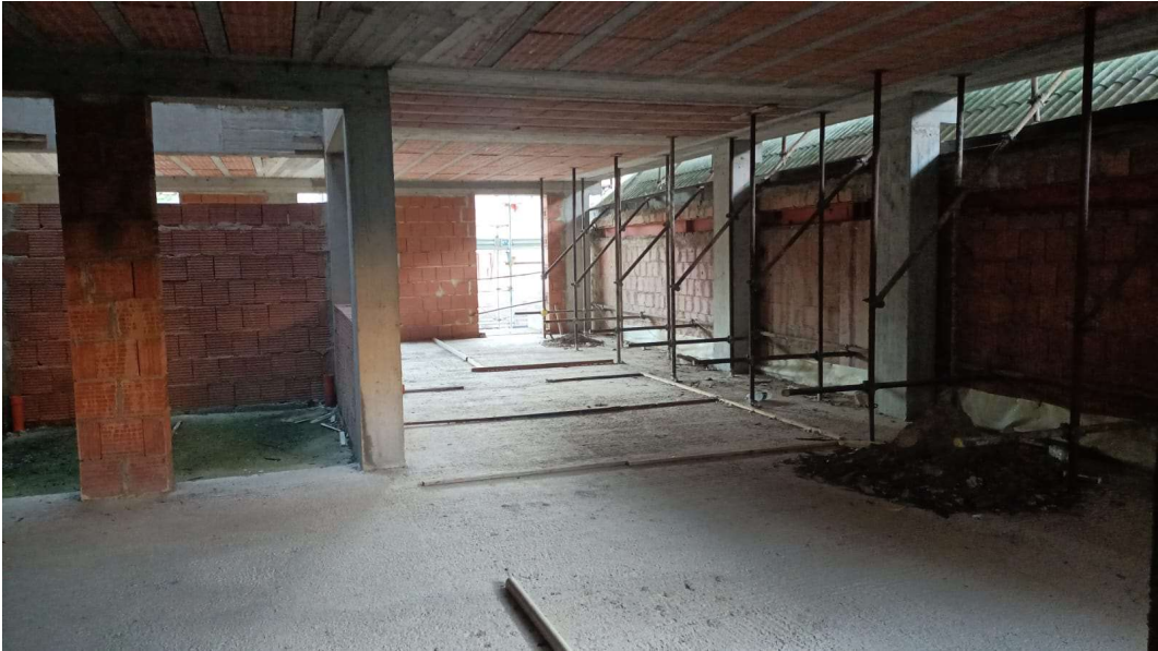
VISTA INTERNA LOTTO N. 4
