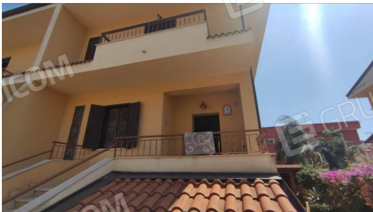
Foto n° 4: Ingresso principale unità immobiliare
