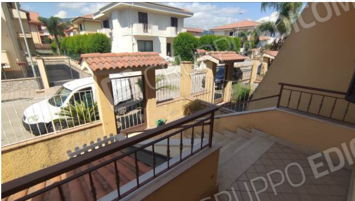
Foto n° 1: Via dei Sanniti, n°25 – accesso pedonale
