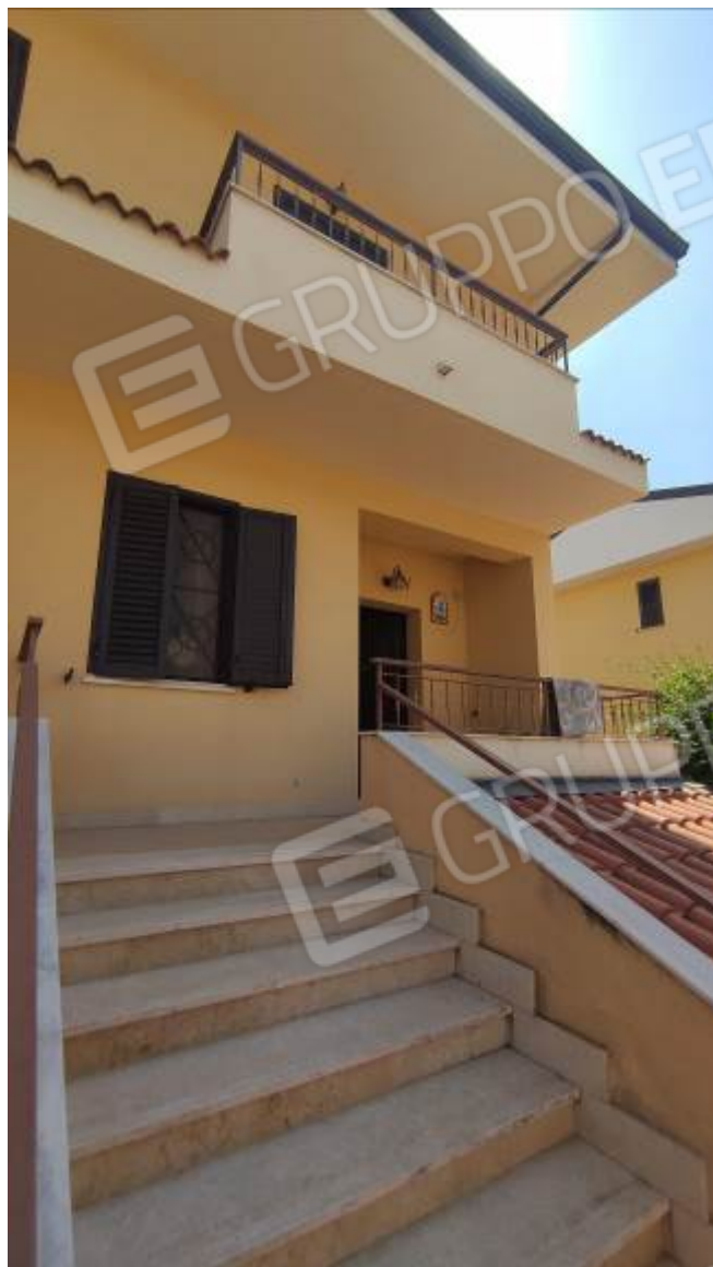
Foto n° 3: Ingresso principale unità immobiliare
