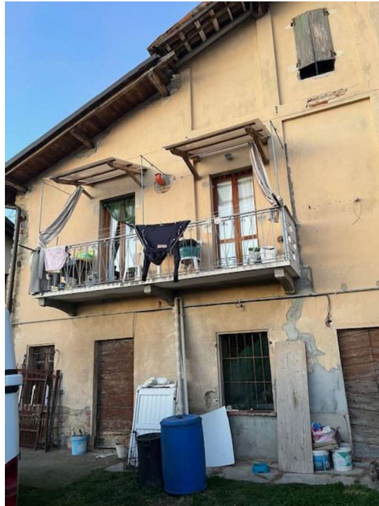
Esterno F.7 n.38 sub 3 e sub 4
