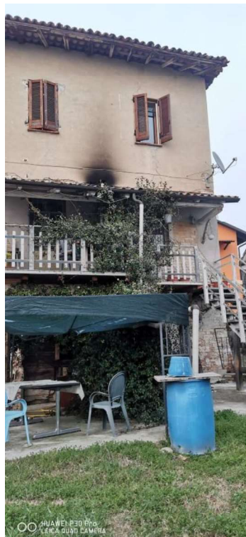
Esterno Soppalco lato soggiorno e scala esterna
