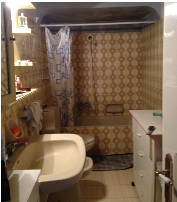
Foto 07: Vista bagno posto a piano primo.
