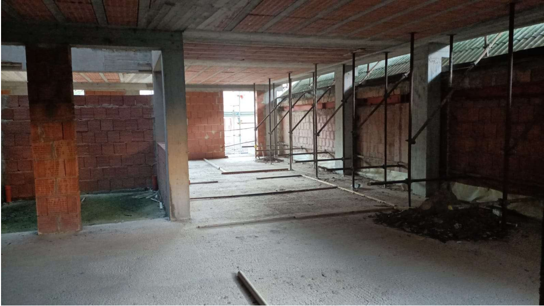
VISTA INTERNA LOTTO N. 8
