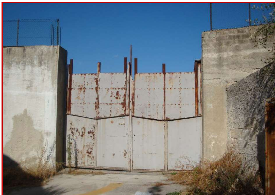
FOTO 3 - Prospetto sud ovest- apertura carrabile
