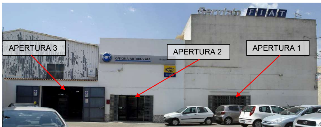
FOTO 1 - Prospetto nord est
