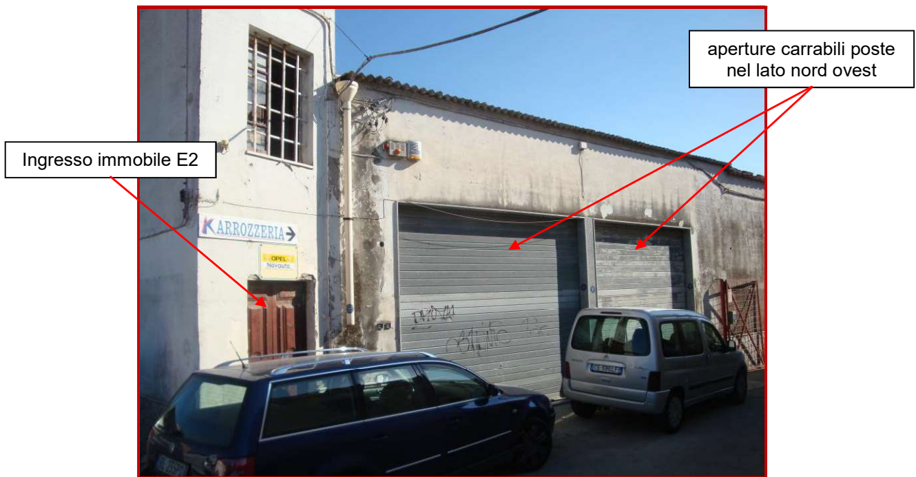
FOTO 2 - Prospetto nord ovest
