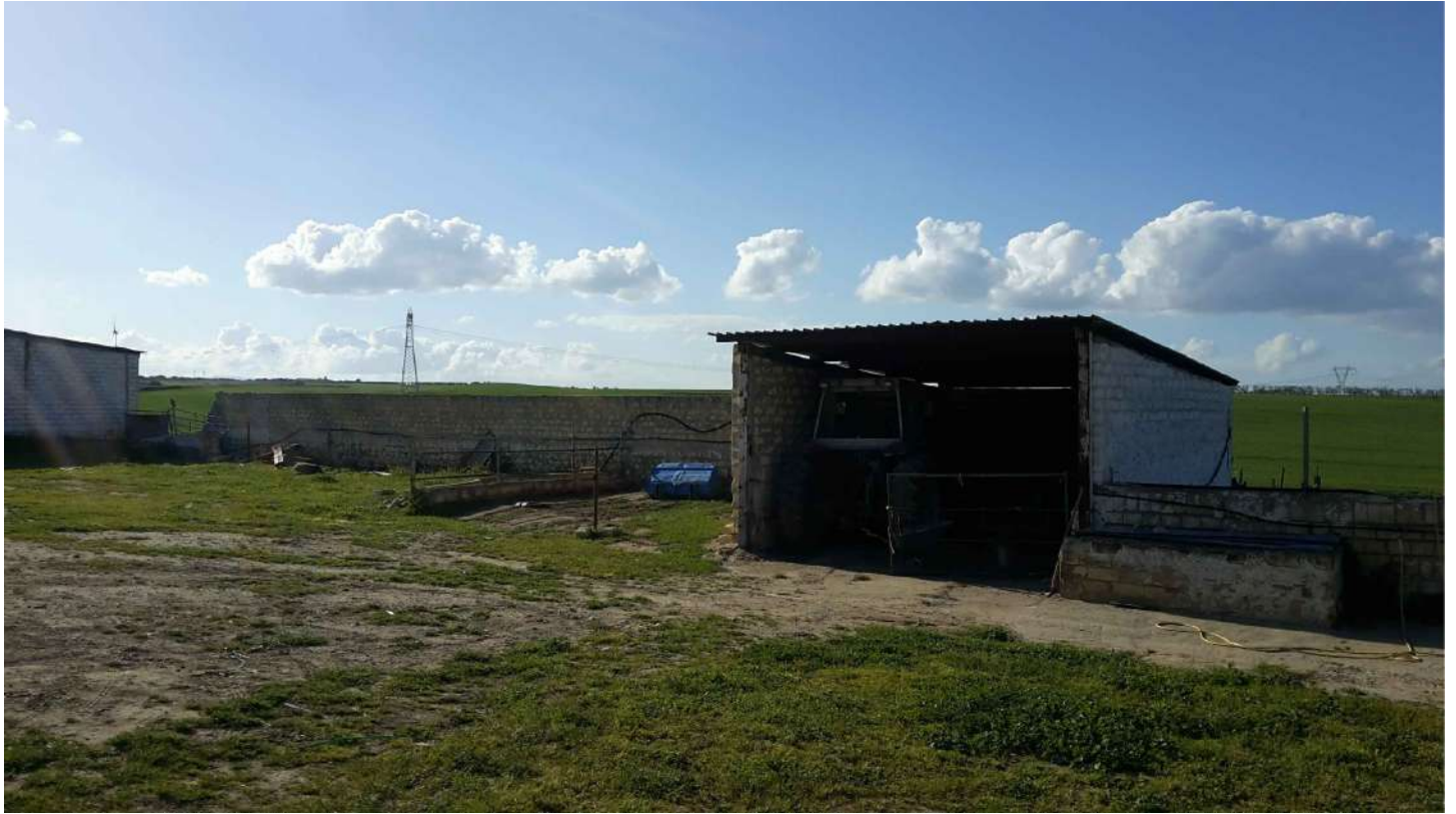
FOTO 1 - Corpo E1: tettoia
