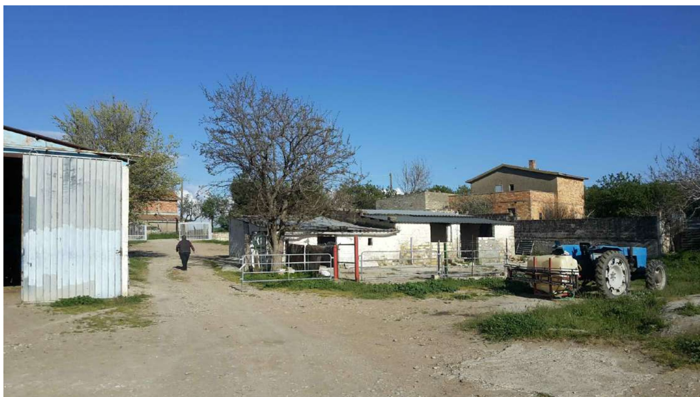
FOTO 8 - Veduta d'insieme del corpo C= depositi/pollai dal lato sud-ovest
