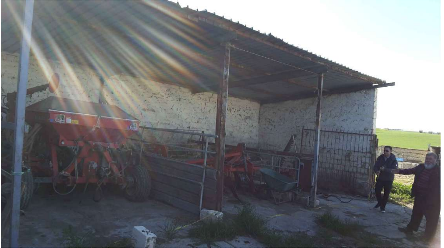
FOTO 3 - Corpo F: tettoia
