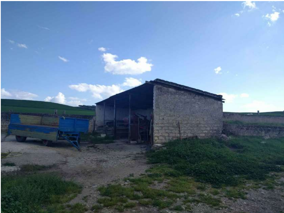
FOTO 2 - Corpo F: tettoia
