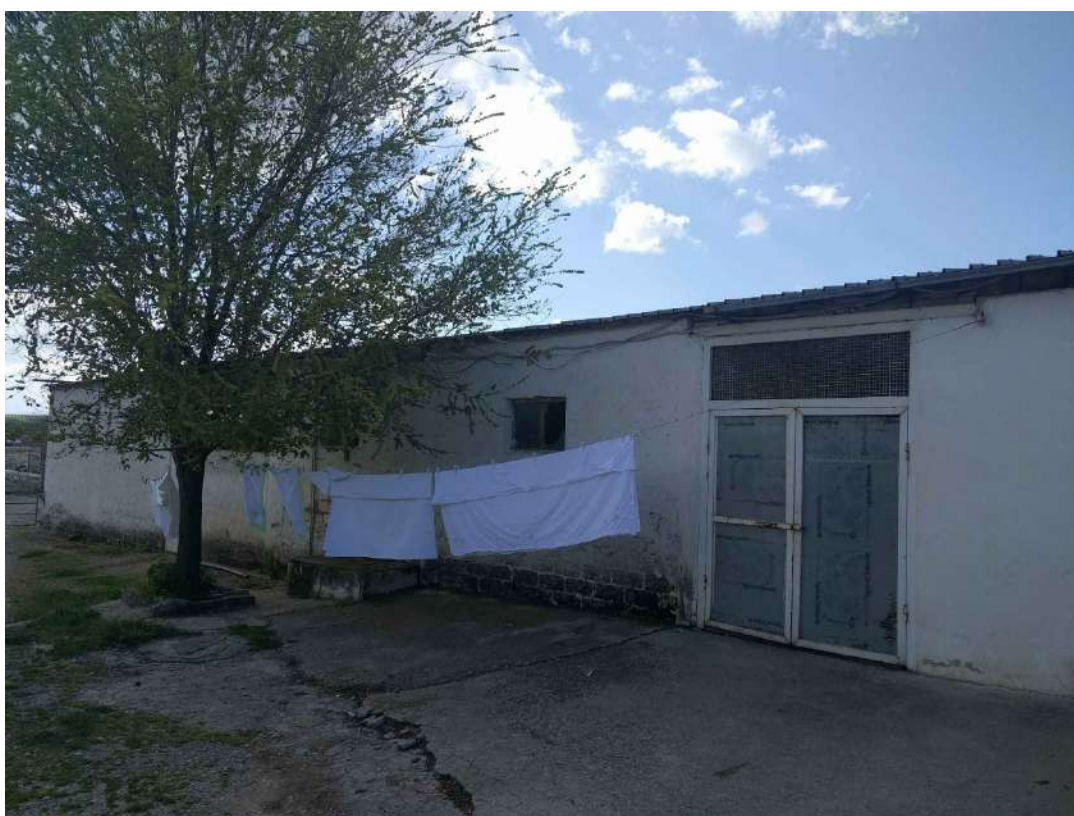
FOTO 2 - B = Stalla/Deposito macchine e attrezzi agricoli: prospetto sulla corte
