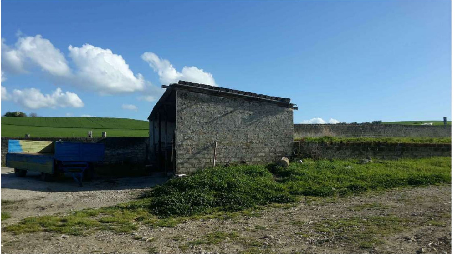
FOTO 1 - Corpo F: tettoia
