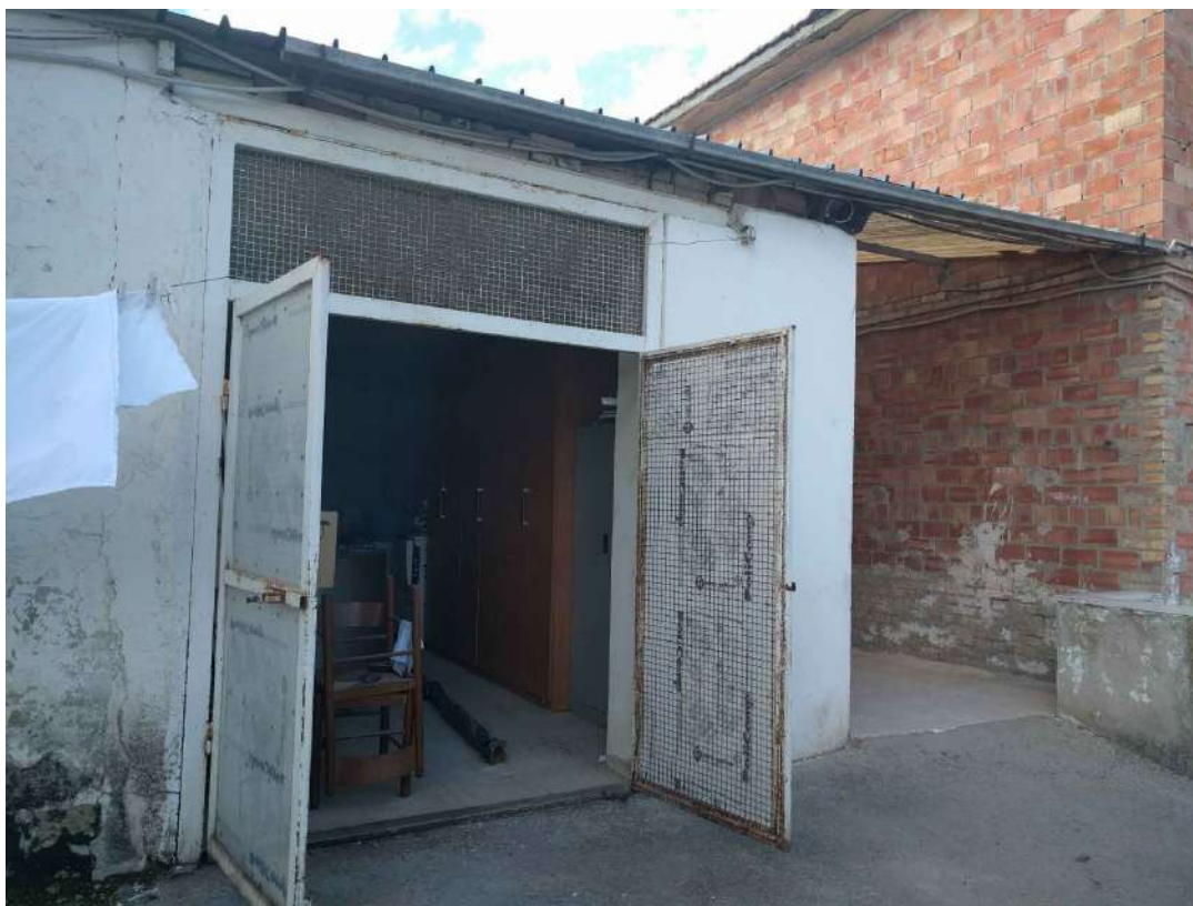
FOTO 3 - Ingresso al Vano 3: sala latte
