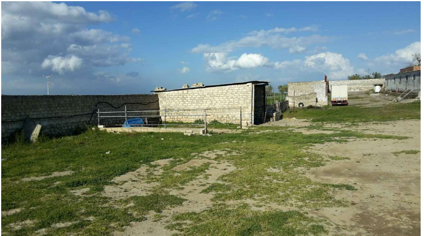
FOTO 2 - Corpo E1: tettoia
