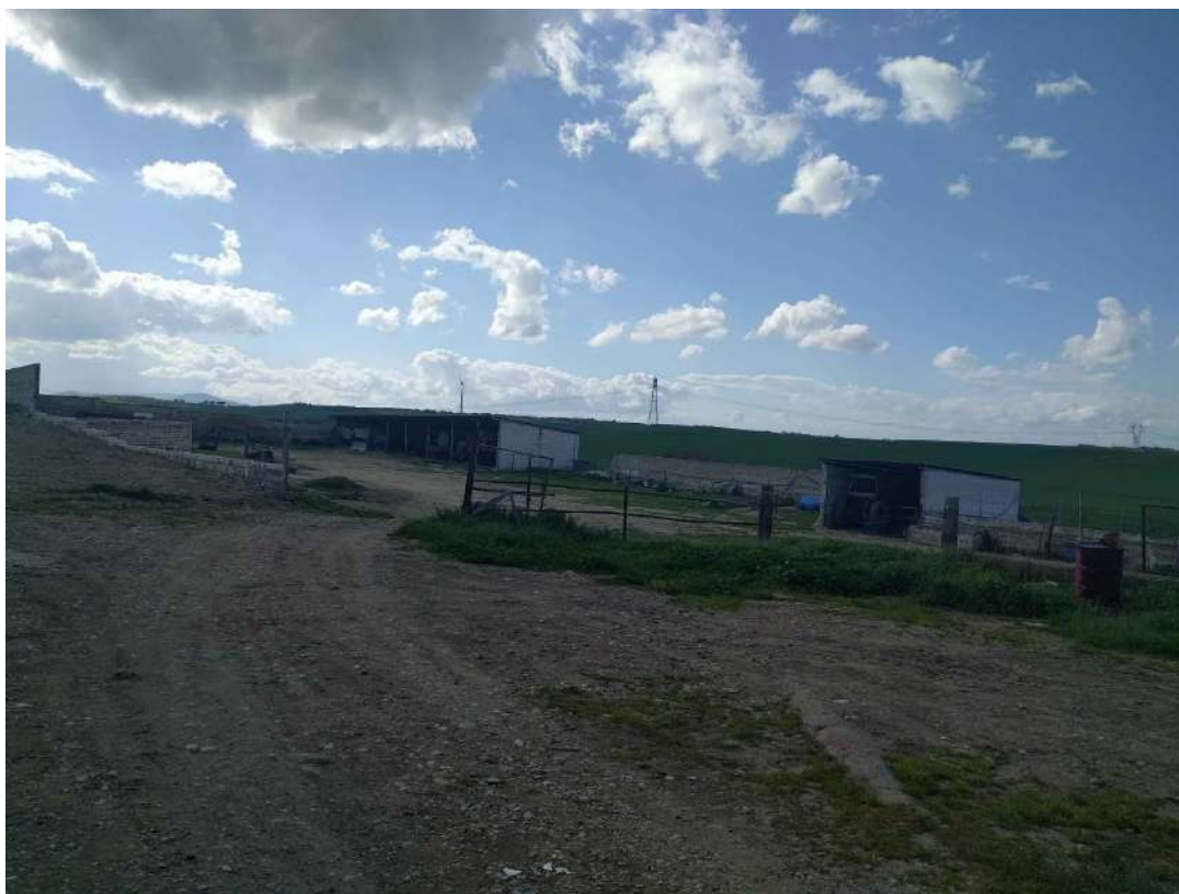
FOTO 1 - Veduta d'insieme del corpo E = ricovero animali (a sx) e del corpo E1 = tettoia (a dx)
