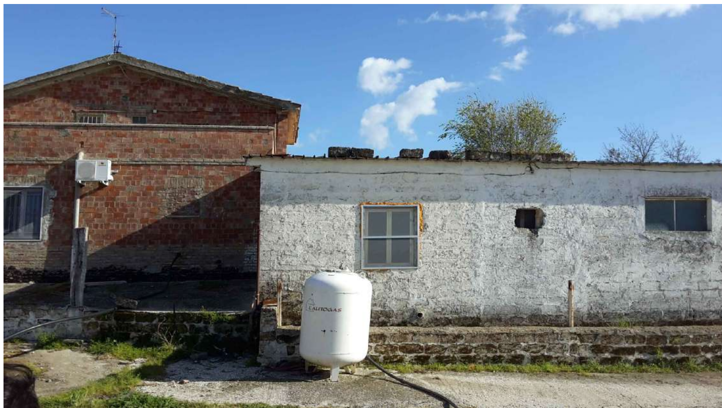
FOTO 19 - Corpo B = Stalla/Deposito macchine e attrezzi agricoli (a dx) e sub 2 (a sx)
