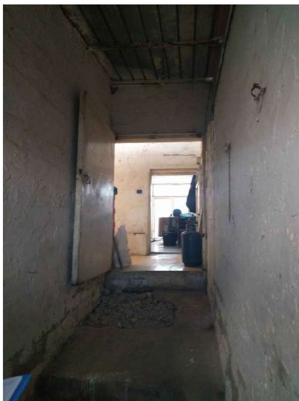
FOTO 12 - Corridoio tra il Vano 3 = stalla (a dx) e il Vano 1 = cantina (a sx)
