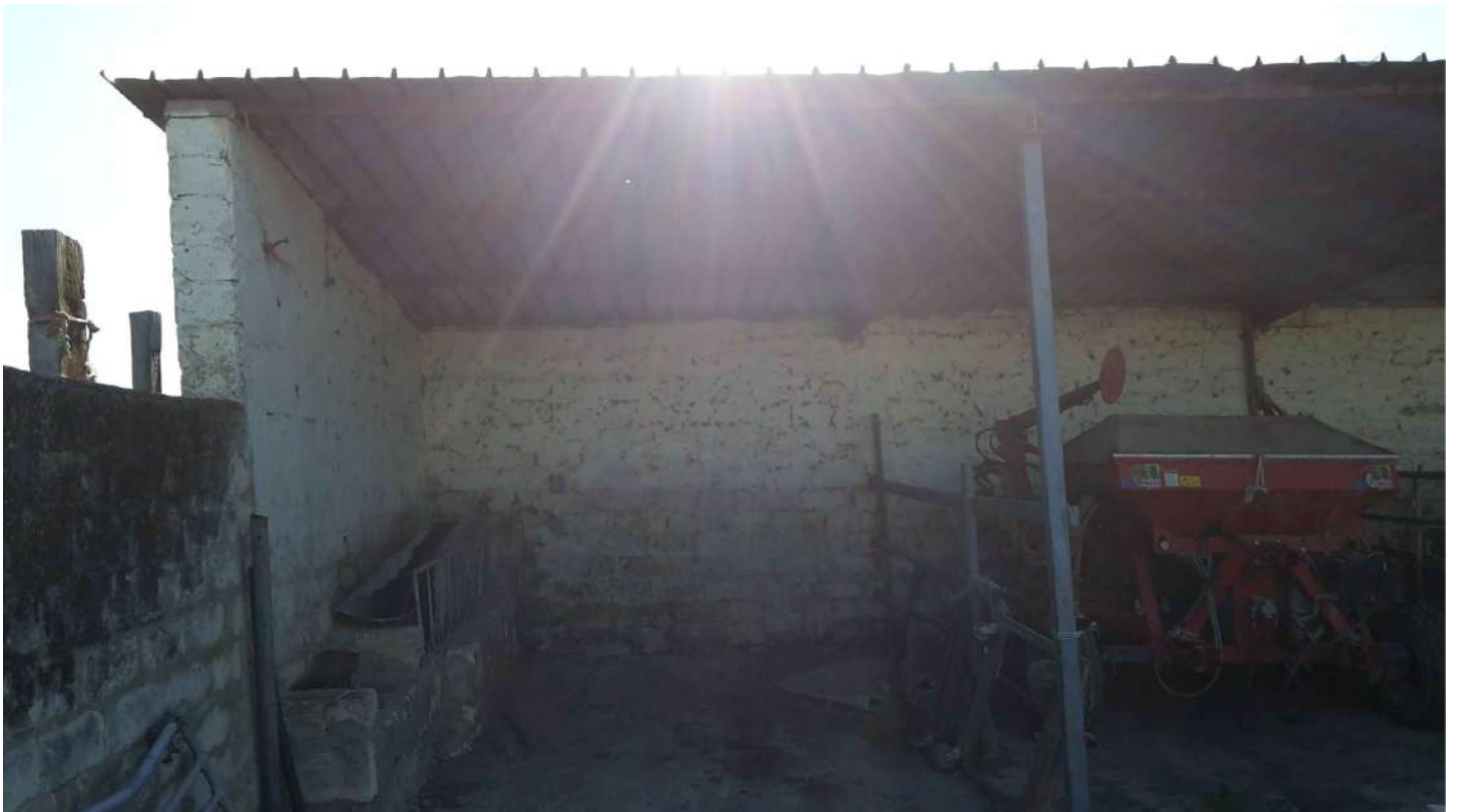
FOTO 4 - Corpo F: tettoia
