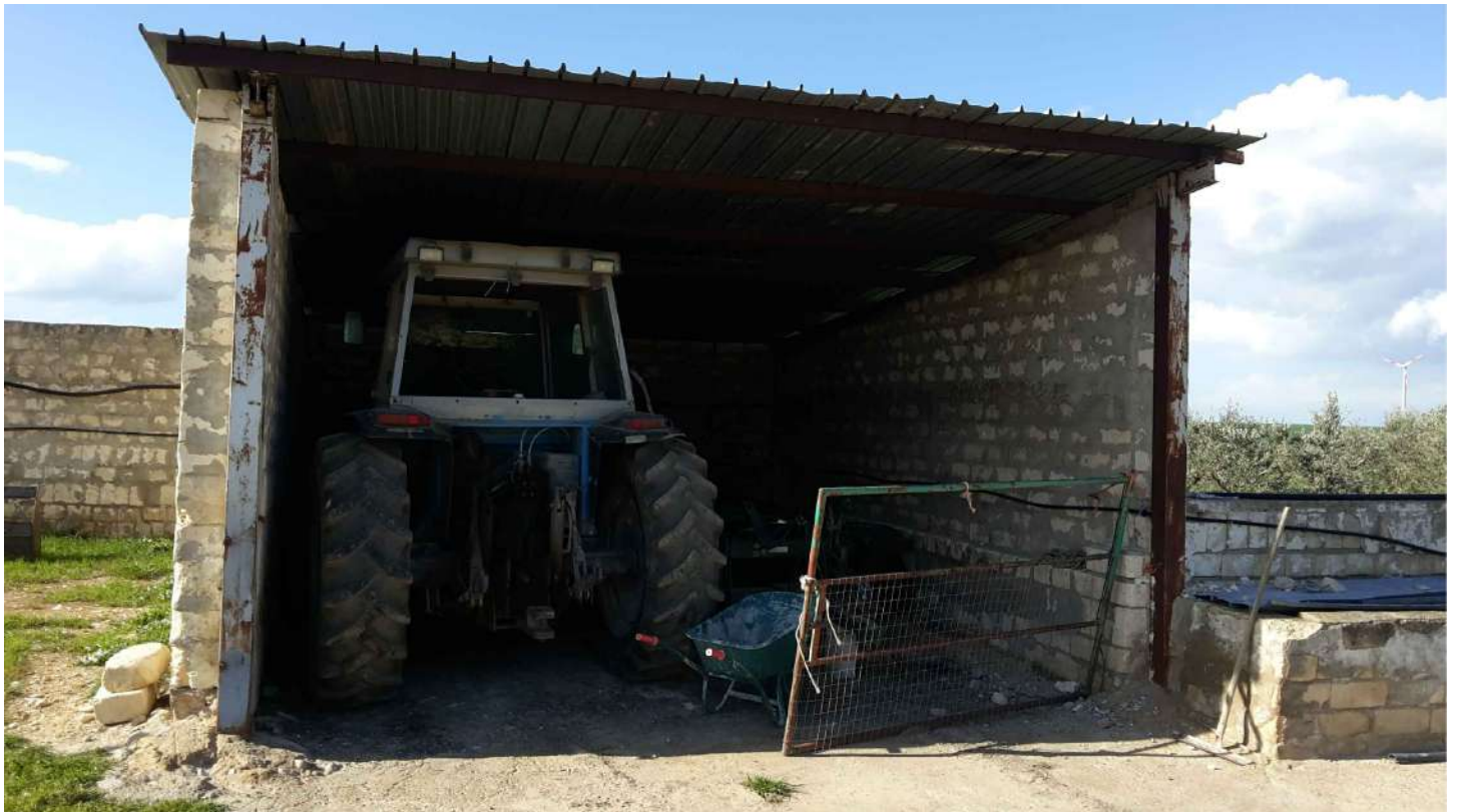
FOTO 4 - Corpo E1: tettoia
