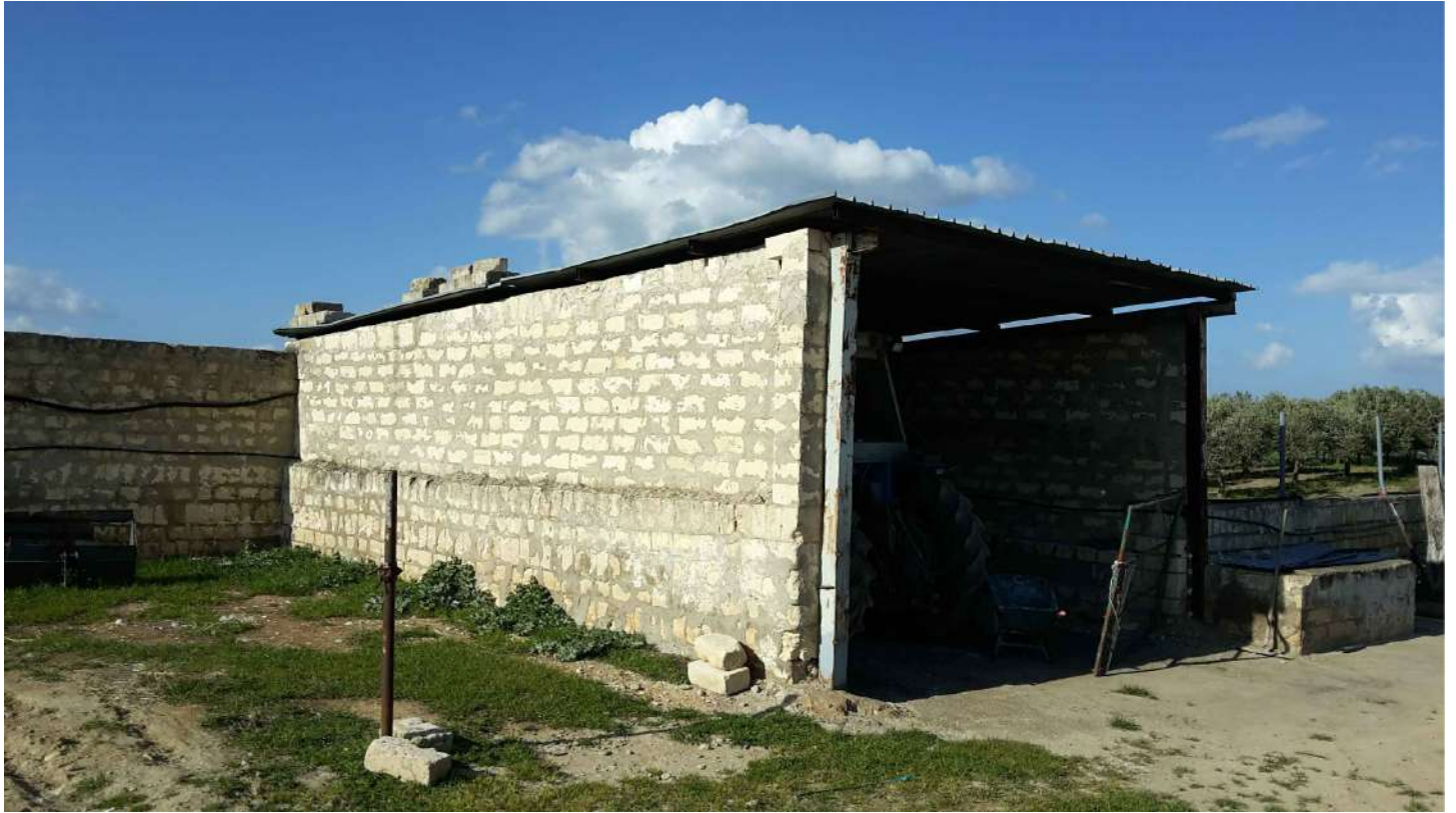
FOTO 3 - Corpo E1: tettoia
