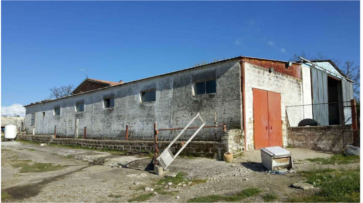
FOTO 17 - Corpo B = Stalla/Deposito macchine e attrezzi agricoli: lato ovest
