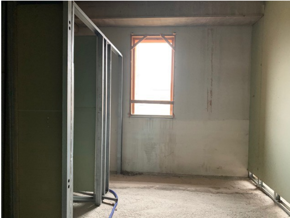
Vista interna - piano primo
