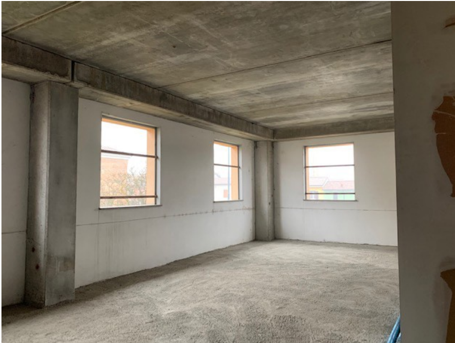
Vista interna - piano primo
