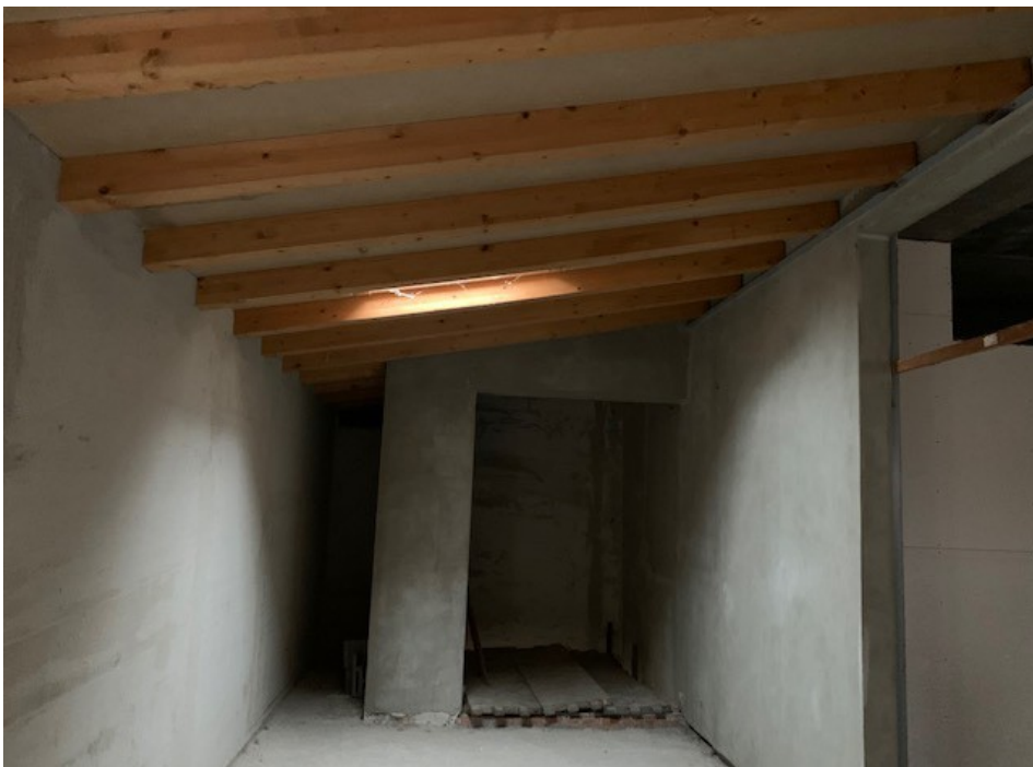
Vista interna - piano primo
