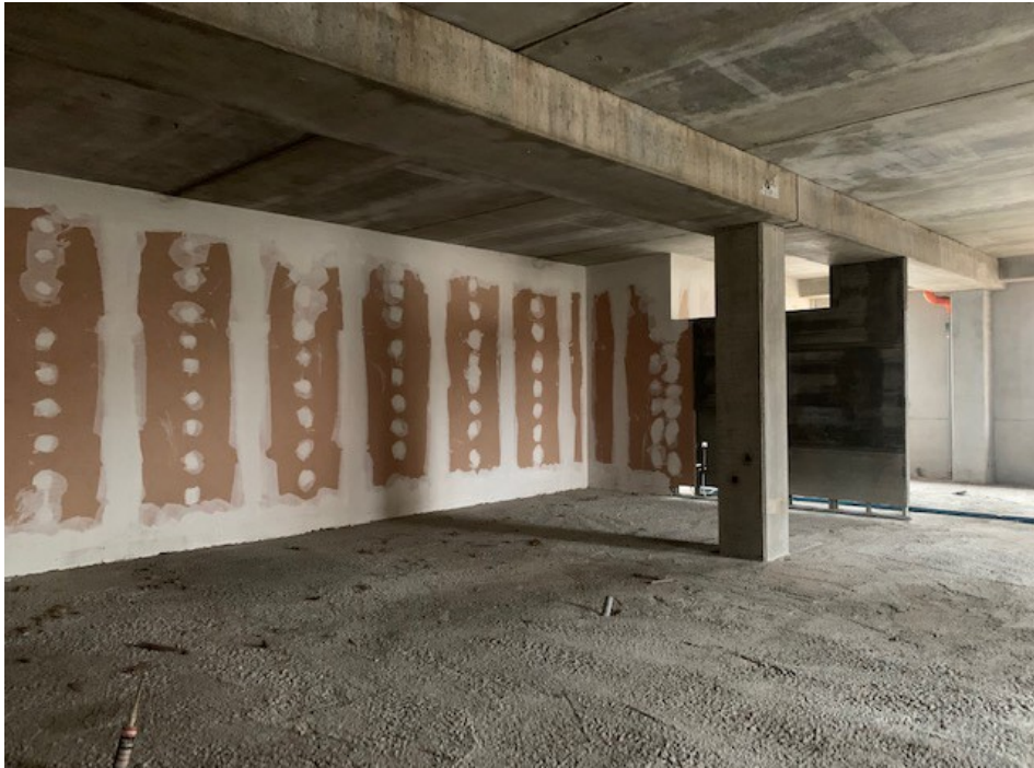
Vista interna - piano primo
