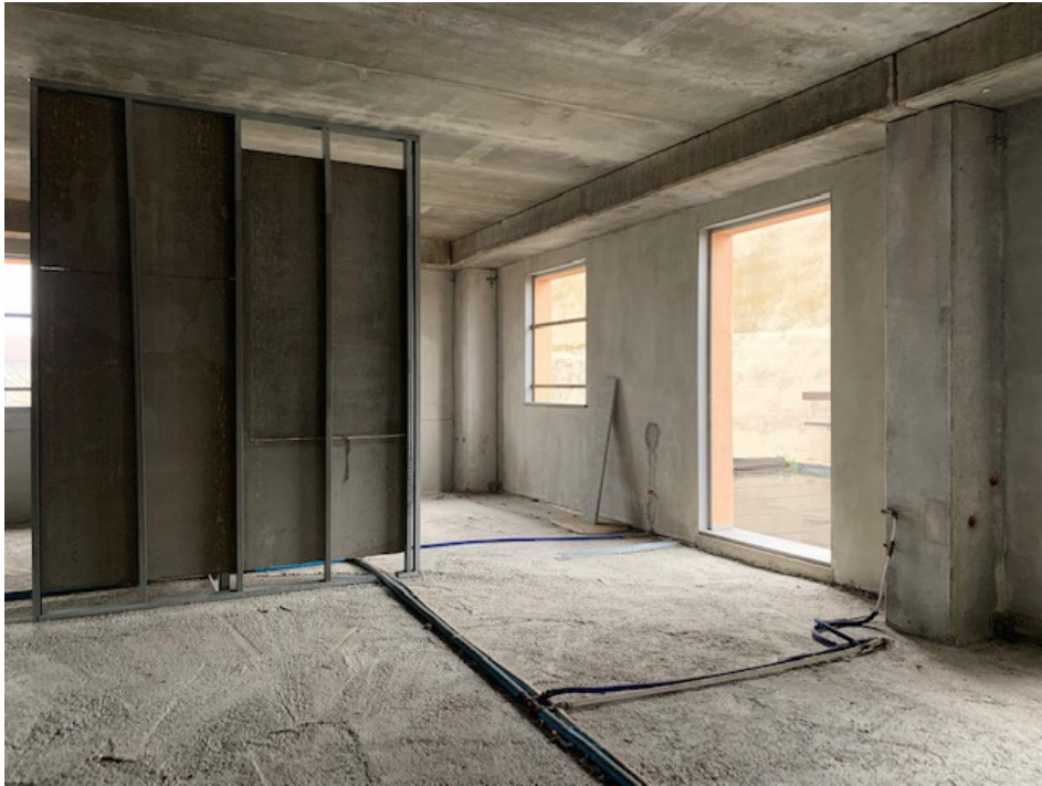
Vista interna - piano primo
