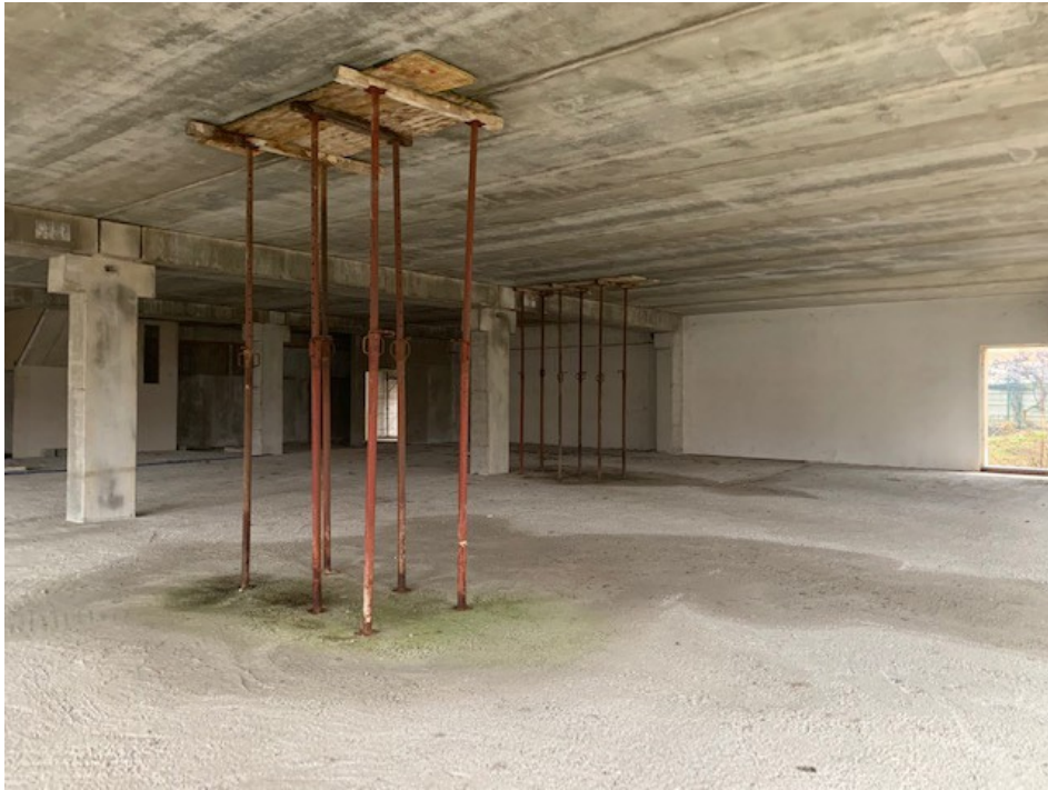
Vista interna - piano terra
