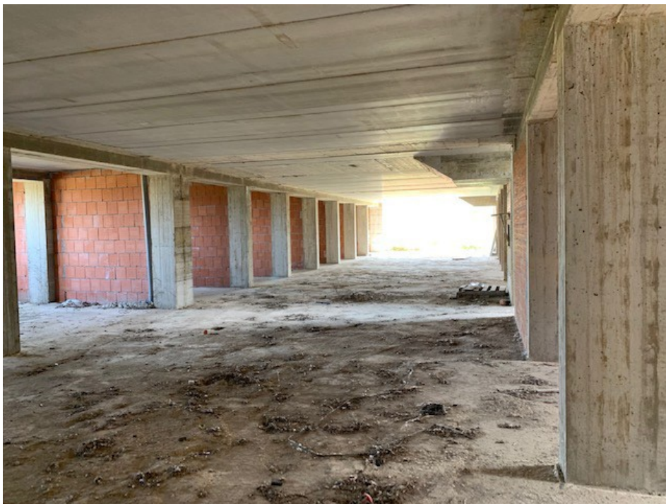
Vista interna - piano primo
