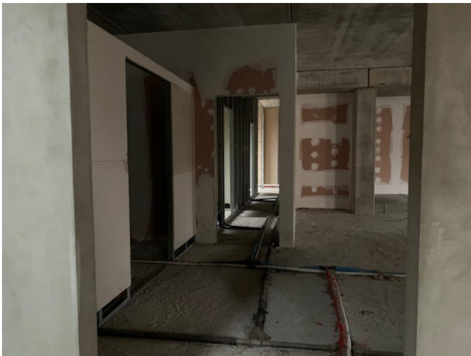
Vista interna - piano primo
