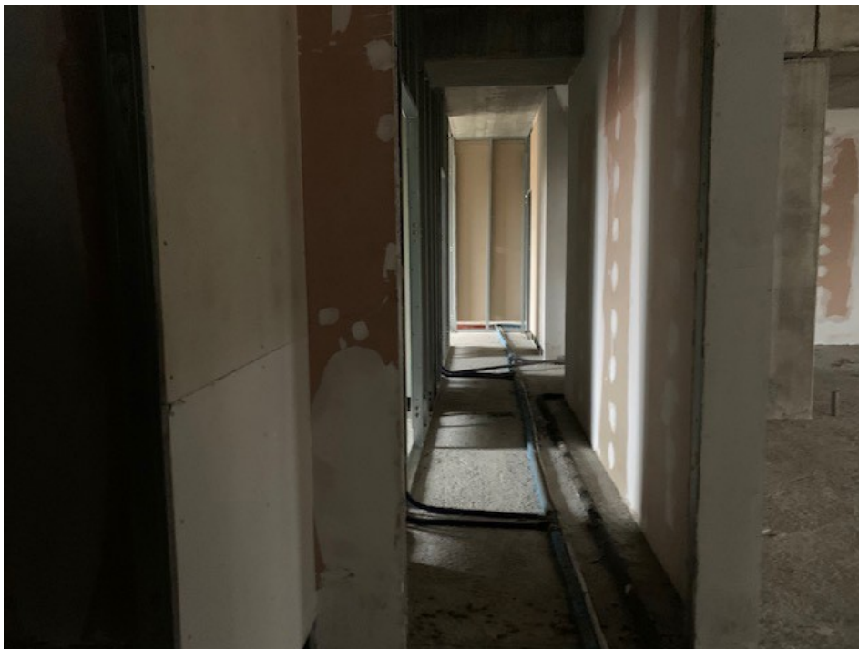
Vista interna - piano primo
