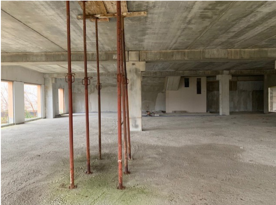
Vista interna - piano terra
