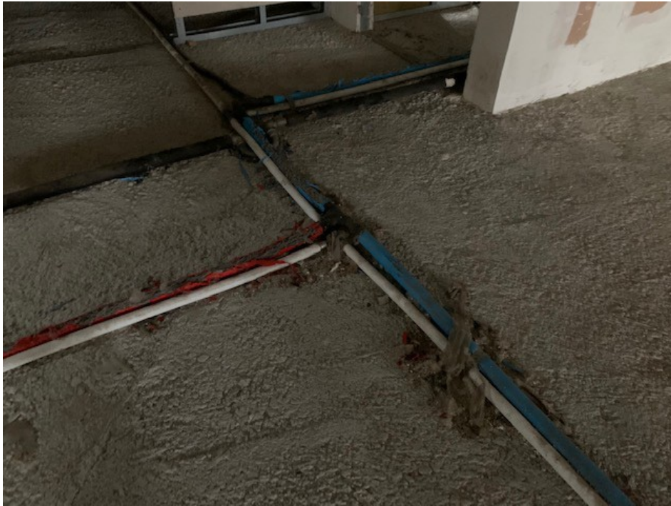
Vista interna - dettaglio passaggio impianti
