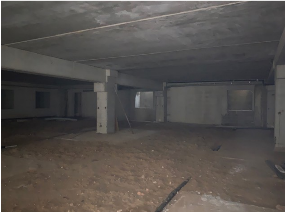
Vista interna - piano interrato
