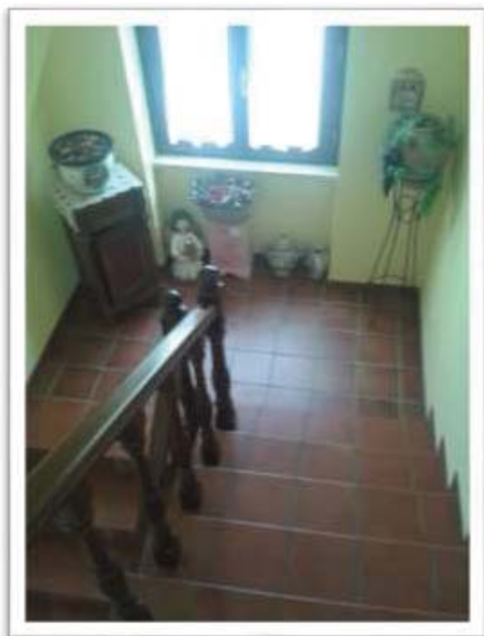
FOTO 02 – particolare del vano scala comune
