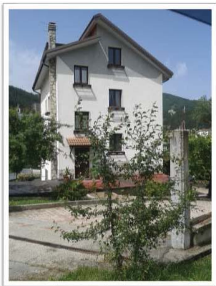
FOTO 13 – prospetto principale del fabbricato
