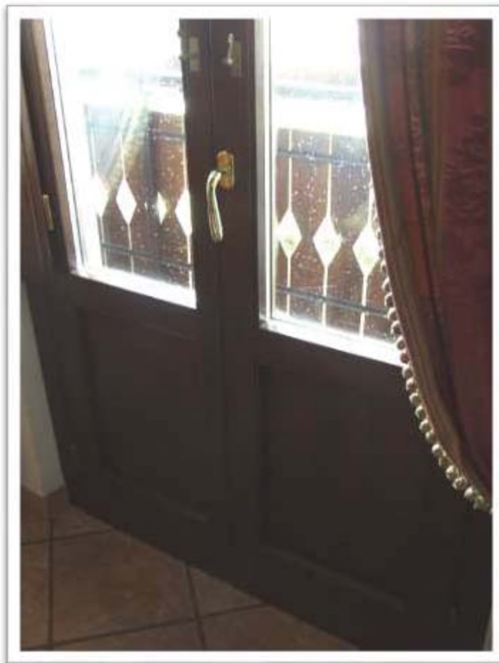
FOTO 08 – dettaglio degli infissi esterni
