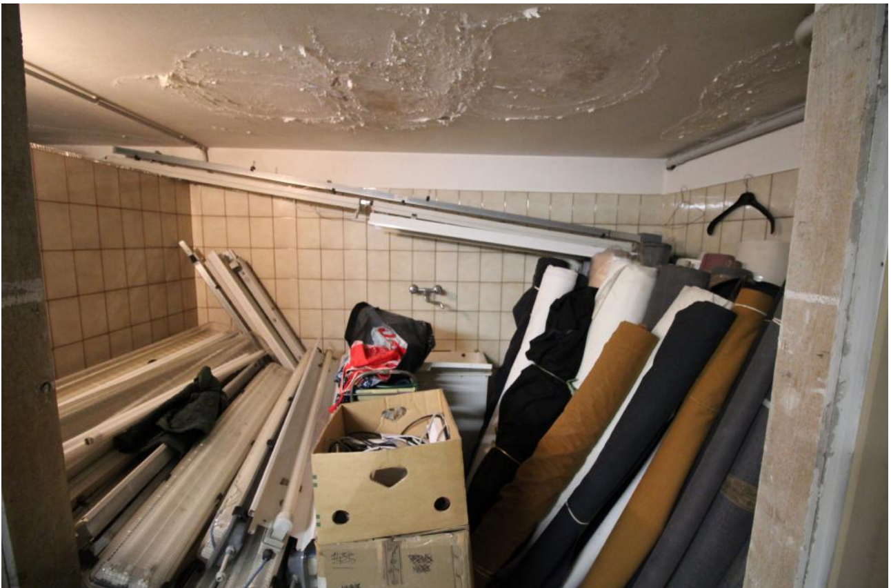
FOTO 46 – vista interna bagno deposito
