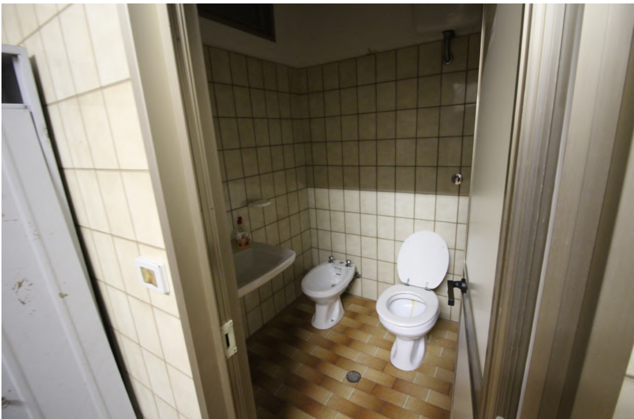
FOTO 58 – vista interna wc spogliato 1
