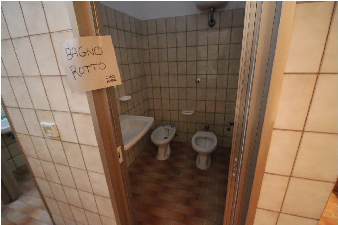
FOTO 61 – vista interna wc spogliatoio 2
