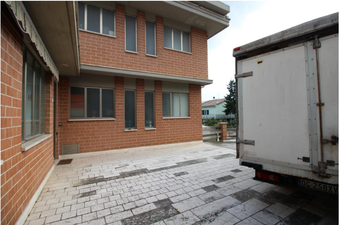
FOTO 09 – vista esterna corte nord
