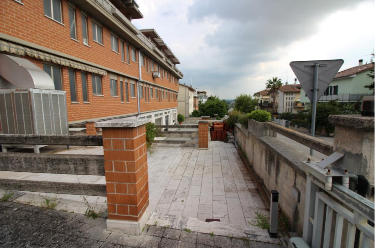
FOTO 11 – vista esterna corte nord verso sud
