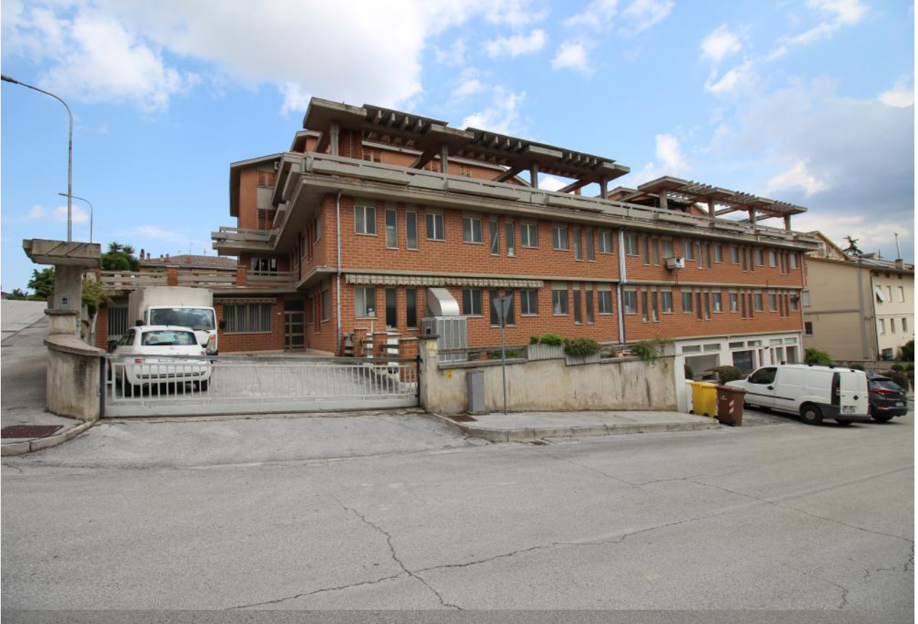
FOTO 03 – vista esterna lato ovest
