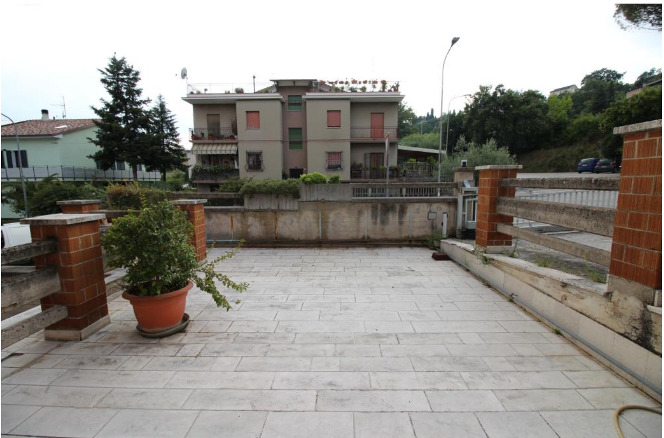
FOTO 14 – vista esterna corte ovest verso strada
