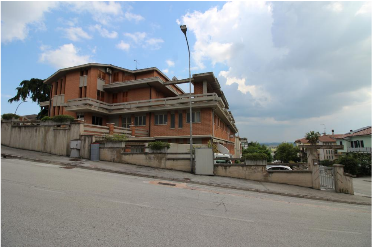
FOTO 01 – vista esterna lato nord
