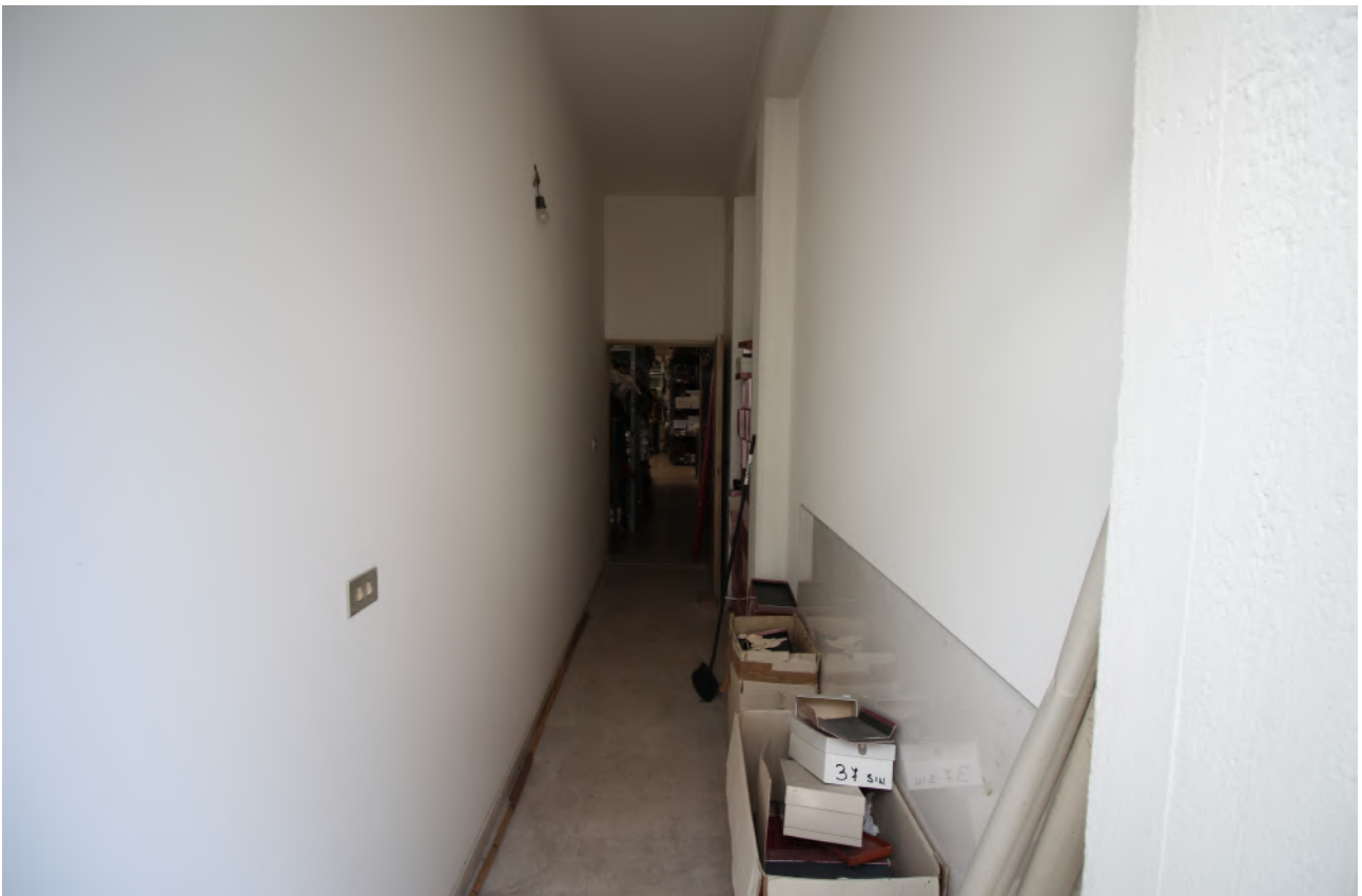
FOTO 40 – vista interna disimpegno da corte sud a laboratorio
