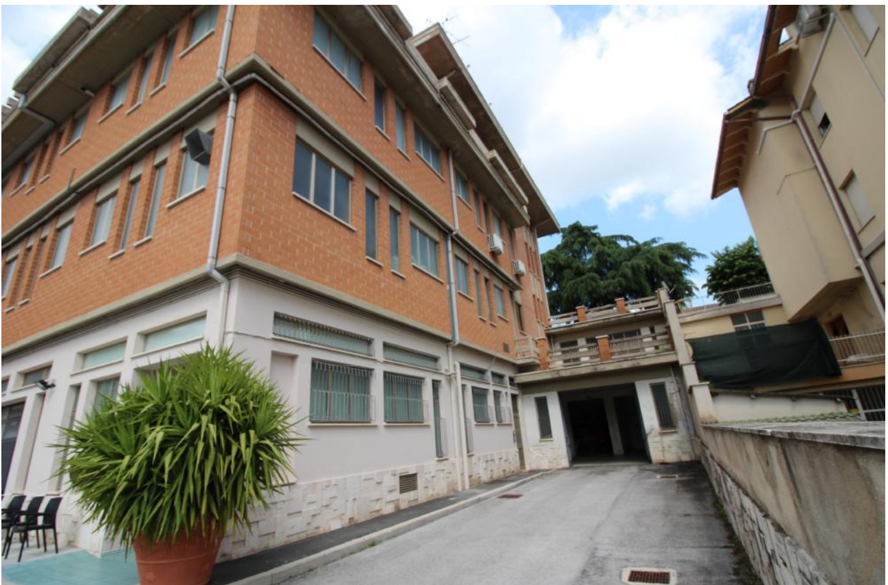
FOTO 06 – vista esterna corte lato sud
