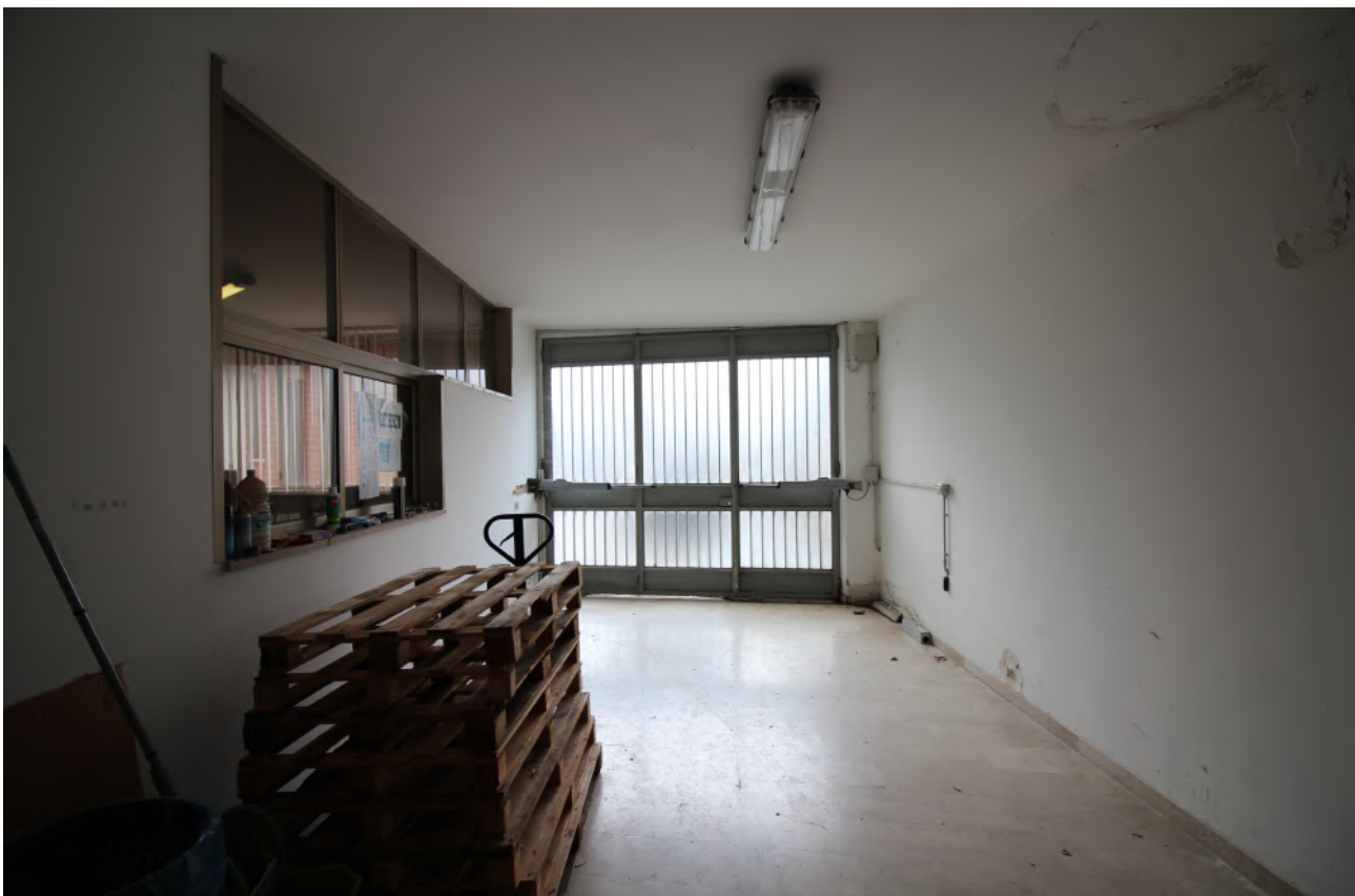
FOTO 28 – vista interna deposito
