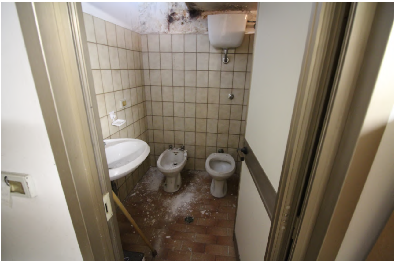
FOTO 44 – vista interna wc deposito
