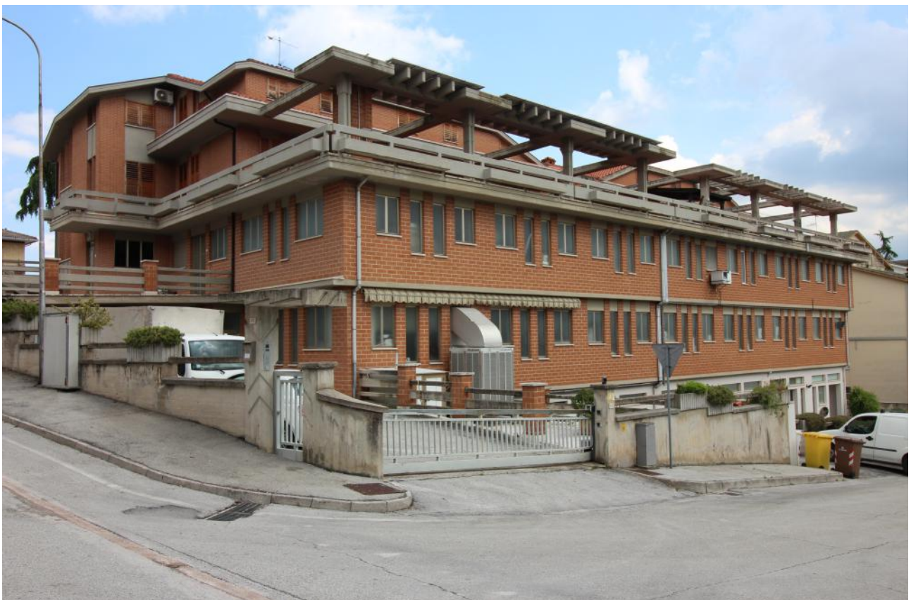
FOTO 02 – vista esterna angolo nord-ovest
