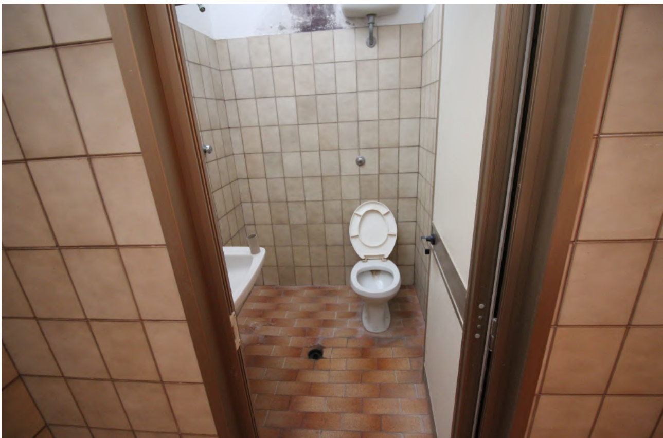
FOTO 62 – vista interna wc spogliato 2
