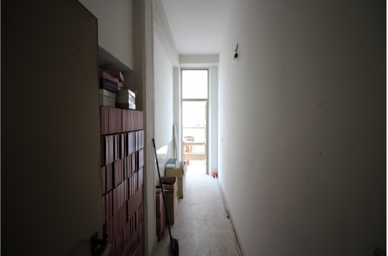
FOTO 39 – vista interna disimpegno uscita corte a sud dal laboratorio
