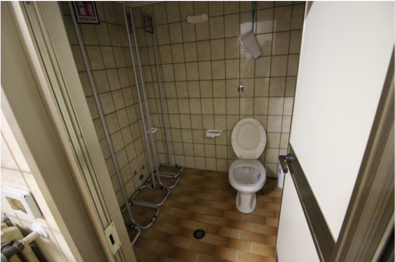
FOTO 57 – vista interna wc spogliatoio 1
