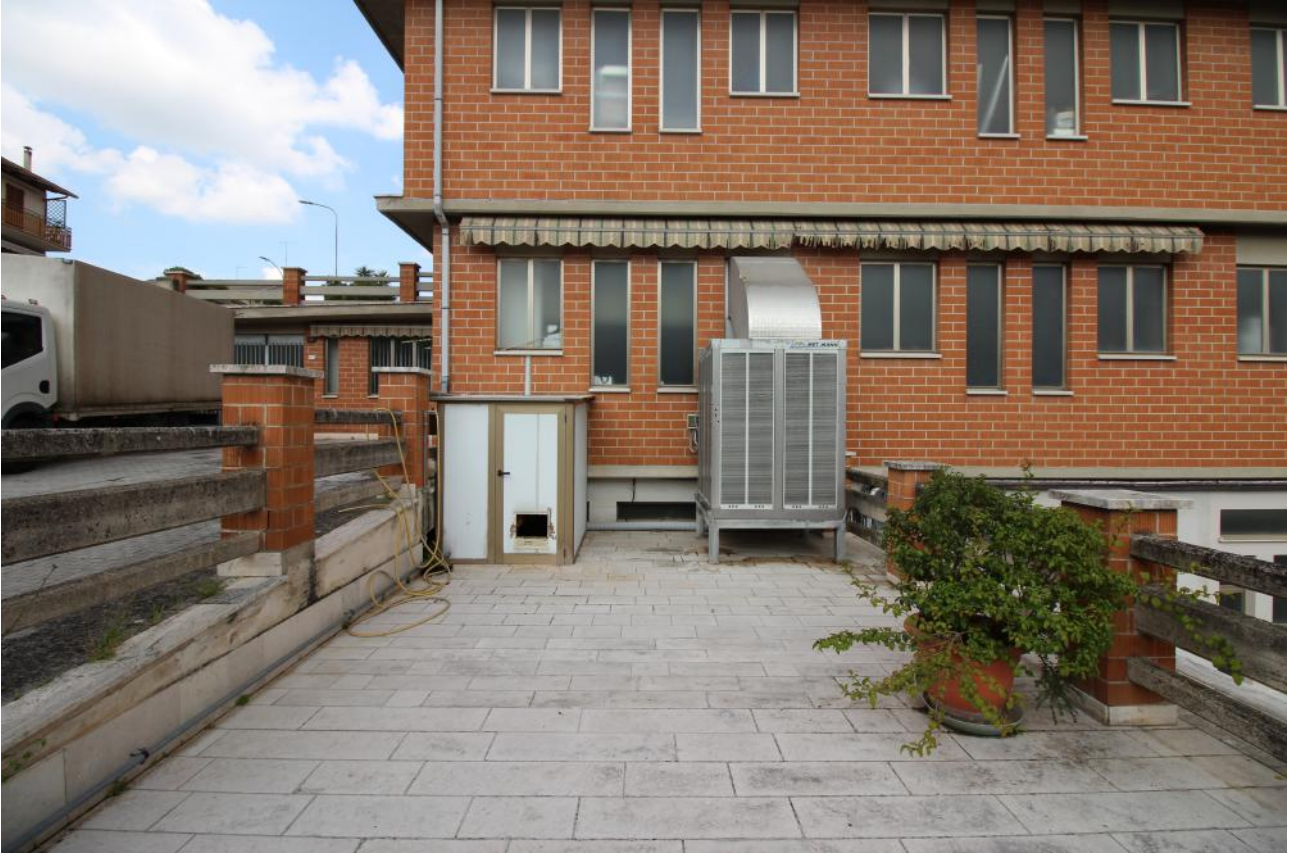
FOTO 13 – vista esterna corte ovest verso locali tecnici
