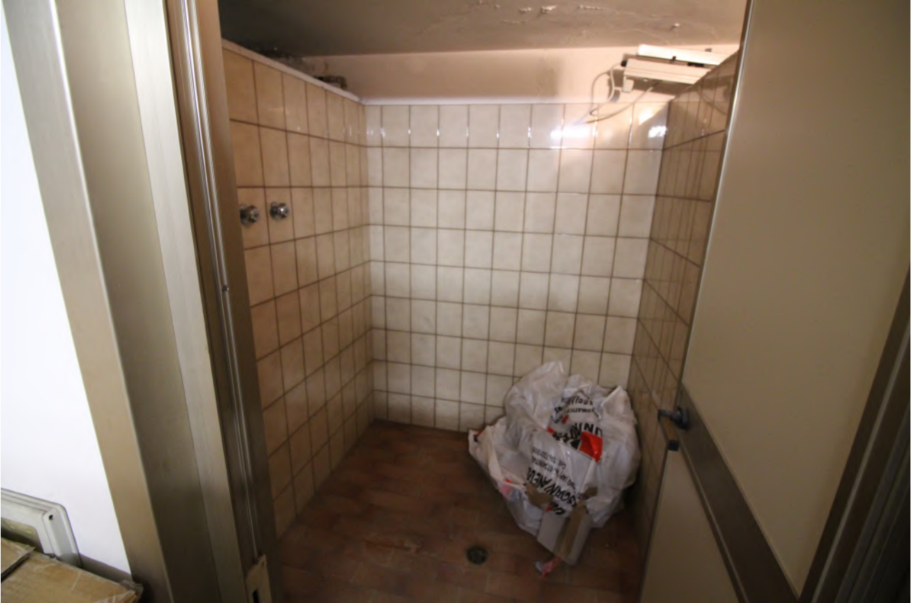
FOTO 45 – vista interna doccia deposito
