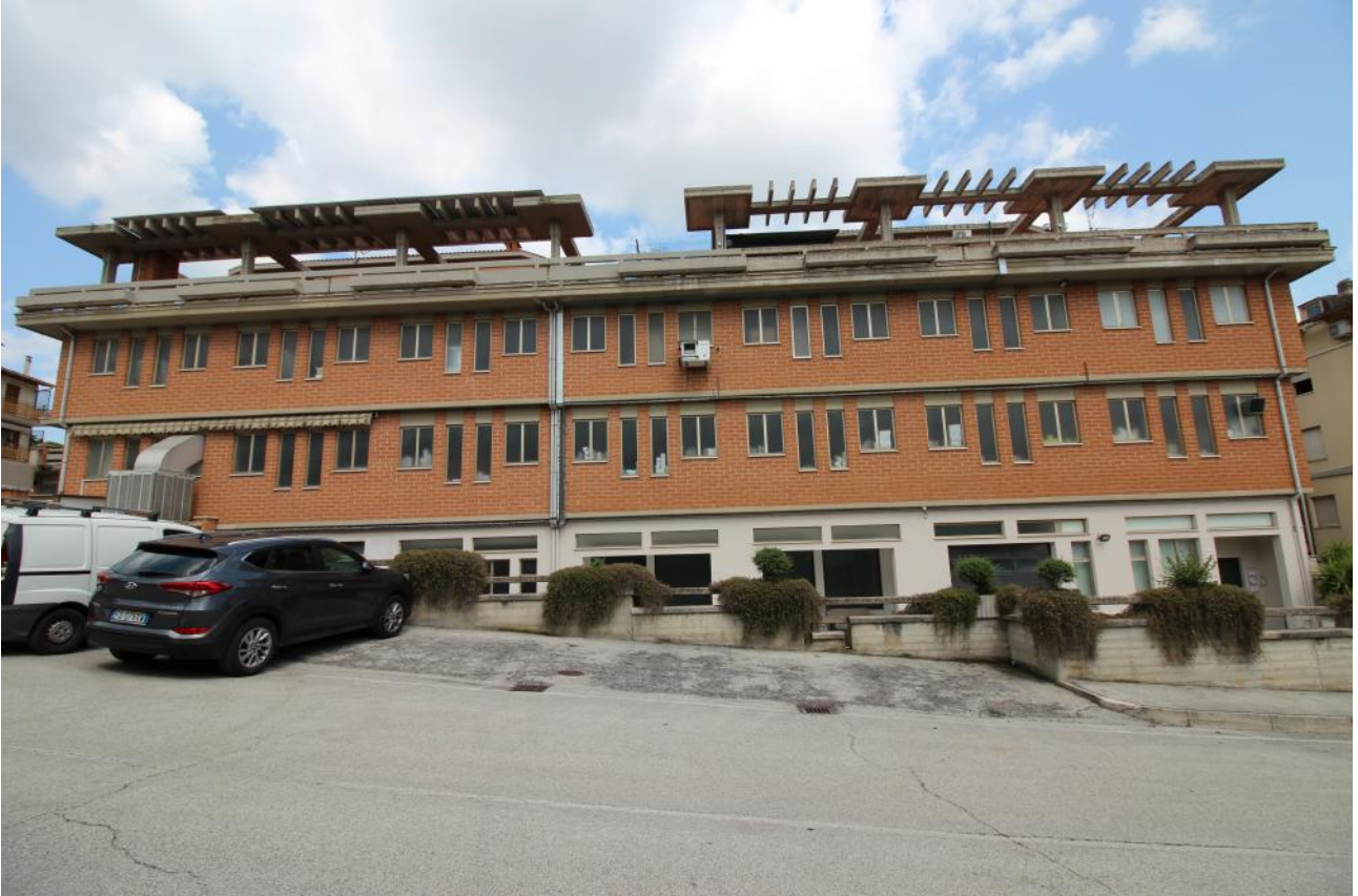
FOTO 05 – vista esterna frontale lato ovest
