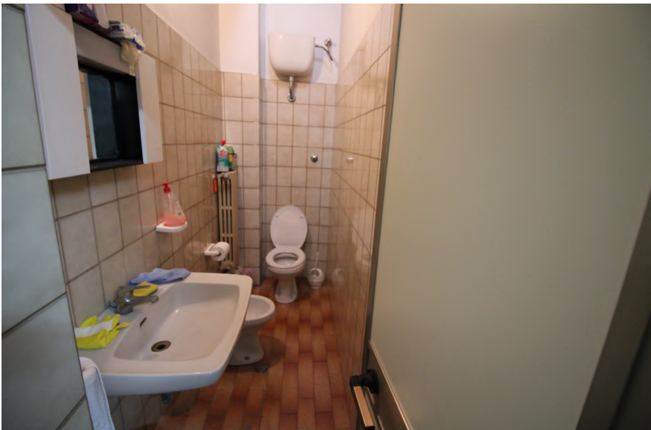
FOTO 24 – vista interna wc uffici
