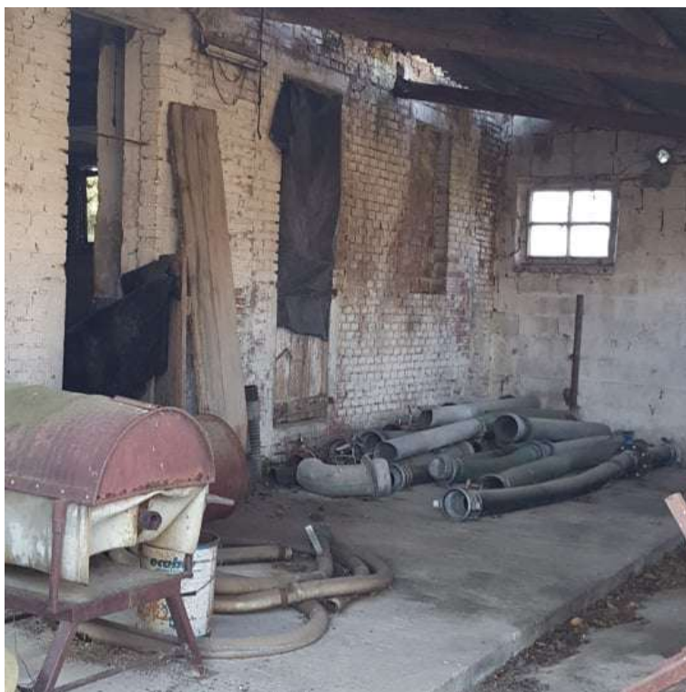
Figura 24: Foglio 24, mappale 143, sub. 1 - Interno con deposito di materiale vario
