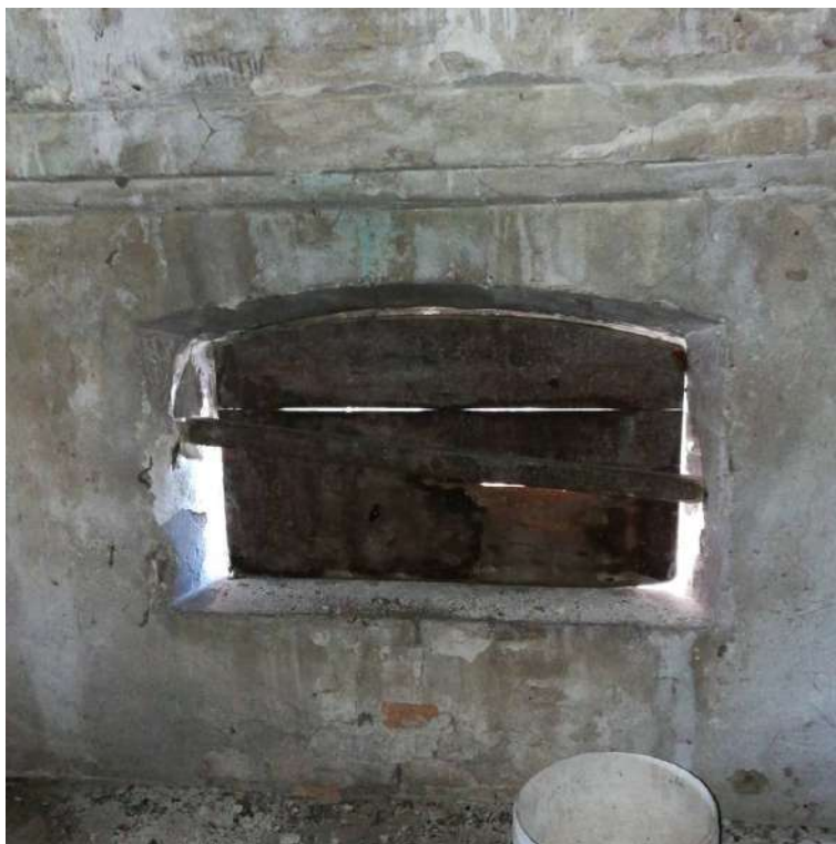
Figura 77: Foglio 24, mappale 143, sub.5 - finestra soffitta
