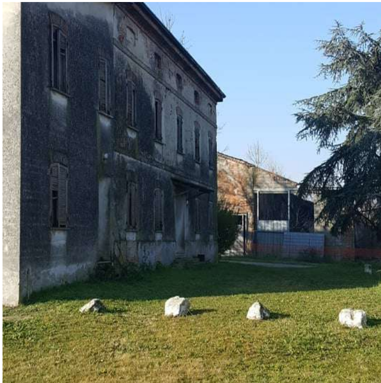
Figura 114: Foglio 24, mappale 143, sub.6 - esterno
