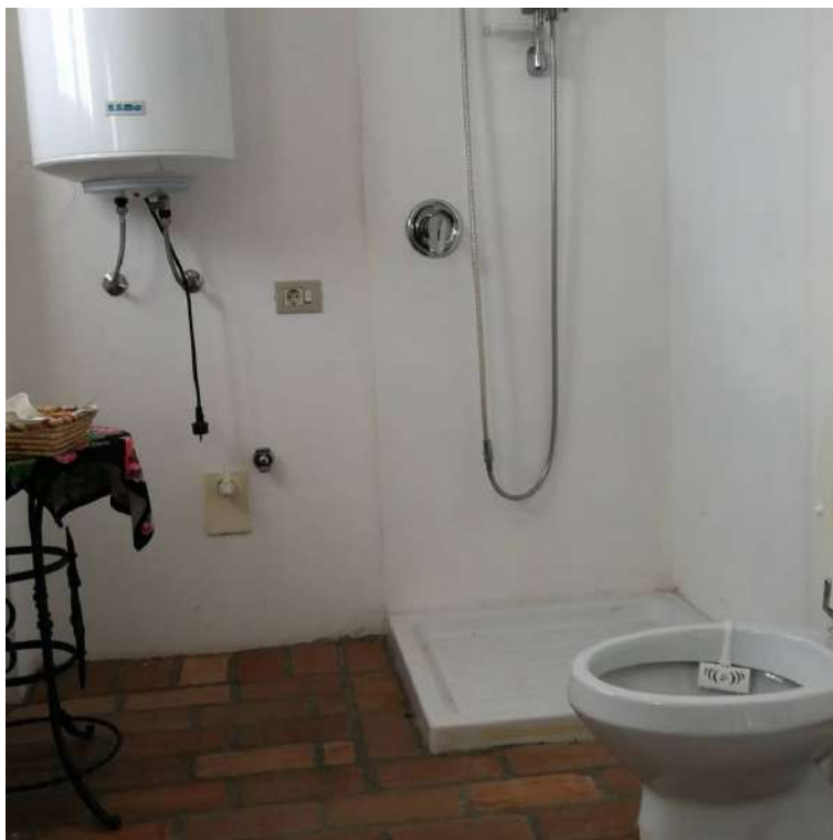
Figura 55: Foglio 24, mappale 143, sub.5 - bagno
