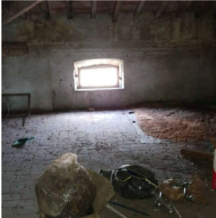
Figura 78: Foglio 24, mappale 143, sub.5 - finestra soffitta
