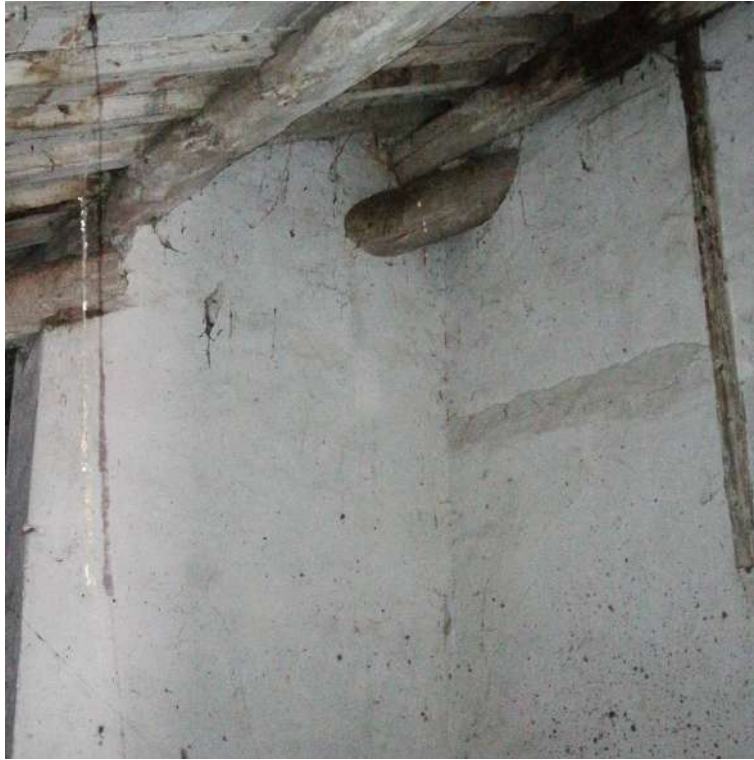
Figura 110: Foglio 24, mappale 143, sub.6 - soffitta
