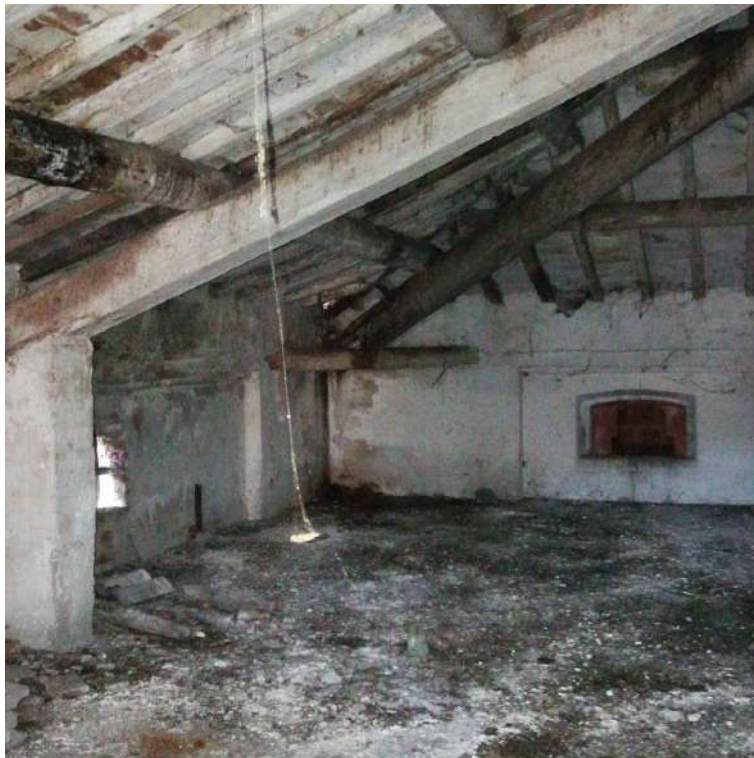
Figura 109: Foglio 24, mappale 143, sub.6 - soffitta
