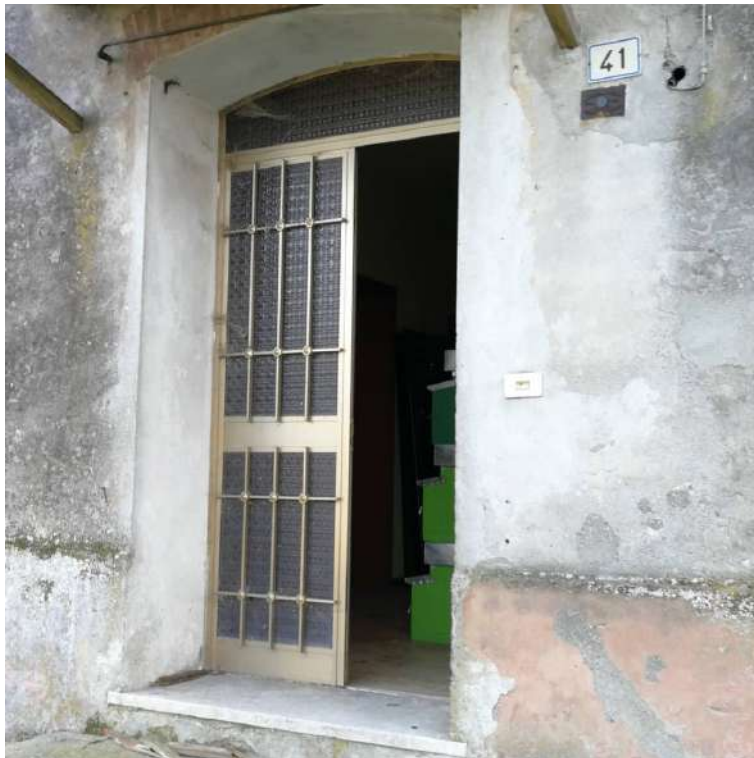
Figura 81: Foglio 24, mappale 143, sub.6 - ingresso
