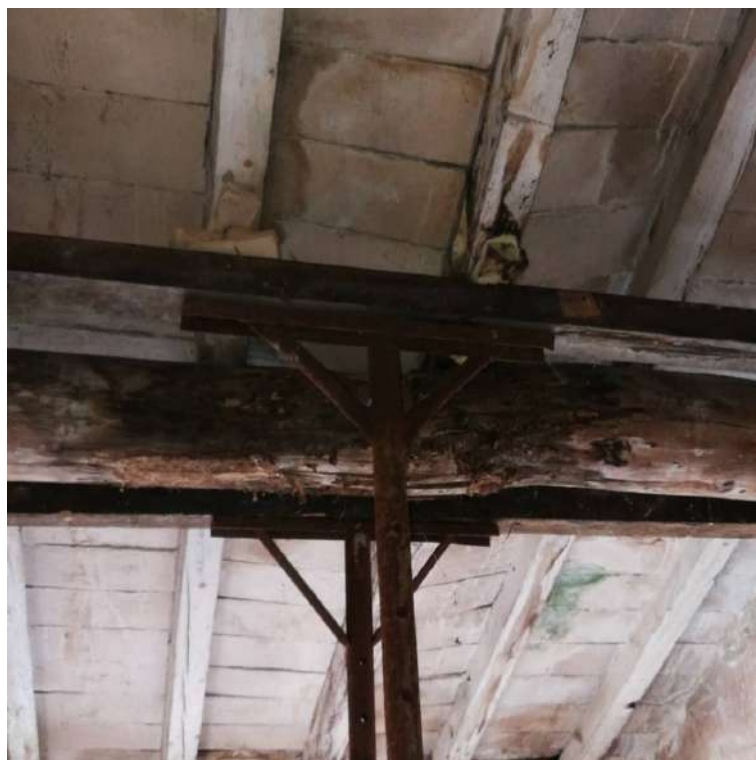
Figura 65: Foglio 24, mappale 143, sub.5 - puntelli di sostegno delle travi del soffitto
