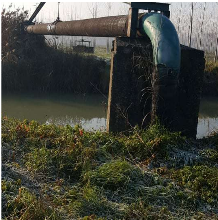
Figura 14: Foglio 23, mappali 10-11 - Manufatto di attraversamento idraulico su Canale Fossetta
