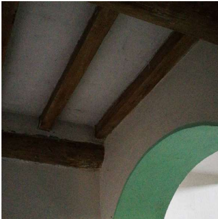
Figura 112: Foglio 24, mappale 143, sub.6 - soffito di parte del vano scale
