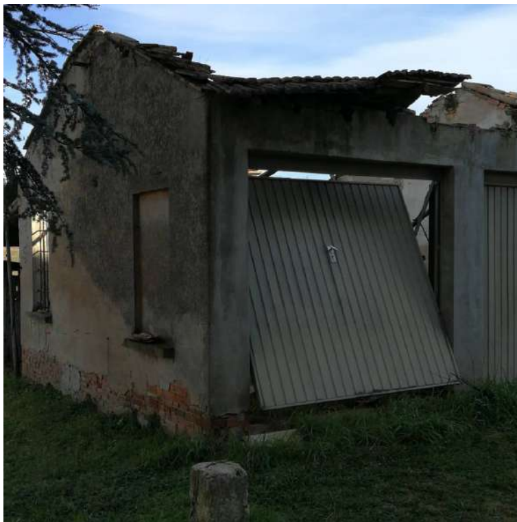
Figura 121: Foglio 24, mappale 143, sub.6 - basculanti (vista da sud)
