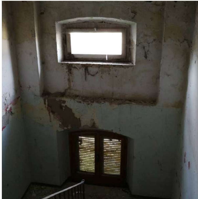
Figura 96: Foglio 24, mappale 143, sub.6 - vano scale
