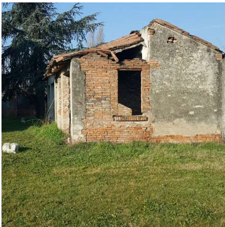
Figura 118: Foglio 24, mappale 143, sub.6 - rustici (vista da est)
