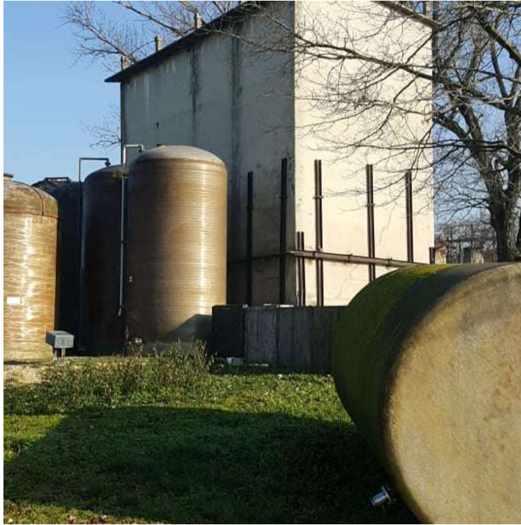
Figura 133: Foglio 24, mappale 143, sub.7 con vista silos e serbatoi in vetroresina da rottamare (vista da sud-ovest)
