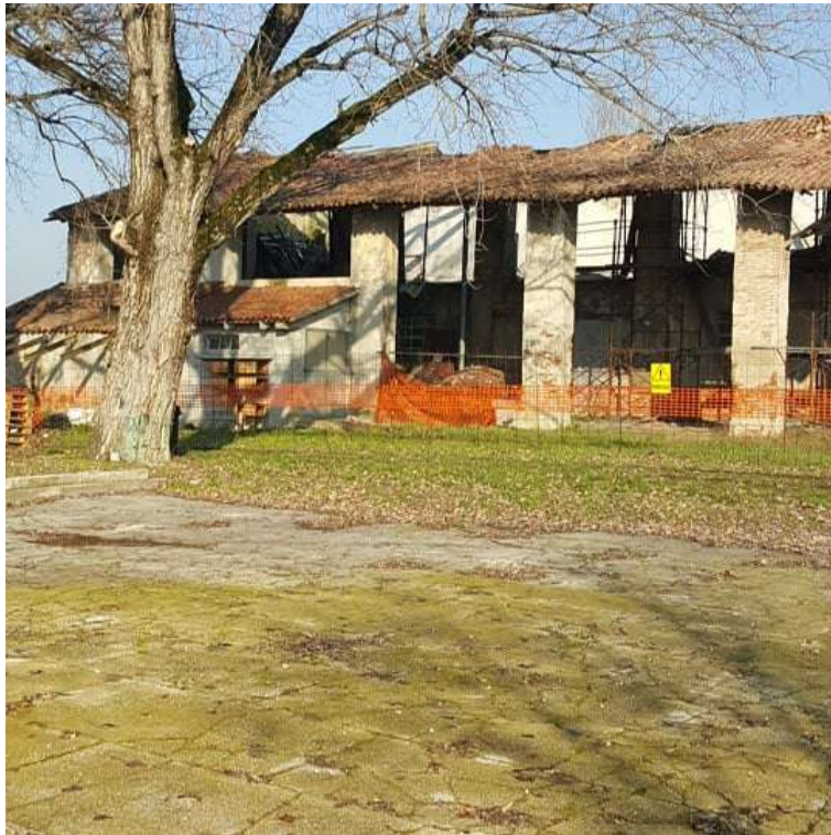
Figura 26: Foglio 24, mappale 143, sub.2 - vista da Sud
