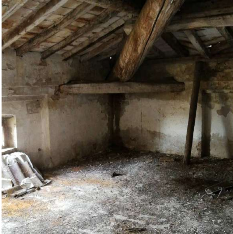
Figura 106: Foglio 24, mappale 143, sub.6 - soffitta
