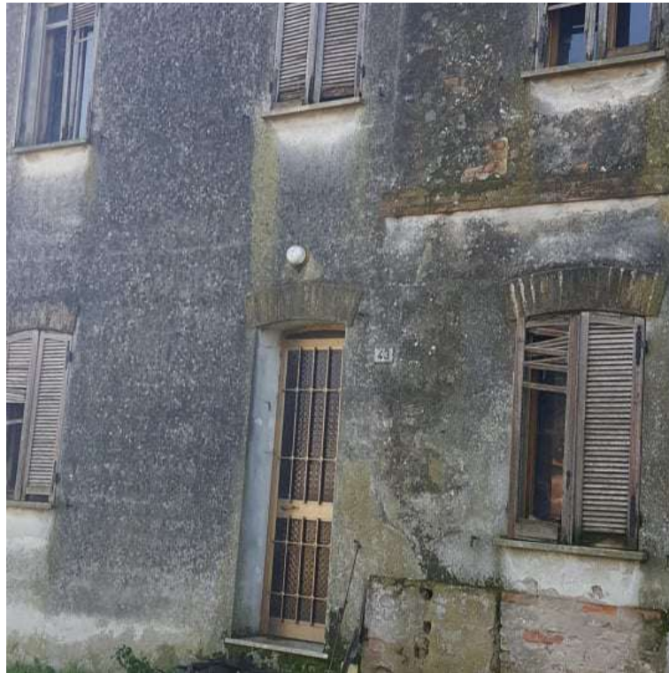
Figura 115: Foglio 24, mappale 143, sub.6 - esterno
