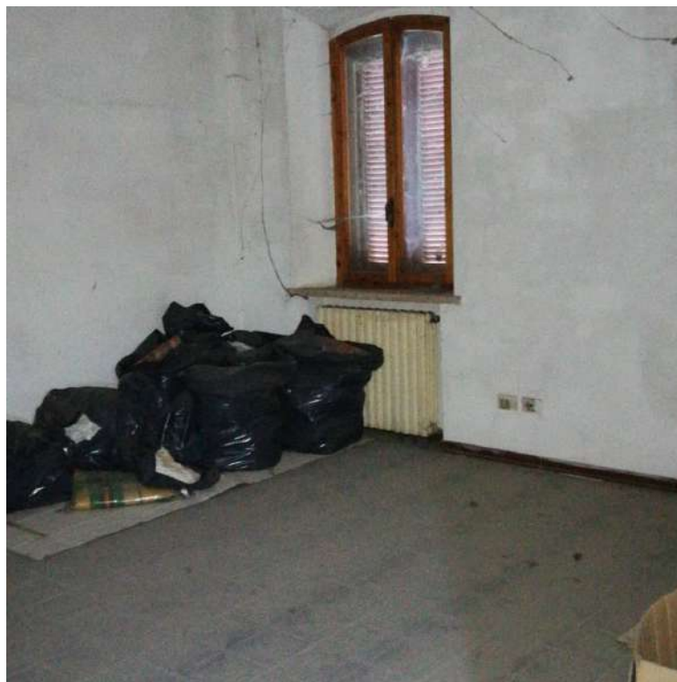
Figura 89: Foglio 24, mappale 143, sub.6 - cucina
