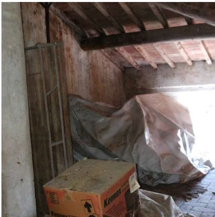
Figura 74: Foglio 24, mappale 143, sub.5 - soffitta
