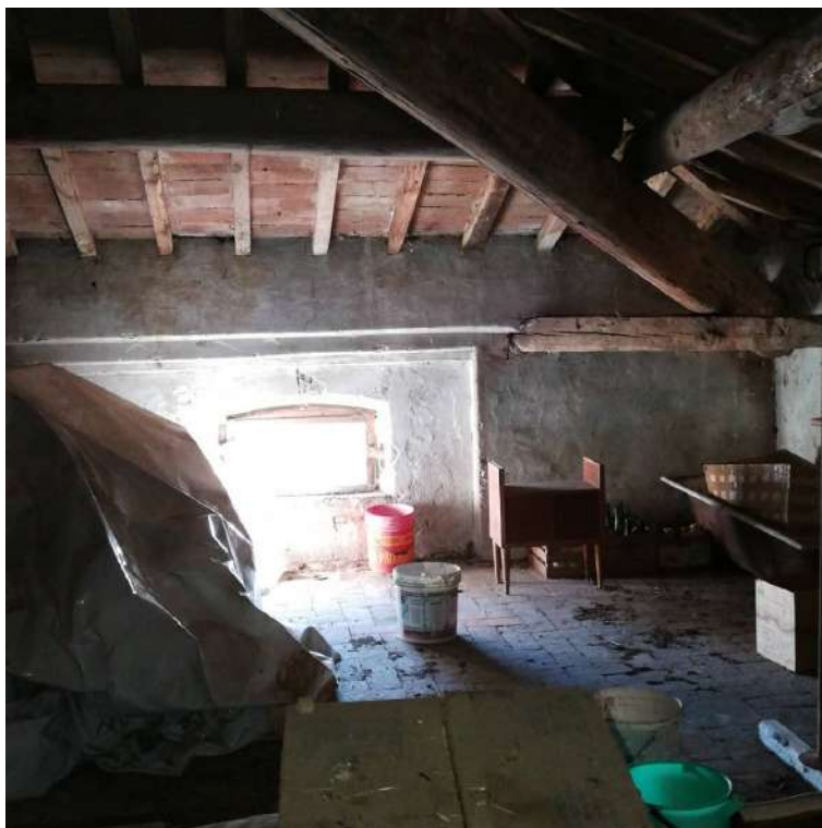
Figura 70: Foglio 24, mappale 143, sub.5 - soffitta
