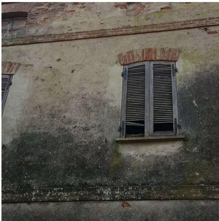
Figura 117: Foglio 24, mappale 143, sub.6 - serramenti esterni
