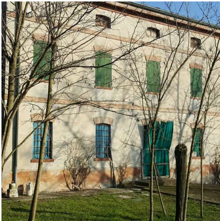
Figura 34: Foglio 24, mappale 143, sub.5 - esterno
