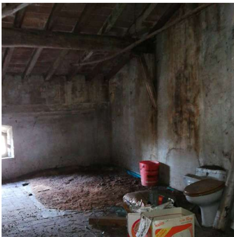
Figura 75: Foglio 24, mappale 143, sub.5 - soffitta
