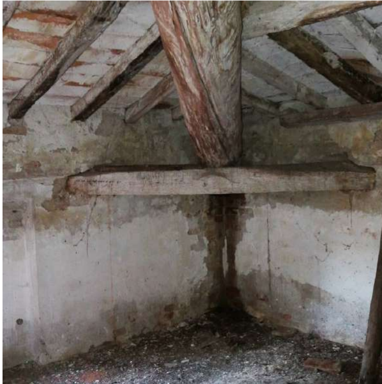
Figura 108: Foglio 24, mappale 143, sub.6 - soffitta
