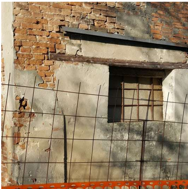
Figura 23: Foglio 24, mappale 143, sub. 1 - Particolare struttura (vista da Est)
