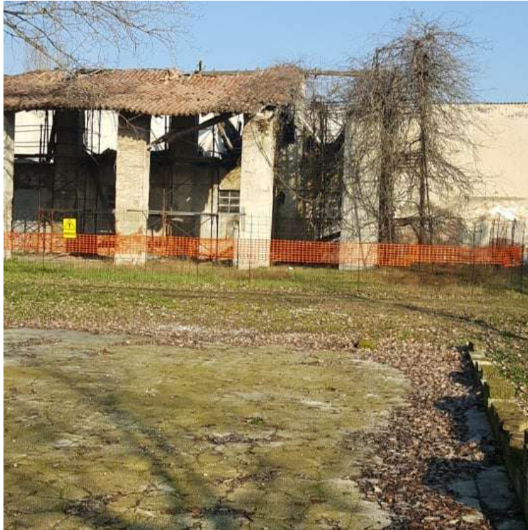
Figura 21: Foglio 24, mappale 143, sub. 2 - Vista da sud
