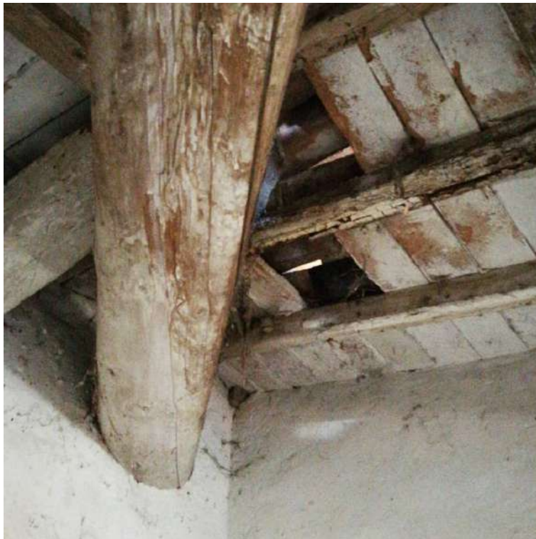
Figura 107: Foglio 24, mappale 143, sub.6 - soffitta
