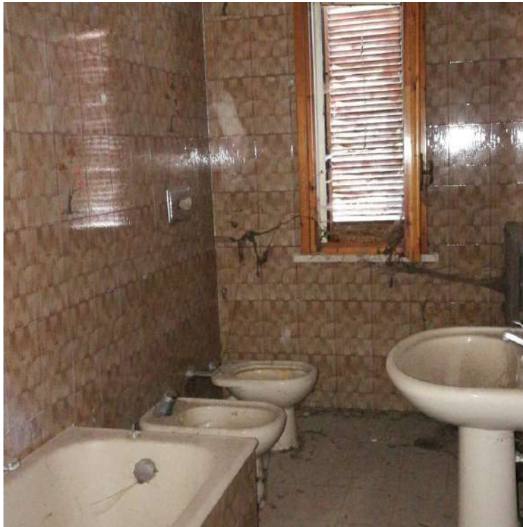
Figura 100: Foglio 24, mappale 143, sub.6 - bagno 2
