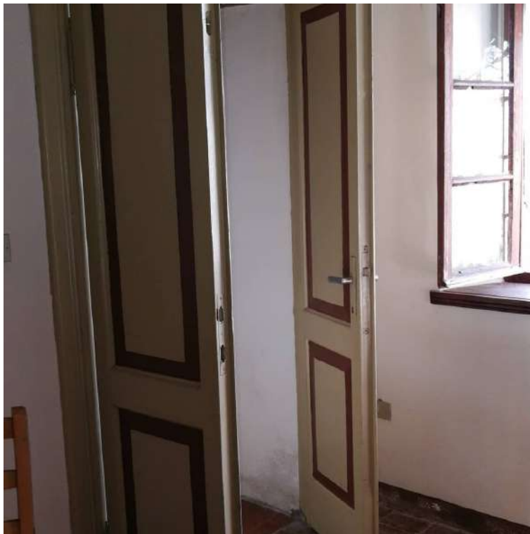
Figura 47: Foglio 24, mappale 143, sub.5 - Porta interna
