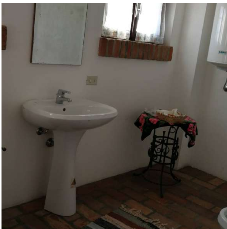
Figura 56: Foglio 24, mappale 143, sub.5 - bagno
