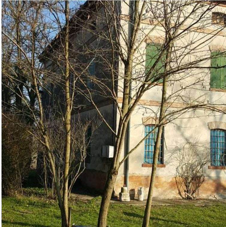
Figura 35: Foglio 24, mappale 143, sub.5 - esterno
