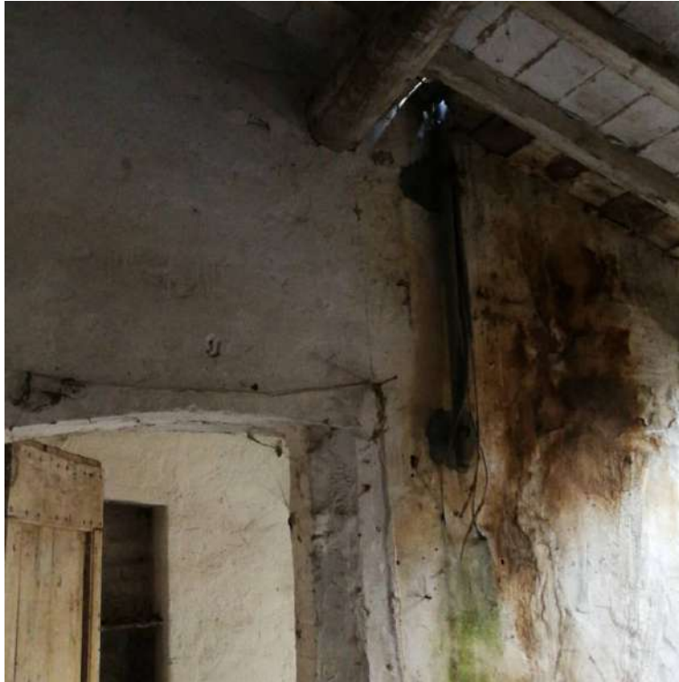
Figura 111: Foglio 24, mappale 143, sub.6 - soffitta
