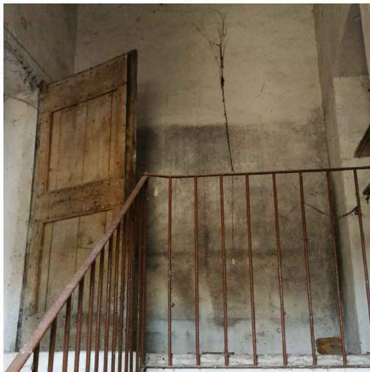
Figura 105: Foglio 24, mappale 143, sub.6 - pianerottolo soffitta
