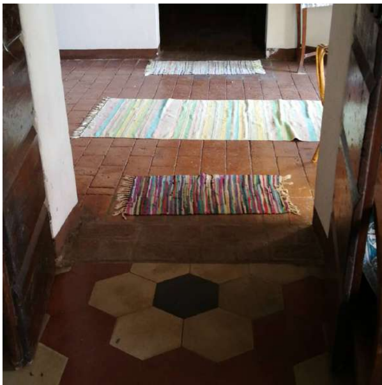
Figura 48: Foglio 24, mappale 143, sub.5 - Pavimento ingresso e soggiorno
