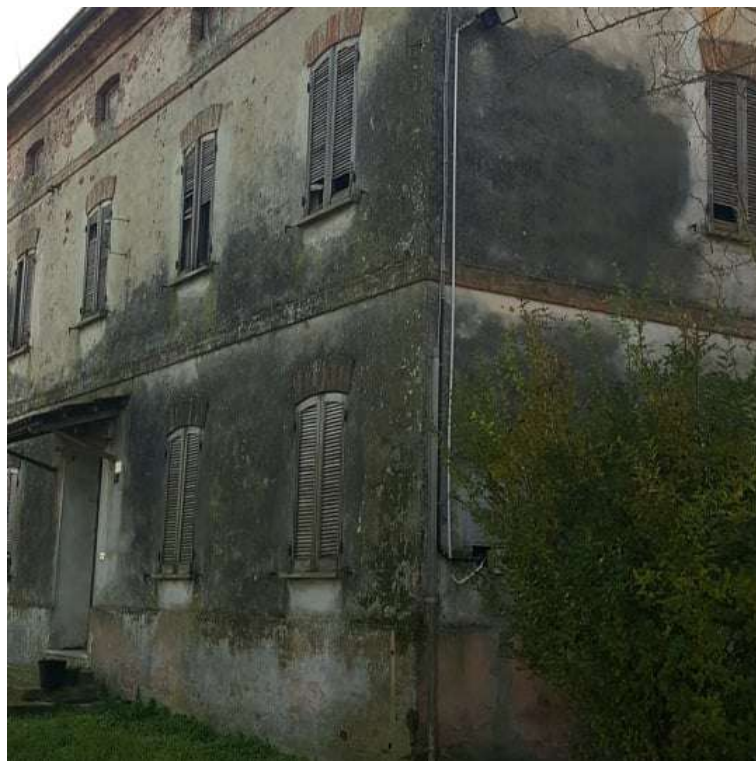
Figura 116: Foglio 24, mappale 143, sub.6 - esterno
