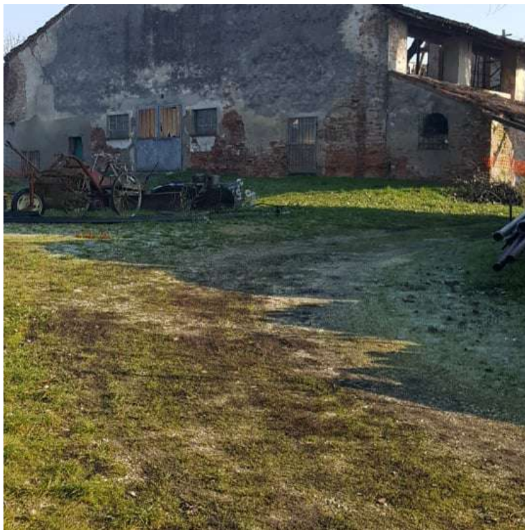
Figura 125: Foglio 24, mappale 143, sub.7 - area cortiliva (vista da ovest)
