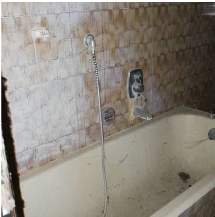
Figura 101: Foglio 24, mappale 143, sub.6 - bagno 2
