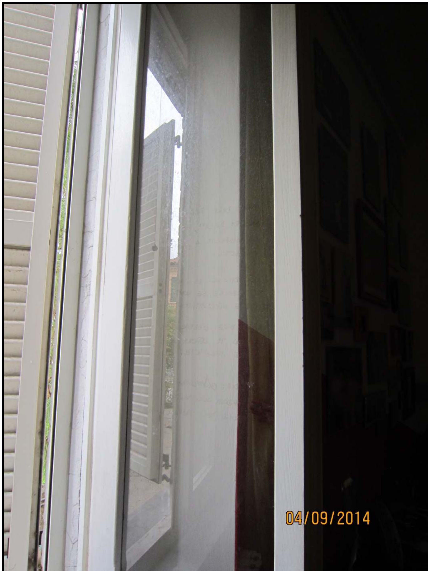
FOTO N. 13 – PARTICOLARE DEGLI INFISSI IN LEGNO CON VETRO SINGOLO
