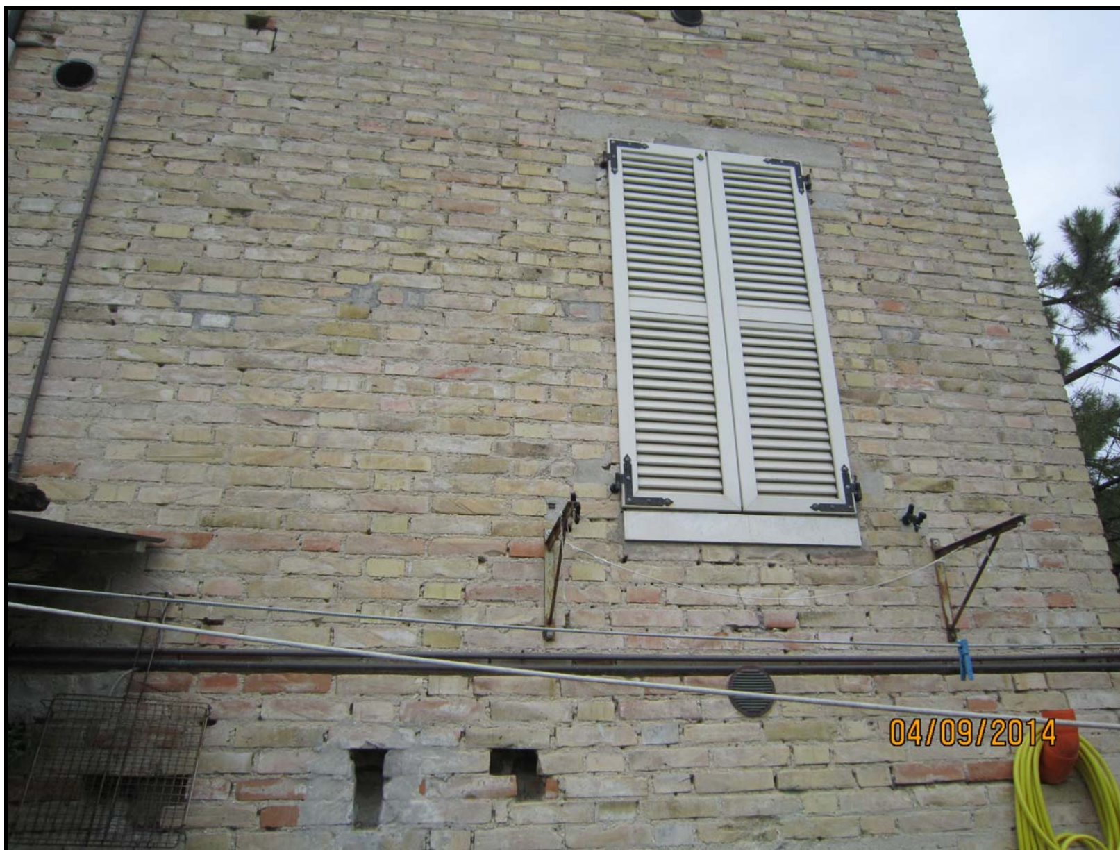
FOTO N. 5 – PARTICOLARE DELLA FACCIATA ESTERNA
