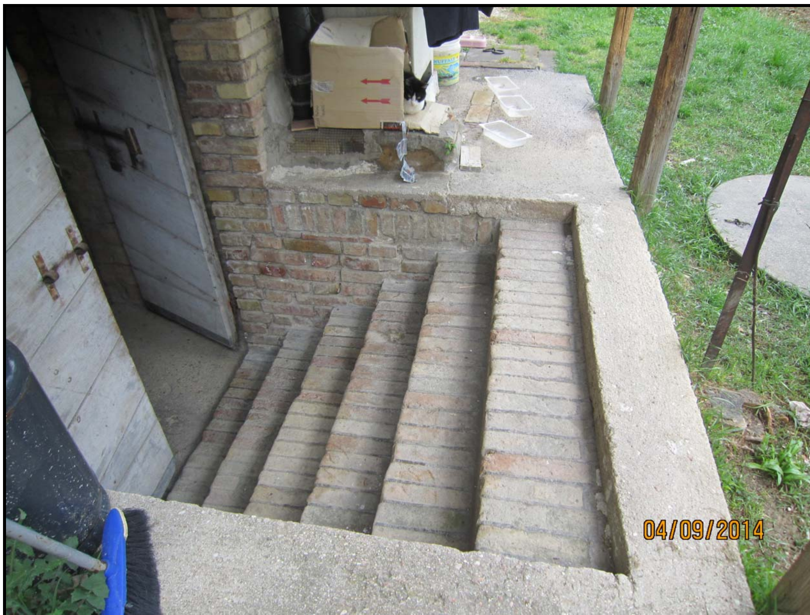
FOTO N. 16 – GRADINI CHE CONDUCONO ALLA CANTINA
