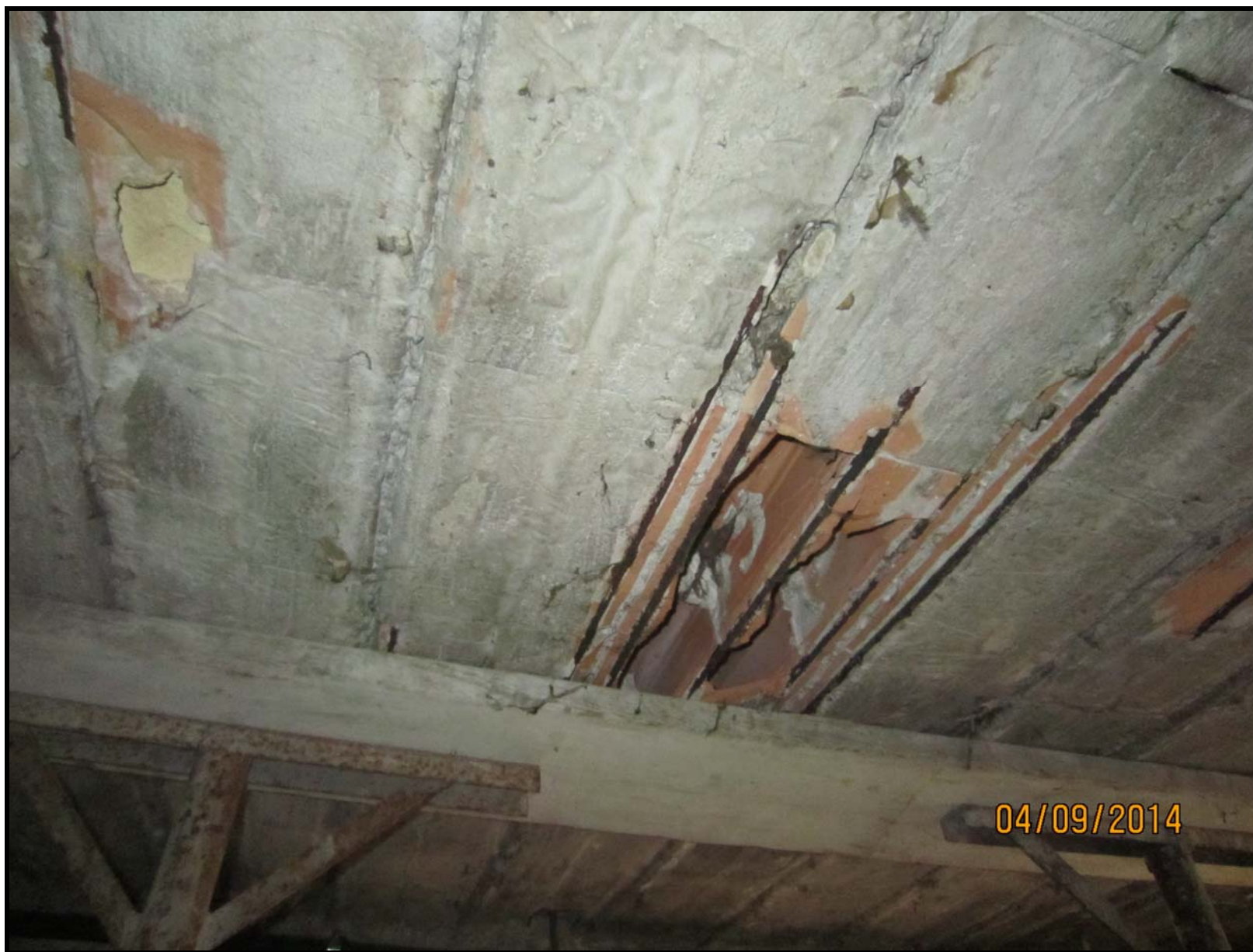
FOTO N. 18 – PARTICOLARE DEL SOLAIO DELLA CANTINA (SOLAIO DI CALPESTIO DELL'ABITAZIONE)
