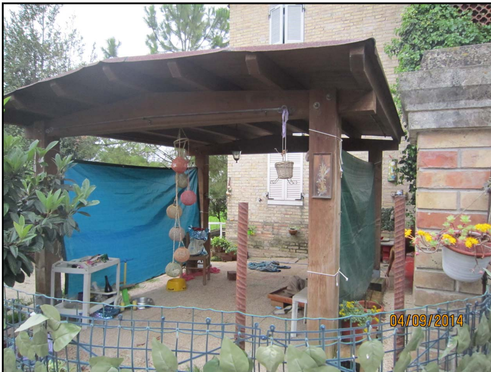
FOTO N. 2 - GAZEBO IN LEGNO POSTO NELLA CORTE DI PROPRIETA' ESCLUSIVA
