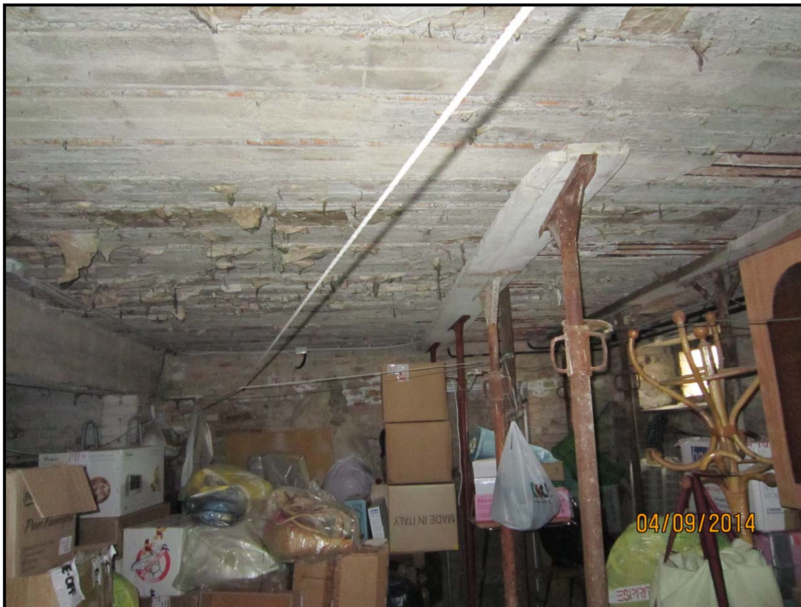
FOTO N. 17 – LOCALE CANTINA CON SOLAIO PUNTELLATO
