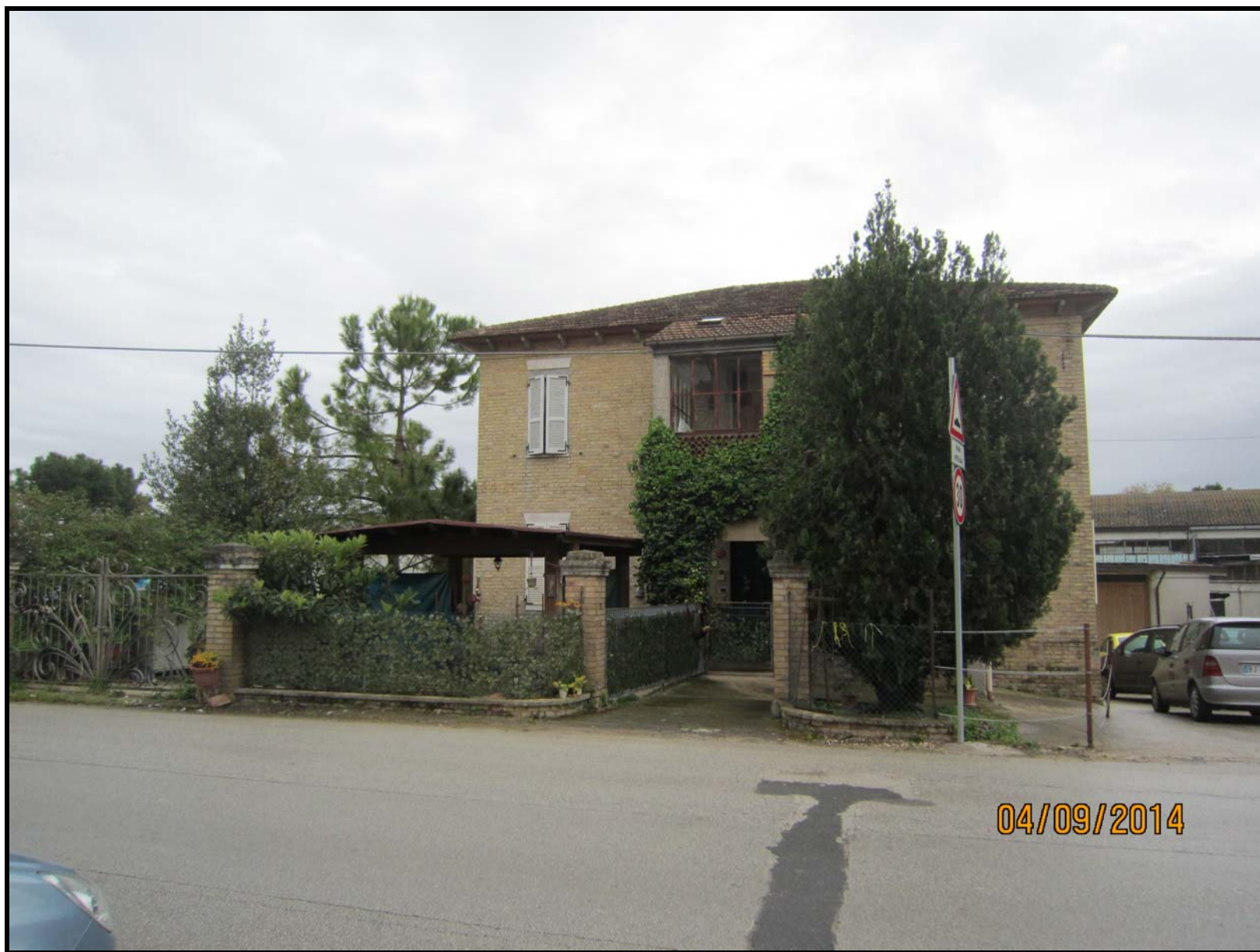
FOTO N. 1 - ESTERNO DELLO STABILE
