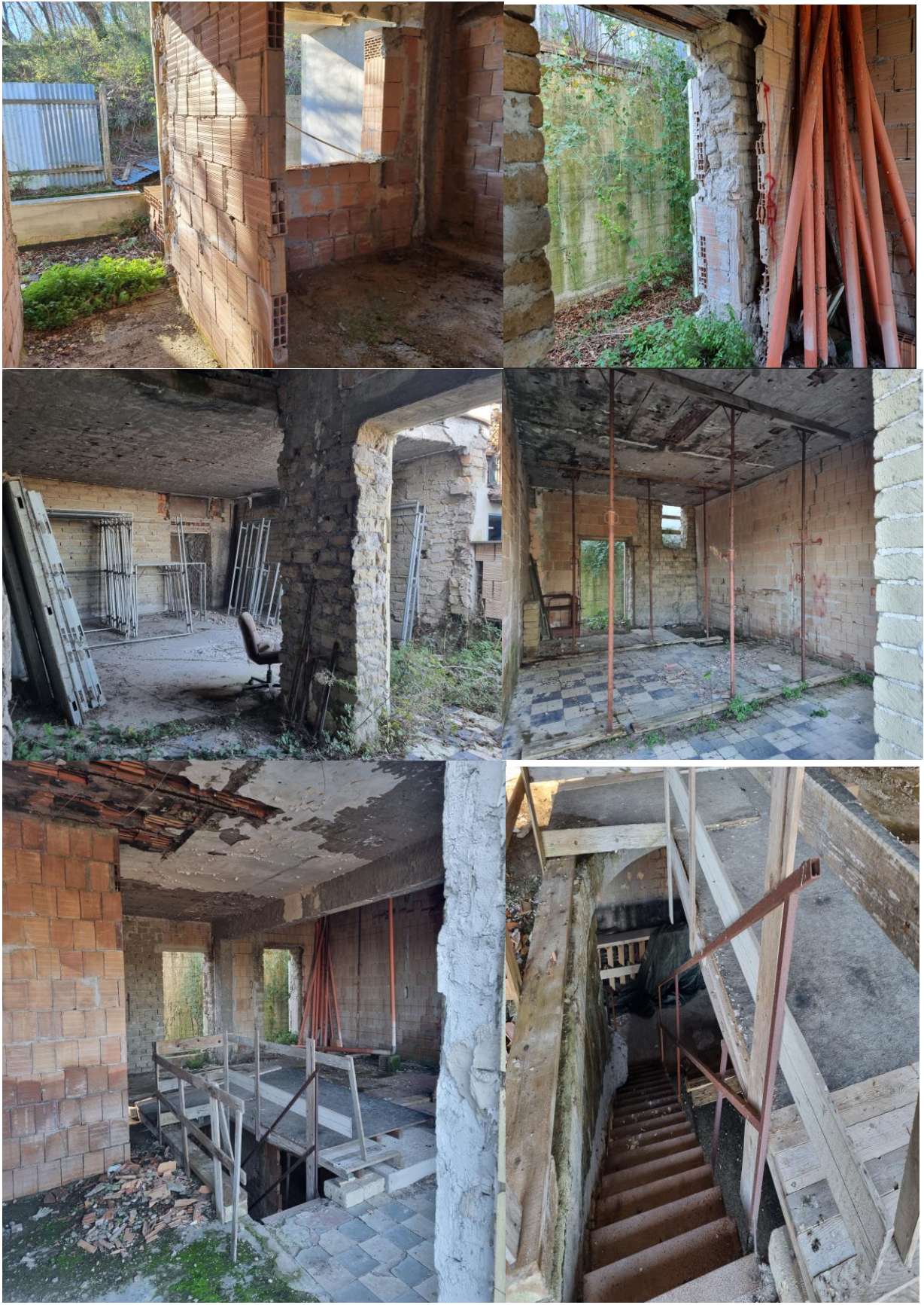
Figura 7: - Piano Terra- primo- secondo Stato dei lavori.
