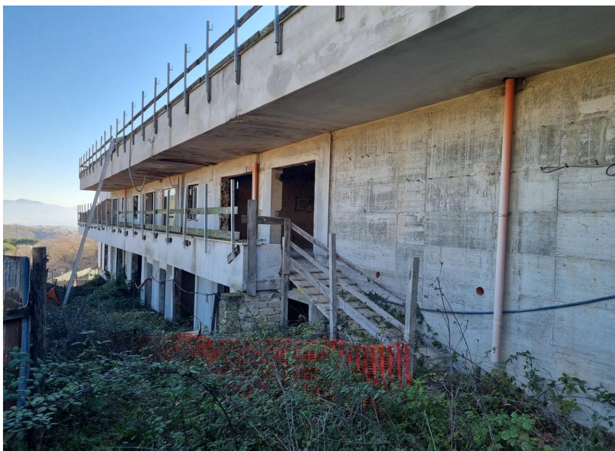
Figura 6: - Piano Terra- primo- secondo. Stato dei lavori.
