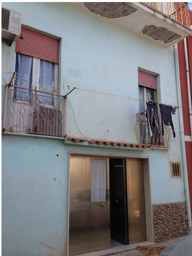
Foto 01: Vista prospetto Est prospiciente su Cortile di Via Vesuvio, da dove avviene l'accesso all'immobile.
