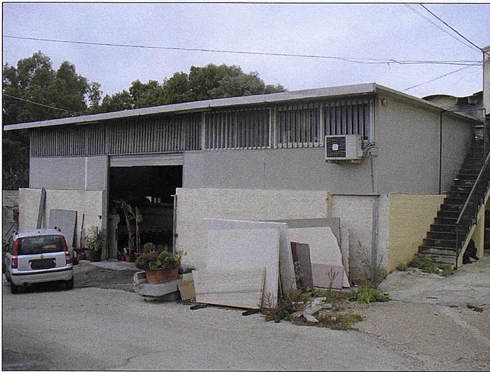
FOTO_1: L'IMMOBILE_VISTA ESTERNA
