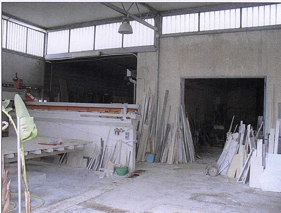
FOTO_4: L'IMMOBILE_VISTA INTERNA
