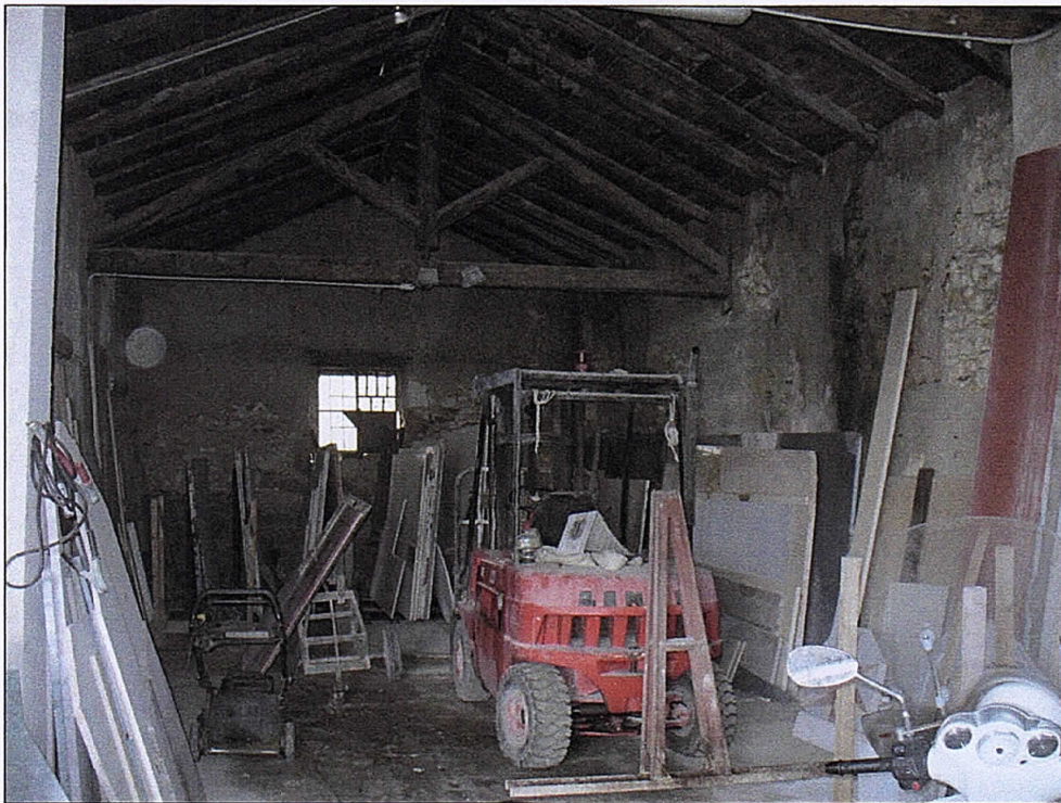
FOTO_3: L'IMMOBILE_VISTA INTERNA
