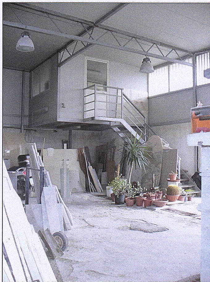
FOTO_2: L'IMMOBILE_VISTA INTERNA
