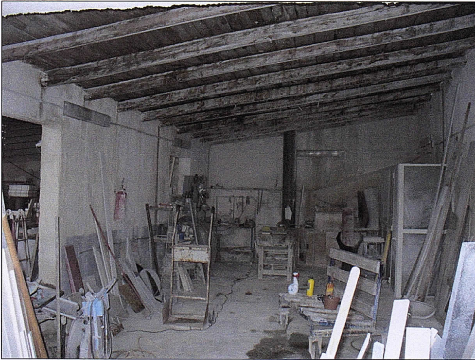
FOTO_5: L'IMMOBILE_VISTA INTERNA
