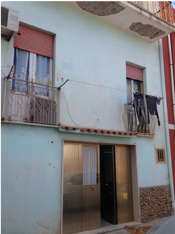
Foto 02: Vista prospetto Est prospiciente su Cortile di Via Vesuvio.
