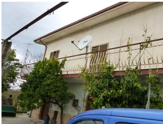
Fig. 1 – Prospetto principale fabbricato F-1 della porzione oggetto di stima
