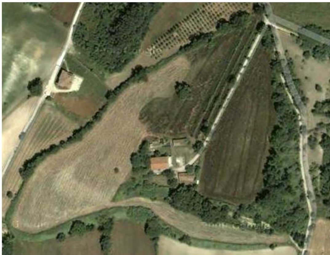
Fig. 5 – Ubicazione della strada privata di accesso alla corte comune e agli immobili; vista aerea
