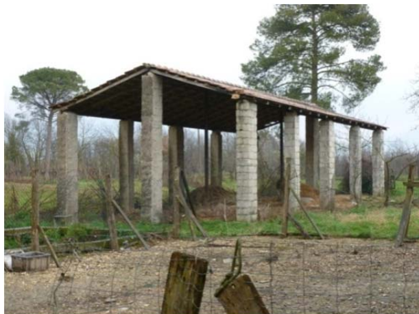
Fig. 6a) – Vista del Fienile - Rimessa , Fabbricato F.2
