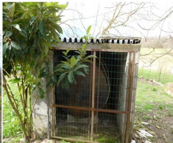
Fig. 6b) – Vista del Locale tecnico del serbatoio per gasolio caldaia; fabbricato F.2
