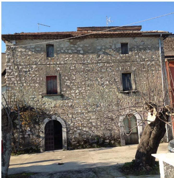
Fig. 20 – Prospetto principale fabbricato F.5 (F.11 Mapp. 115 sub 7)
