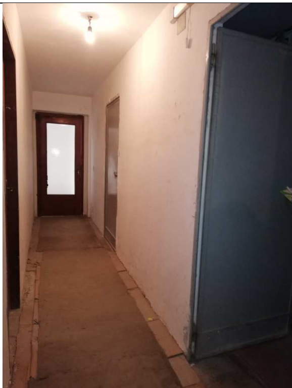
FOTO N.15 – CORRIDOIO DI ACCESSO AL BOX DAL VANO SCALA CONDOMINIALE
