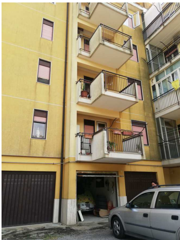
FOTO N.13 – PROSPETTO INTERNO DELL'EDIFICIO
