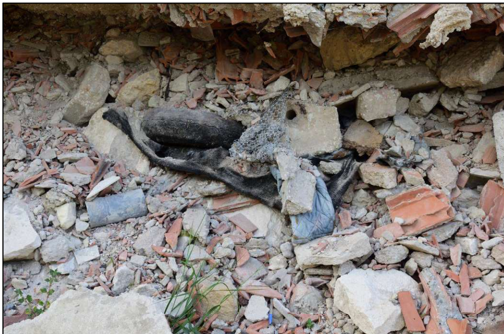
Foto 3 _Materiale costituente il riempimento
