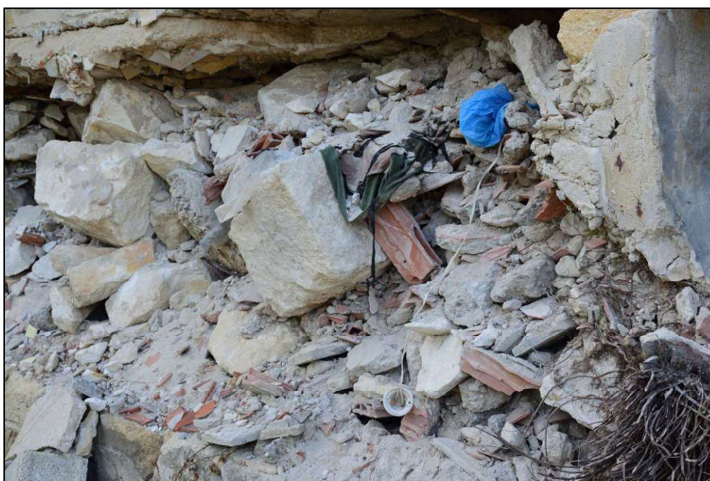
Foto 4 _Materiale costituente il riempimento
