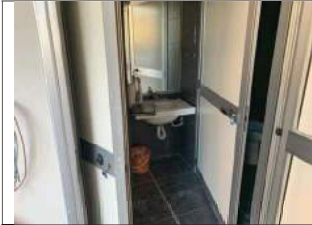
Vista interna del locale commerciale – bagno
