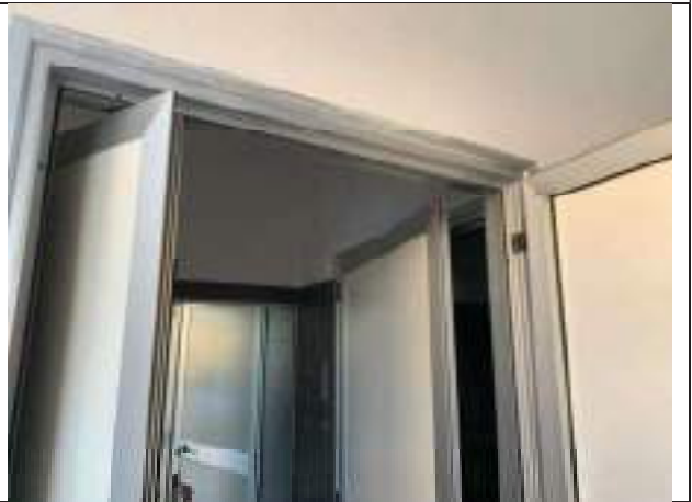
Vista interna del locale commerciale – infissi
