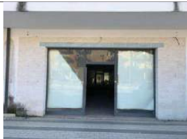
Vista dell'accesso dalla corte esterna
