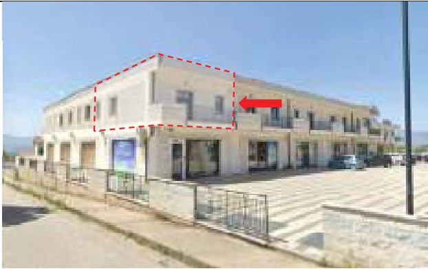
Vista generale del compendio di immobili con individuazione del cespite n. 2
