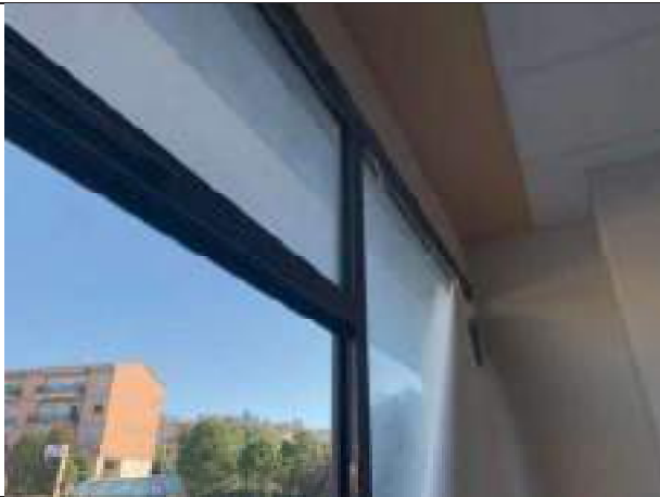
Vista interna del locale commerciale – infissi
