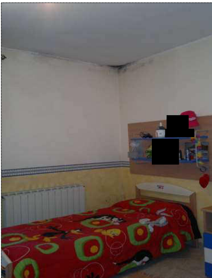
Foto N.20 Porzione Vano cameretta secondo piano
