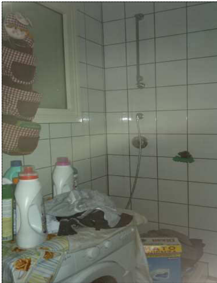
Foto N.35 Vista Vano bagno - lavanderia
