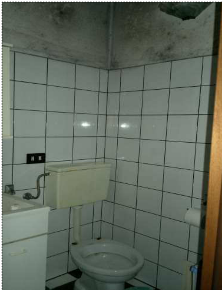
Foto N.36 Vano bagno - lavanderia terzo piano
