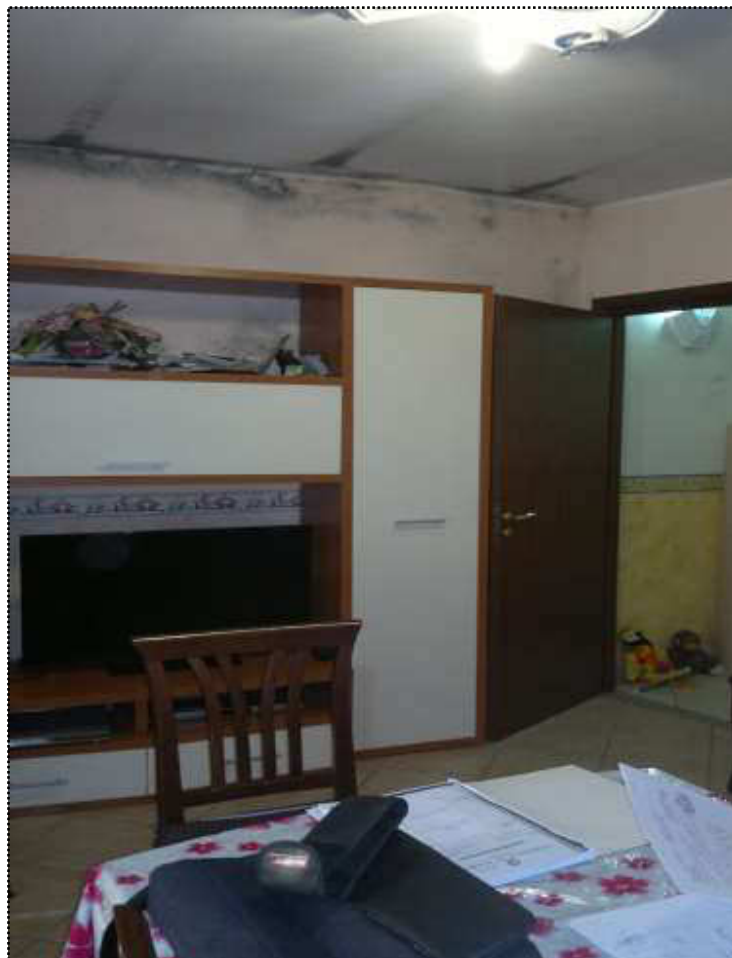
Foto N.32 Porzione Vano pranzo
