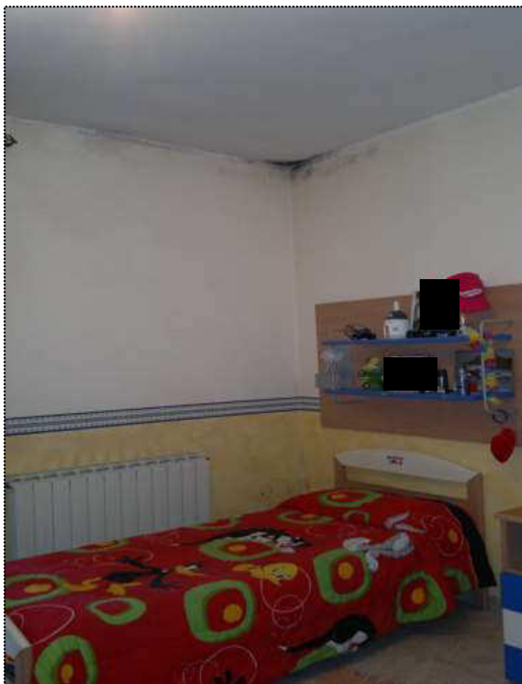
Foto N.20 Porzione Vano cameretta secondo piano
