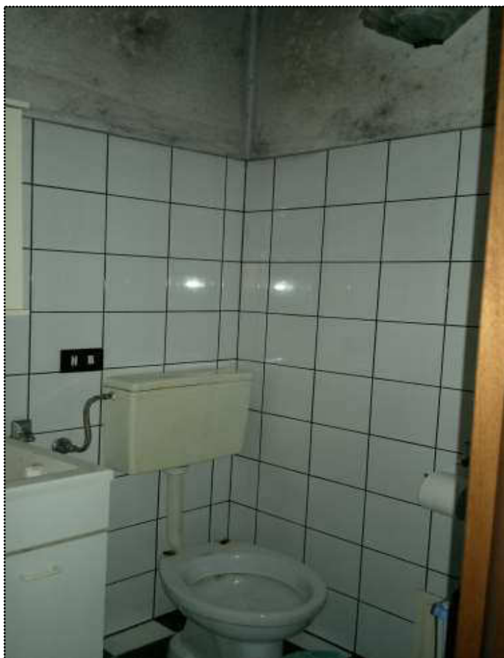
Foto N.36 Vano bagno - lavanderia terzo piano
