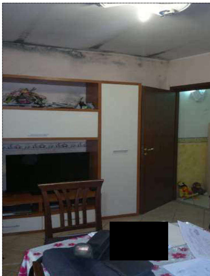
Foto N.32 Porzione Vano pranzo
