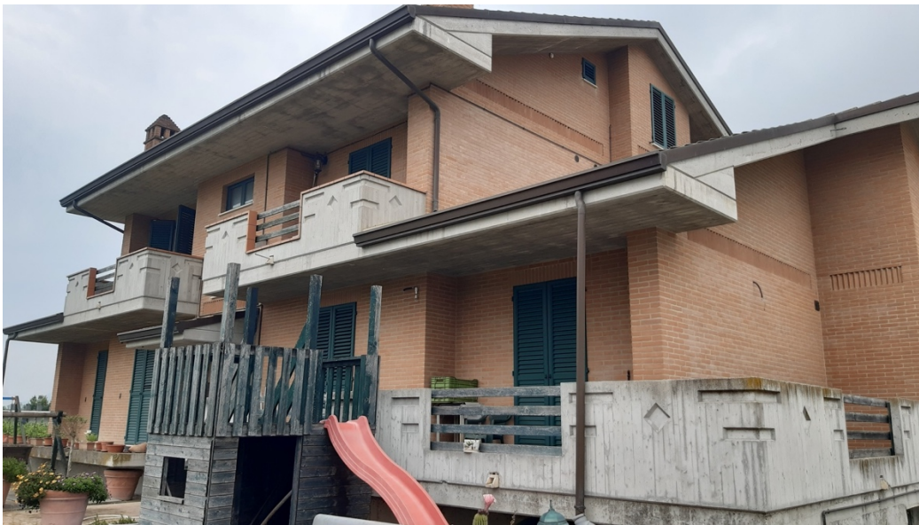
Figura 1 Facciata intero immobile
