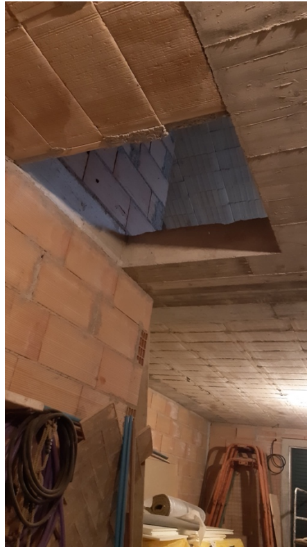
Figura 18 Predisposizione collegamento piano terra con piano primo
