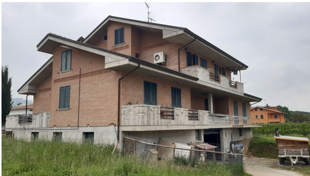
Figura 2 Facciata intero immobile
