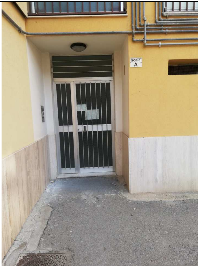
FOTO N.5 – PORTONE DI INGRESSO AL VANO SCALA
