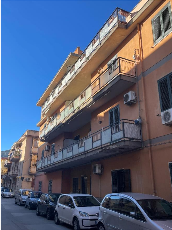
Prospetto dell'edificio sulla via Pietro Perricone
