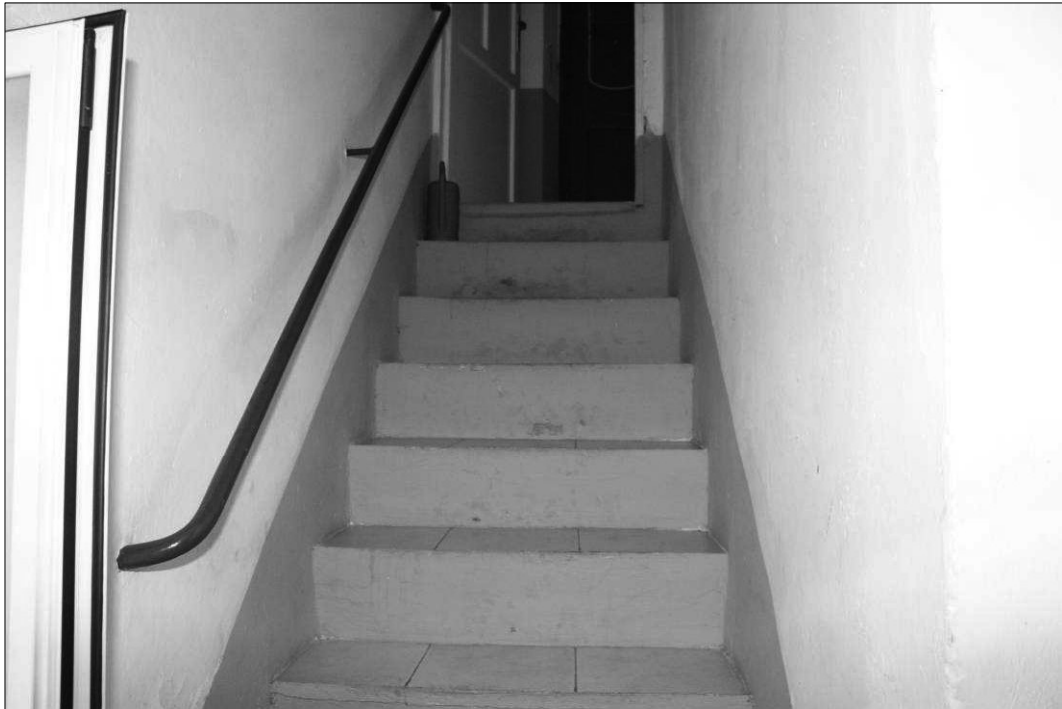
FOTO 21: Scala verso Piano Sottostrada
