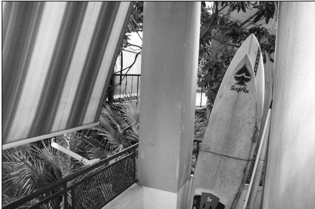
FOTO 20: Terrazza Lato Nord-Est
