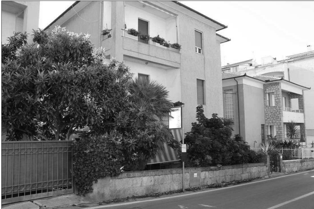
FOTO 1 – Fabbricato lato Nord-Est
