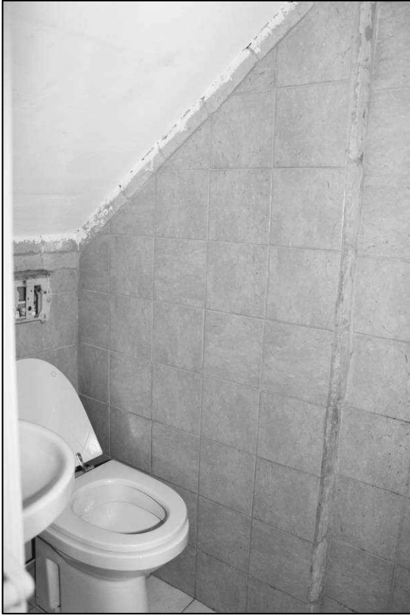
FOTO 23: Servizio igienico Sottoscala
