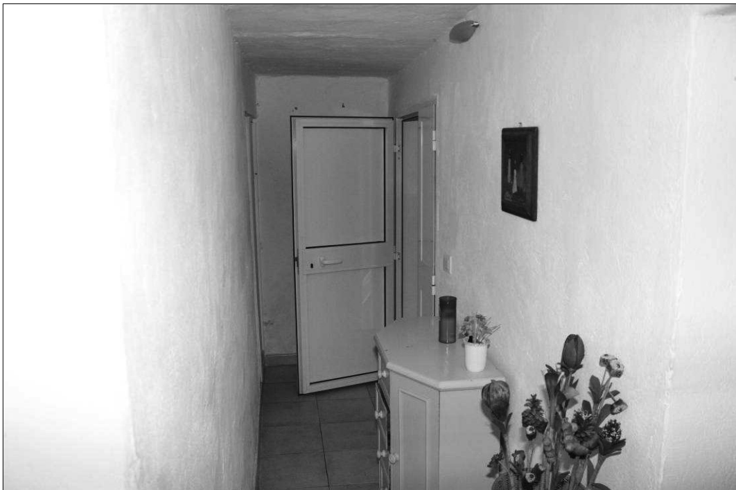
FOTO 22: Corridoio Piano Sottostrada
