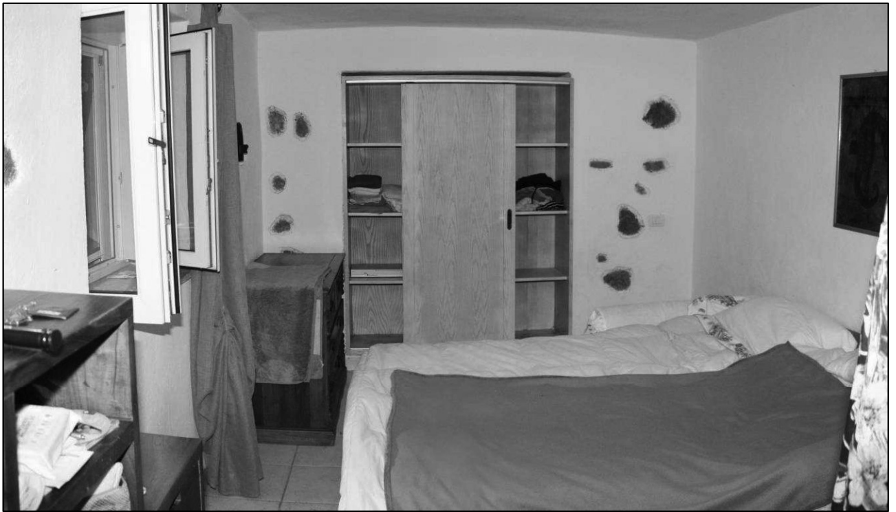
FOTO 28: Locale Piano Sottostrada
