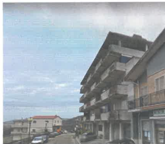
Foto Google Street View – gen. 2011 © (prima del rifacimento delle facciate)
