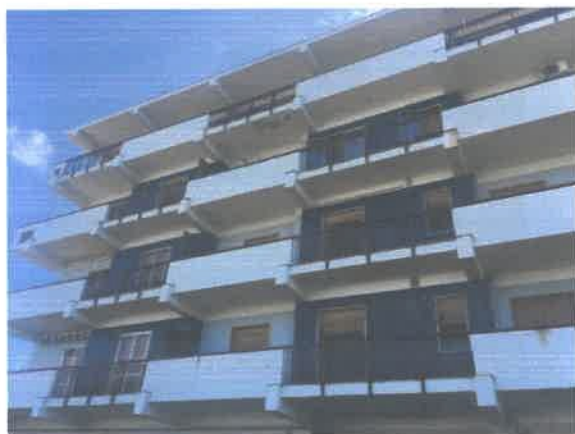
Foto 2020 del rilevatore: stato attuale della facciata
