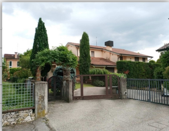
FOTO 6: RILIEVO FOTOGRAFICO INTERO EDIFICIO
