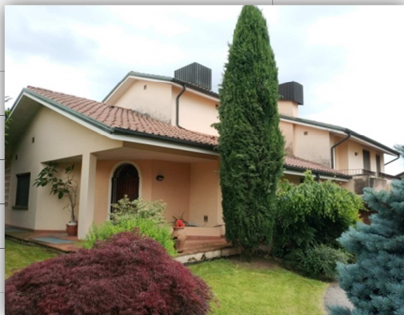
FOTO 7: RILIEVO FOTOGRAFICO INTERO EDIFICIO
