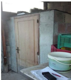
locaie rimessa attrezzi/ripostiglio esterno
