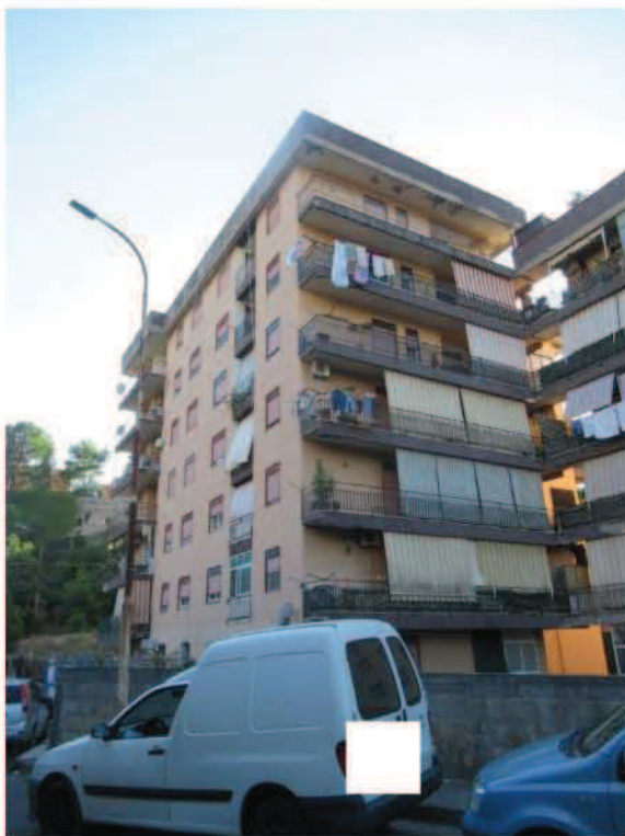
Foto 3_ Vista Nord fabbricato
