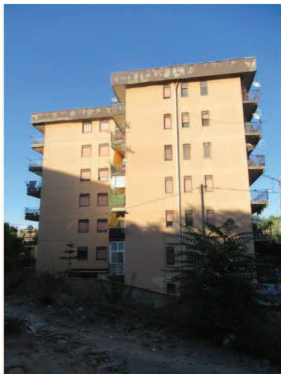
Foto 2_ Vista Sud fabbricato
