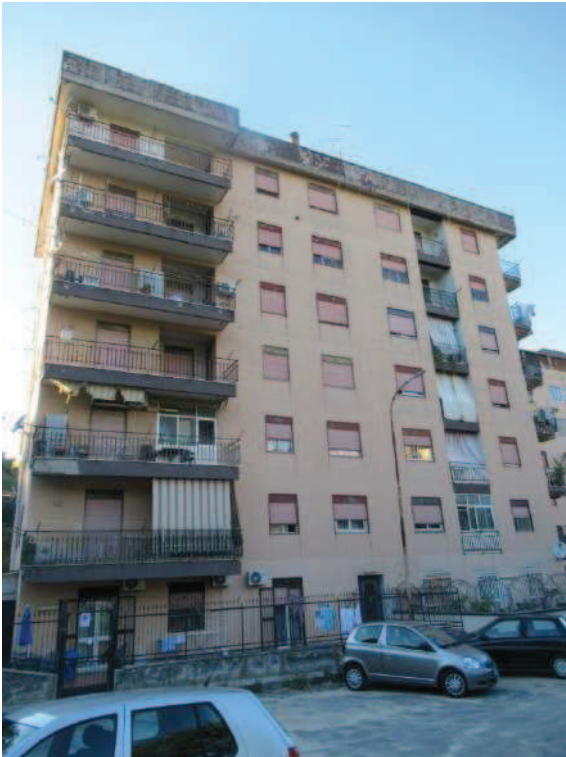
Foto 5_ Prospetto principale fabbricato
