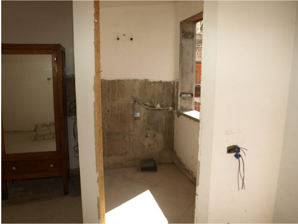
Foto n° 5 – Appartamento per civile abitazione sito in Gela con ingresso dalla via Dinomane n° 18, terzo piano – Foglio 187 part. 1057 sub 6 – Panoramica degli interni.
