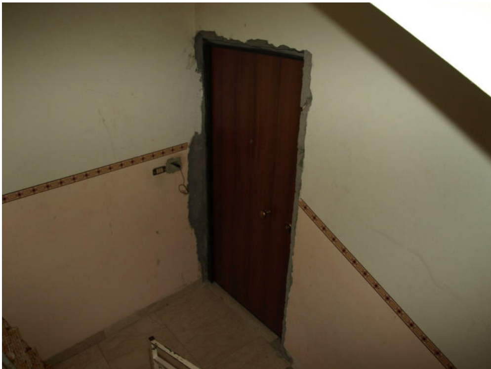
Foto n° 12 – Appartamento per civile abitazione sito in Gela con ingresso dalla via Dinomane n° 18, terzo piano – Foglio 187 part. 1057 sub 6 – Panoramica del portoncino d'ingresso.
