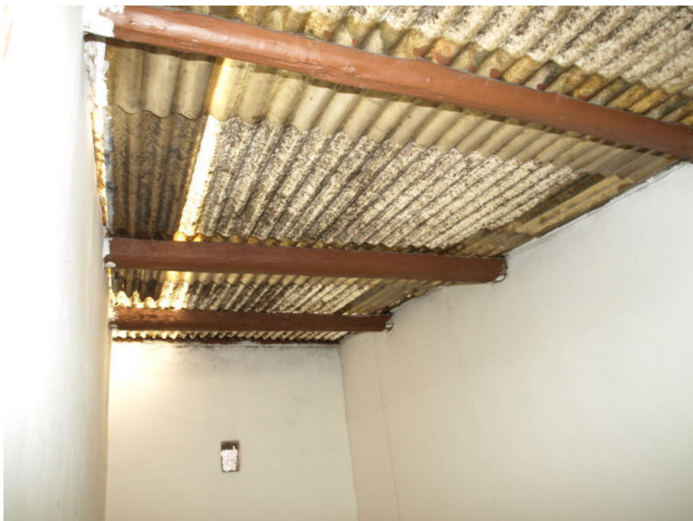
Foto n° 25 – Appartamento per civile abitazione sito in Gela con ingresso dalla via Dinomane n° 18, terzo piano – Foglio 187 part. 1057 sub 7 – Panoramica della copertura del vano scala.
