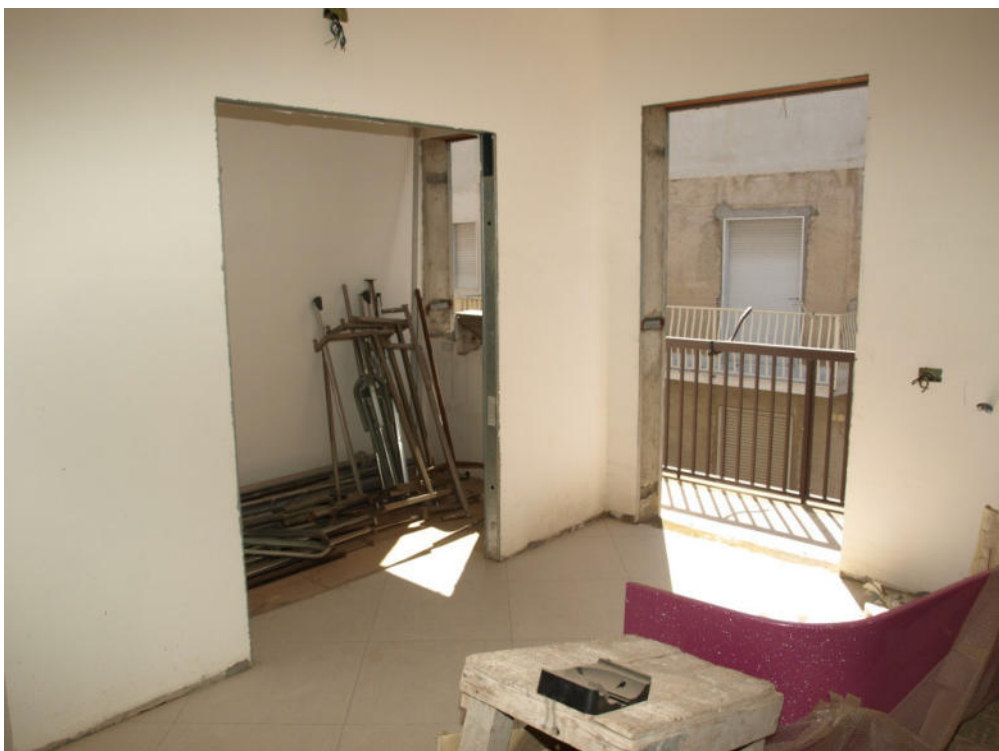
Foto n° 7 – Appartamento per civile abitazione sito in Gela con ingresso dalla via Dinomane n° 18, terzo piano – Foglio 187 part. 1057 sub 6 – Panoramica degli interni.
