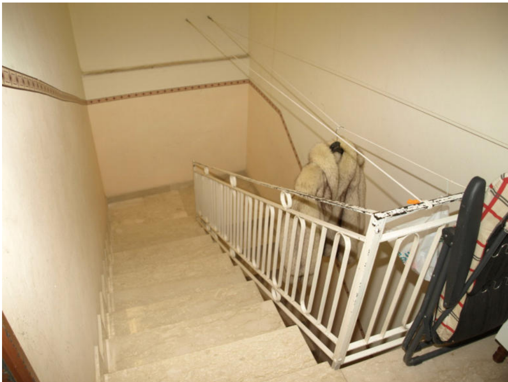
Foto n° 24 – Appartamento per civile abitazione sito in Gela con ingresso dalla via Dinomane n° 18, terzo piano – Foglio 187 part. 1057 sub 7 – Panoramica del vano scala.
