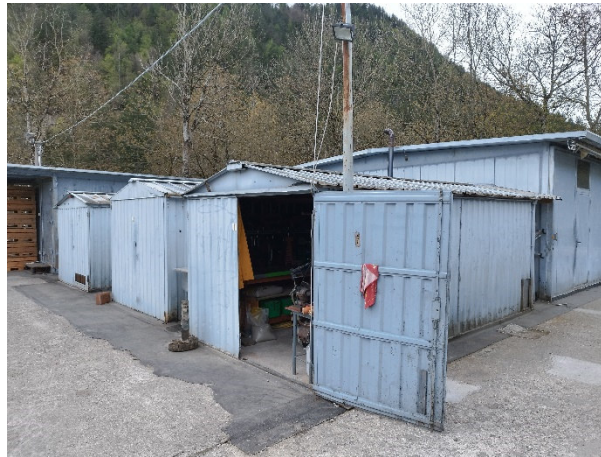
Particolari depositi, magazzini e cella frigo mappale 972
