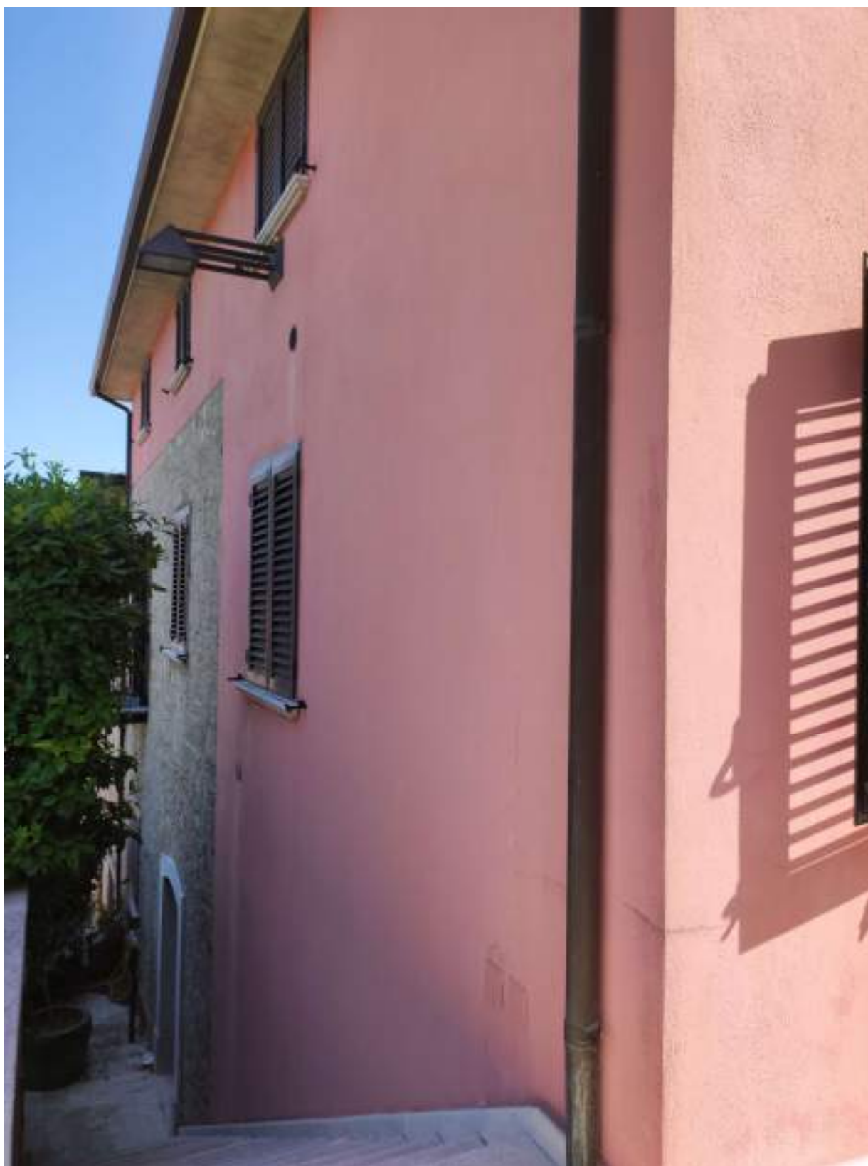
Foto 4 Esterno abitazione con accesso al locale seminterrato
