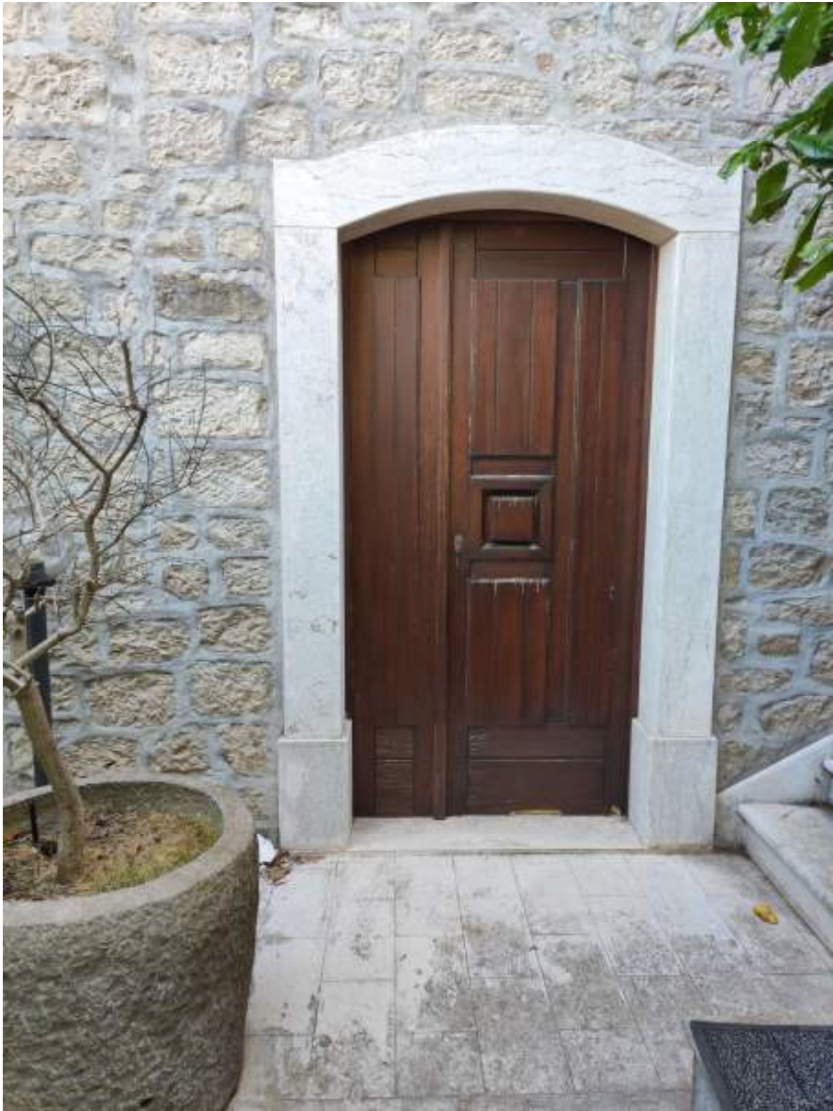
Foto 5 Porta di accesso al locale seminterrato
