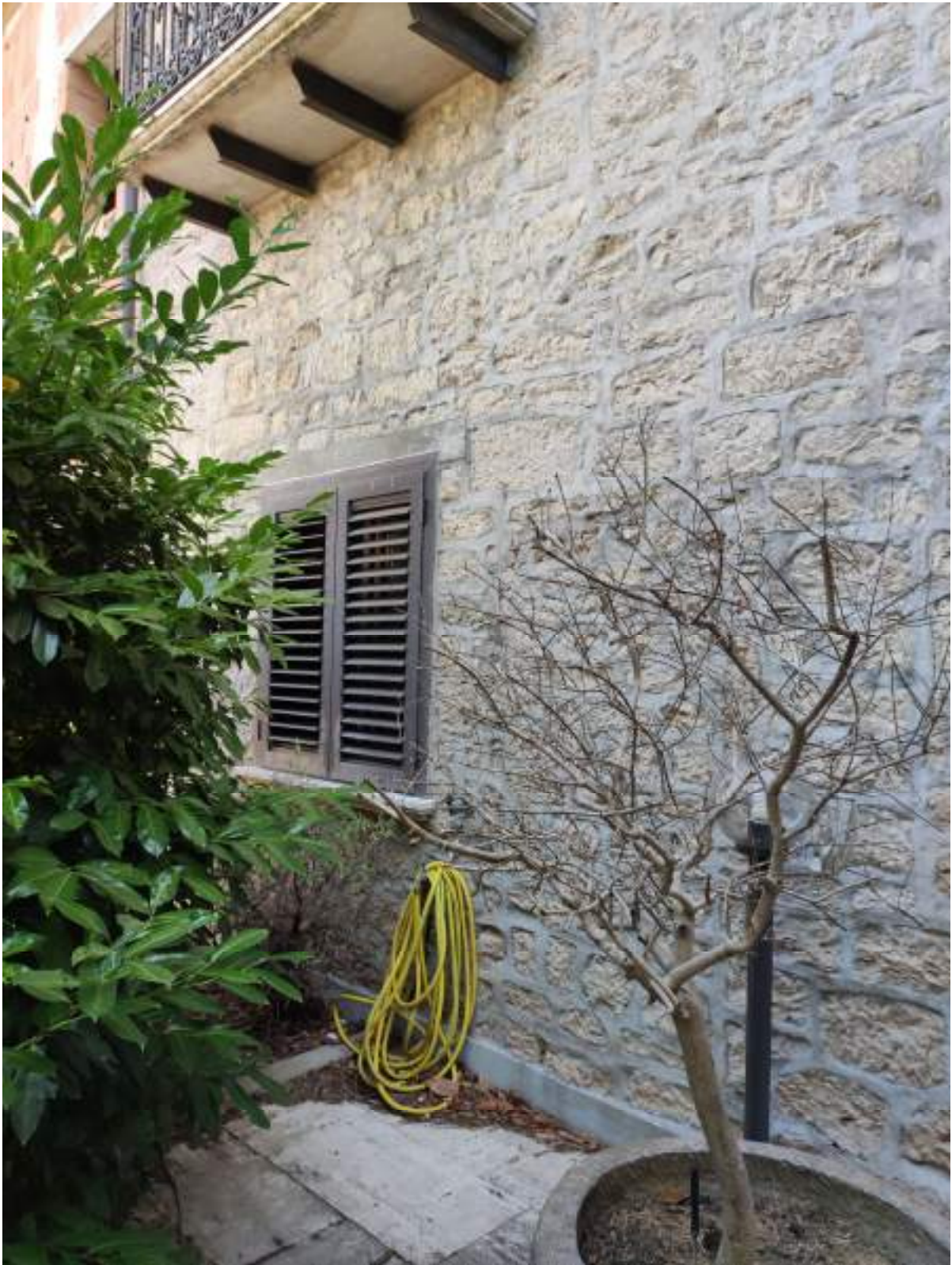
Foto 6 Finestra del Locale seminterrato
