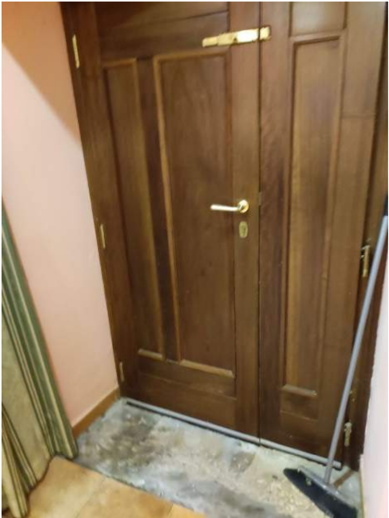
Foto 35 Porta di ingresso n°1 (Piano Seminterrato)
