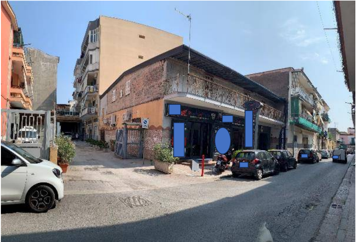
FOTO 1 - Vista del fabbricato dalla via L. Cadorna
