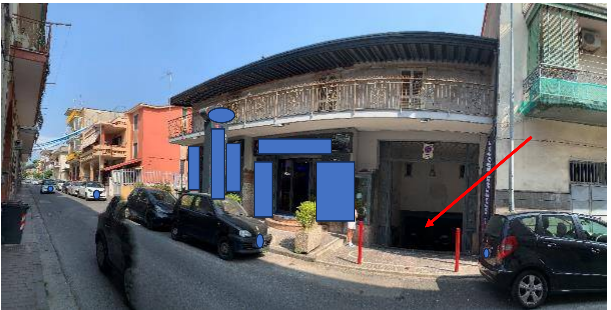
FOTO 2 - Vista del fabbricato dalla via L. Cadorna
