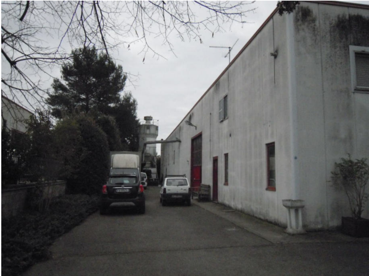
vista lato nord (area sub.4 e lato lungo dell'edificio)
