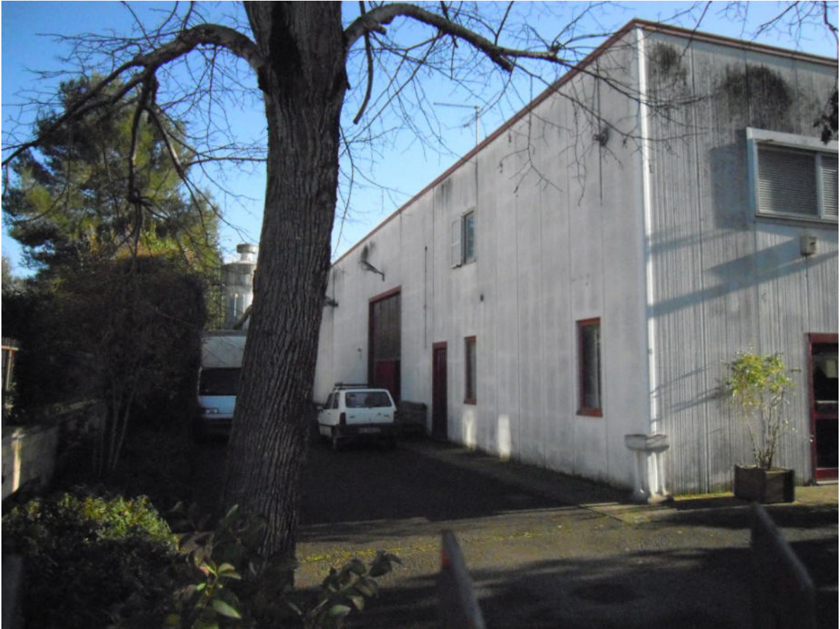
vista prospetto nord e ingresso al laboratorio sub.2
