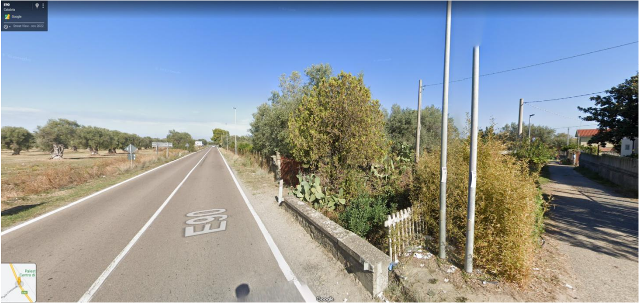
VISTA DELL'INGRESSO AL LOTTO DALLA S.S. 106
