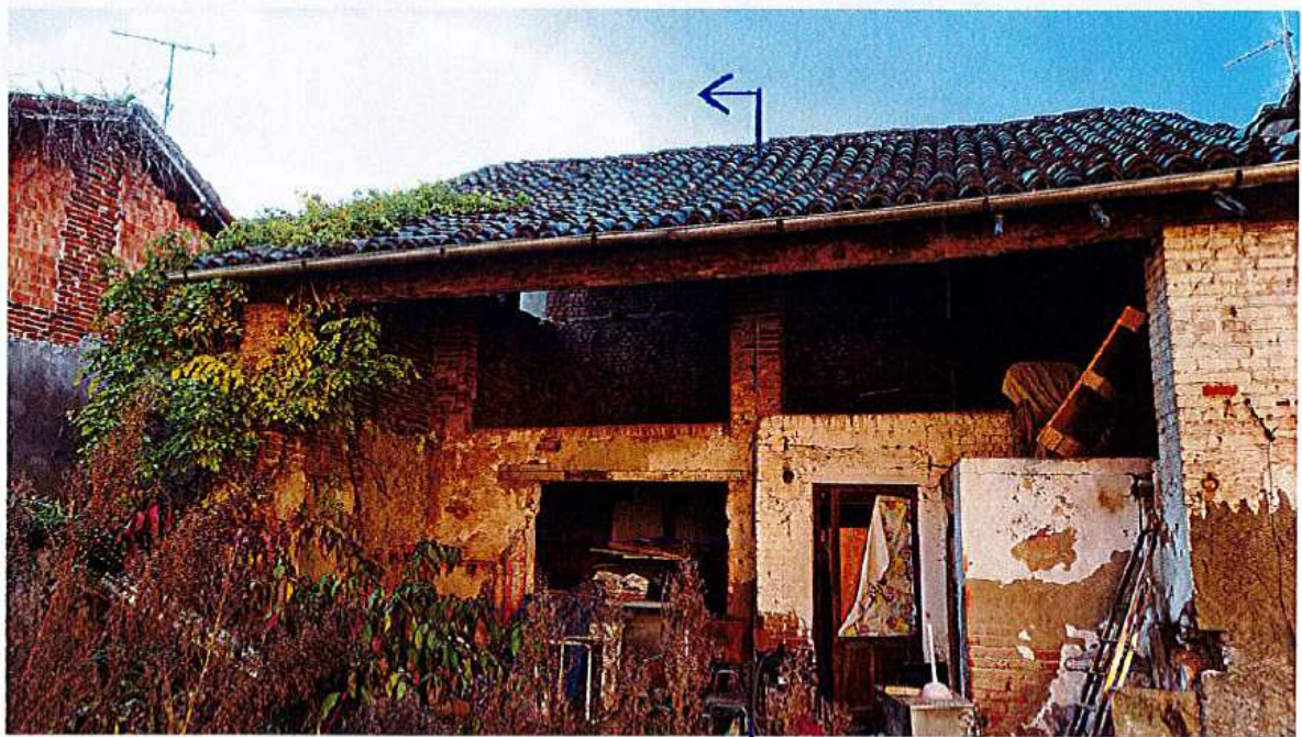
Prospetto porzione di rustico dal cortile
