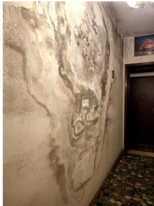
Corridoio con evidenti macchie di umidità sulla parete in adiacenza ad altro immobile
