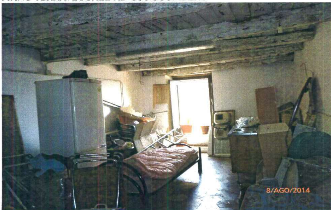
PIANO TERRA: LOCALE AD USO SGOMBERO
