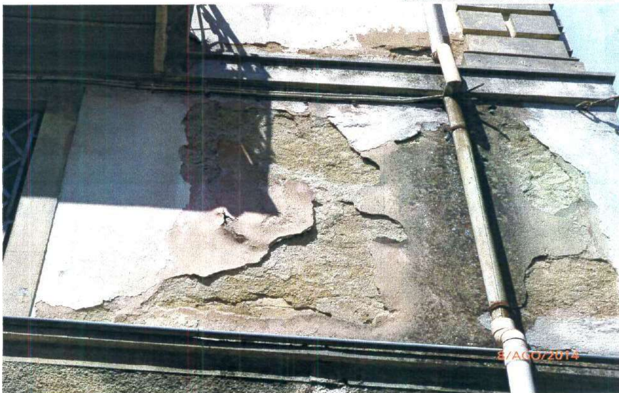
STATO DELL'INTONACO
